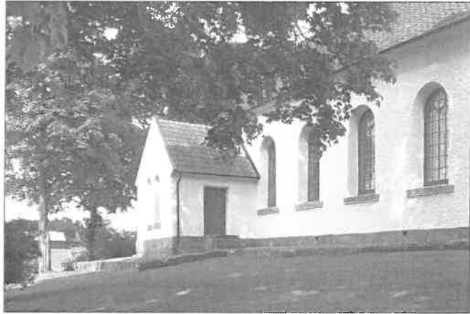
Kyrkans nordvästra parti med sakristia mot väster. Notera den lilla grustäckta platån med låga stödmurar som omgärdar kyrkan i sin helhet.
