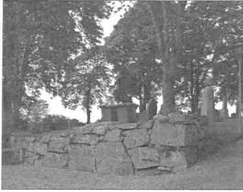
Parti av stödmur invid södra entrén. Till höger i bild ses en av grindstolparna och till vänster en del av parkeringen söder om kyrkogården.
