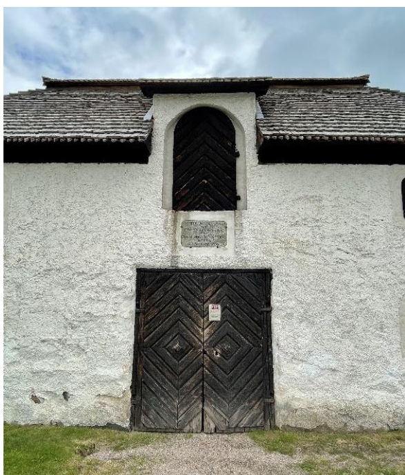
Ovan t.v. Sockenmagasinet vid Götlunda kyrka utmärker sig i både ålder och byggnadssätt. Det är det enda i länet som är murat och putsat. Ovan t.h. Fläckebos sockenmagasin är en del av en miljö kring kyrkan med bodar och kyrkstallar som är byggnadsminnesförklarade.
