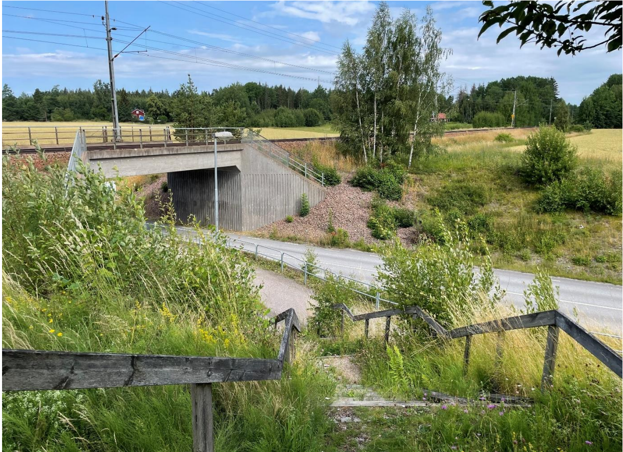
Järnväg och trappa ner till vägen.
