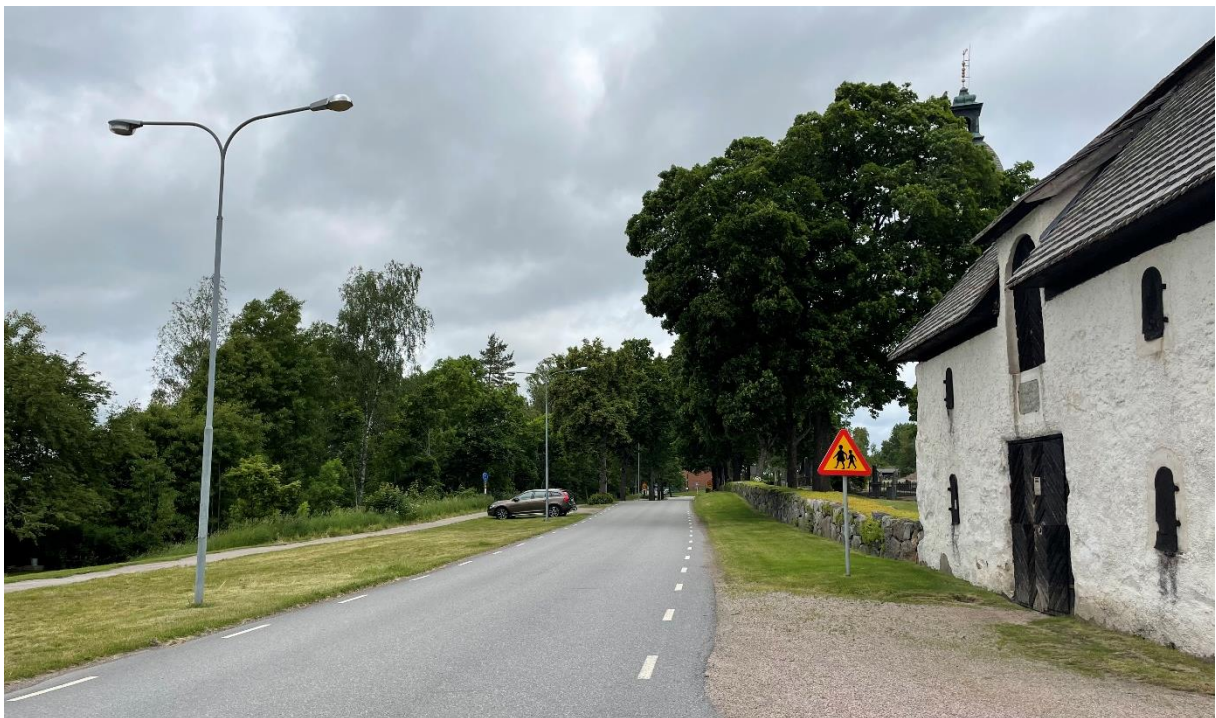
Sockenmagasin intill kyrkogård och äldre vägsträcka.
