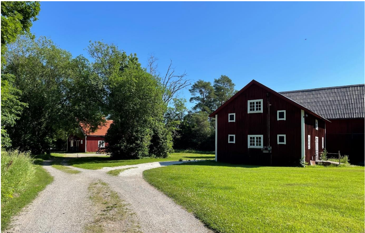
Arrendatorsbostad och ekonomibyggnader.
