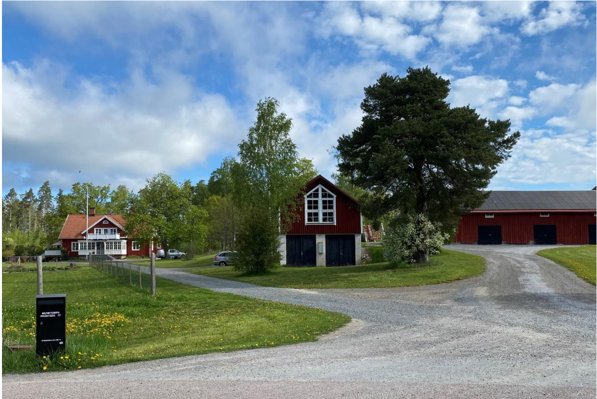
Före detta arrendatorsbostad med ekonomibyggnader.
