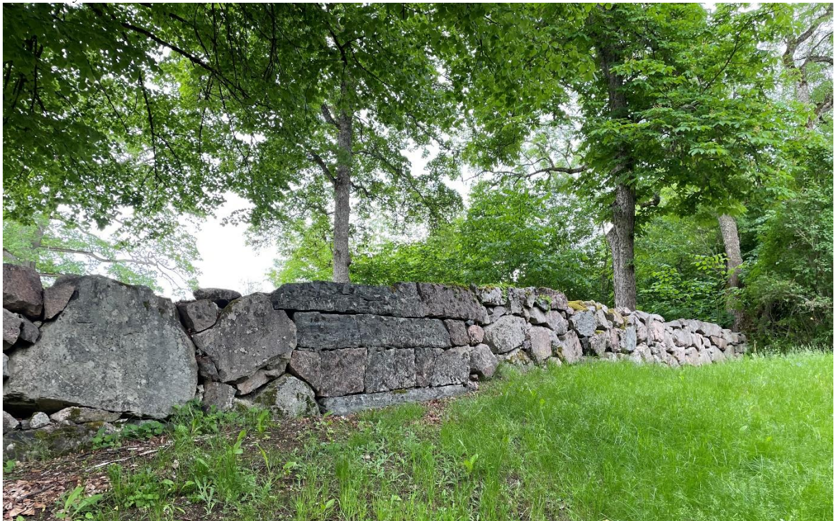
Del av bogårdsmur där en öppning mot prästgården tidigare fanns.
