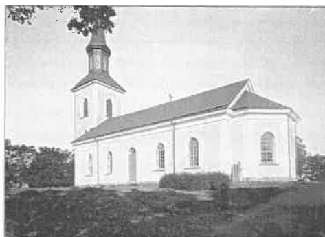
Ovan: Vy över Blidsbergs kyrka från sydost år 1914. Foto: Anders Roland, Bildarkivet, VGM. Nedan: Vy över kyrkogården och kyrkan från nordväst år 1938. Notera det stora antalet gravvårdar med grusbädd. Foto: Anders Granqvist, Bildarkivet, VGM.
