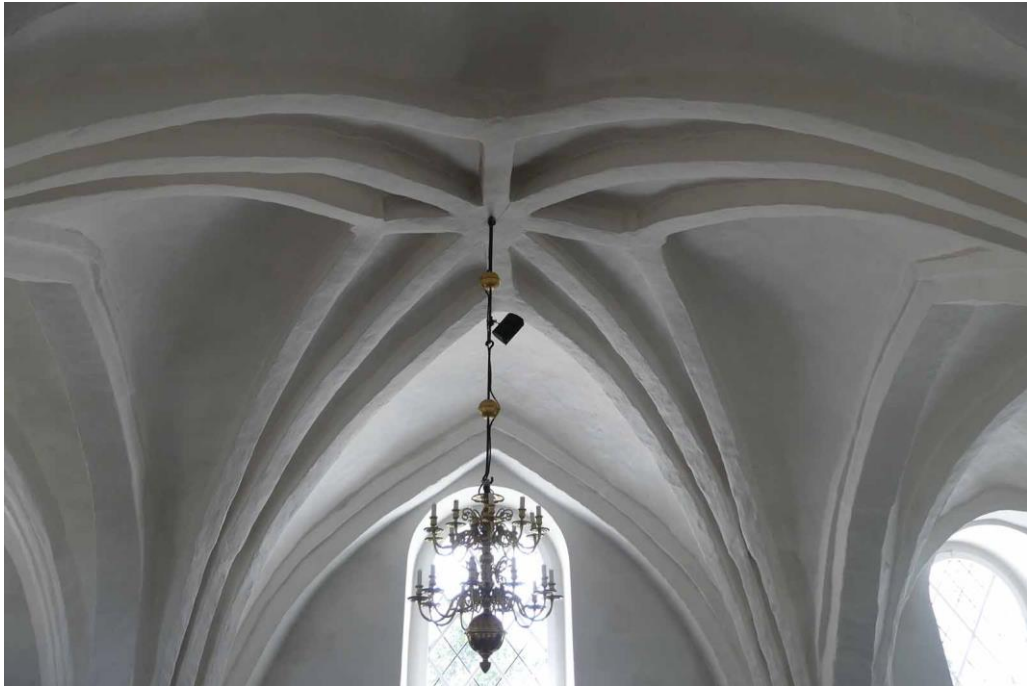
Stjärnvalvet över långhuset tros vara slaget kring 1400.
