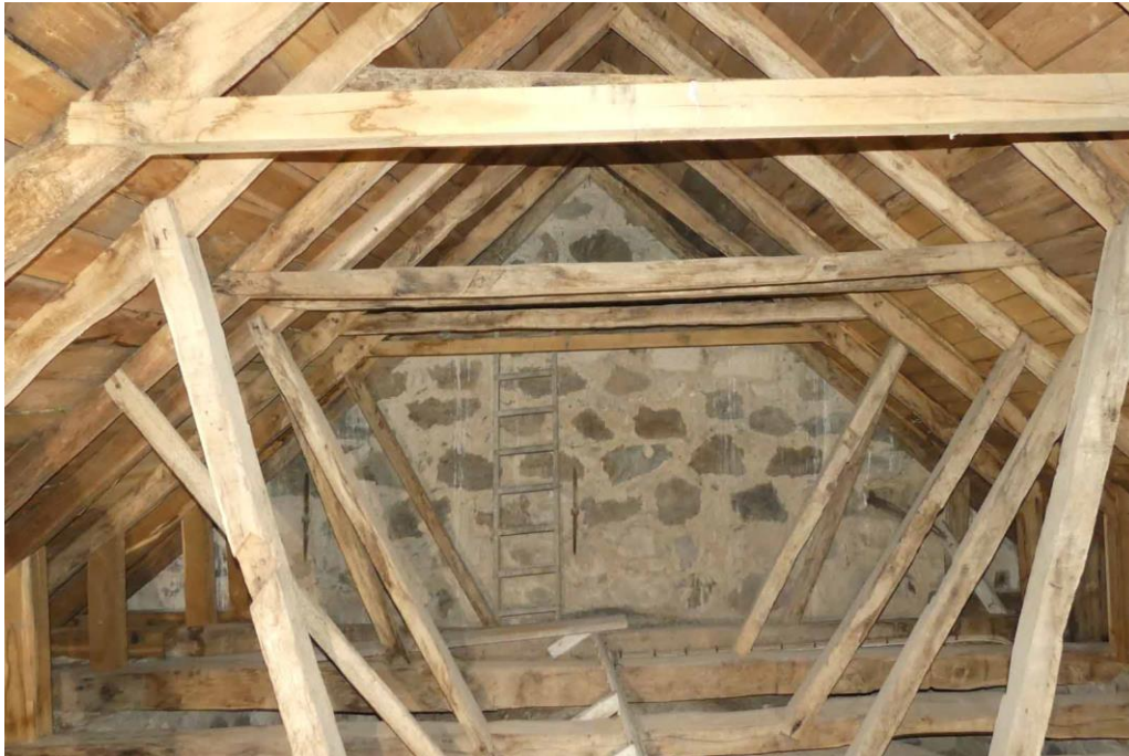
Del av långhusets taklag sett mot väster. Murverket i väster tillhör tornet.
