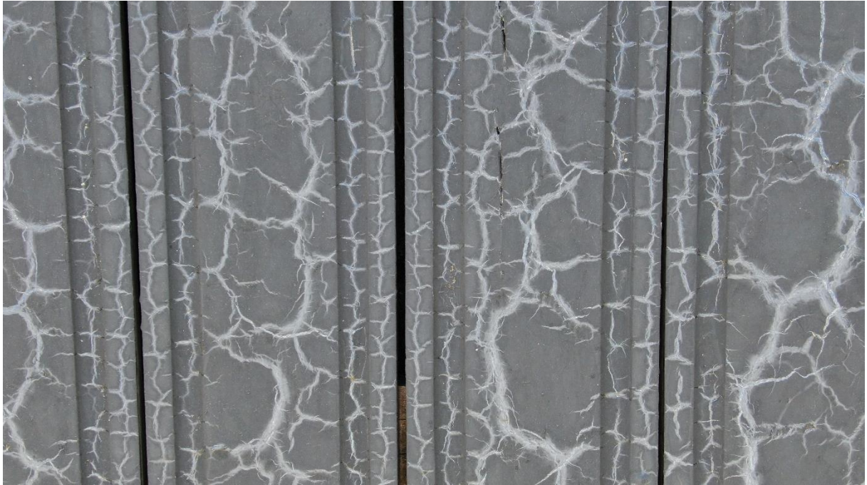
Långhustakets norra takfall efter en strykning med pigmenterad tjära.
