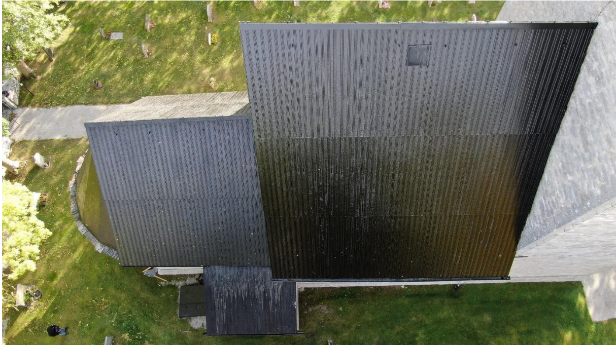
Långhus- och kortakens norra takfall fotograferade fem dagar efter andra tjärstrykningen.
