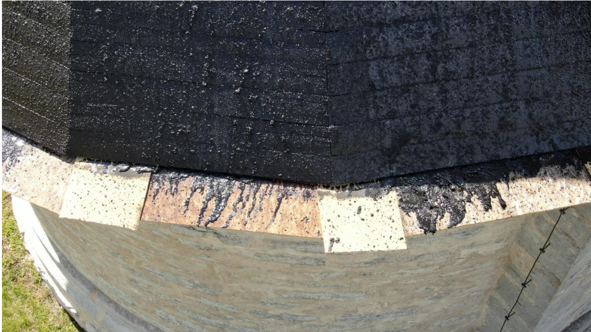
Nederdelen på korabsiden takfall.
