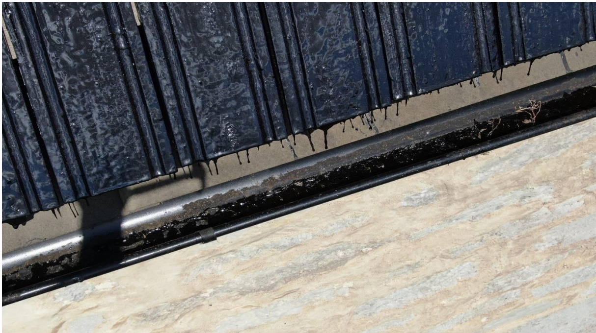
Långhustaketets taksägg och avrinning i hängrännan.
