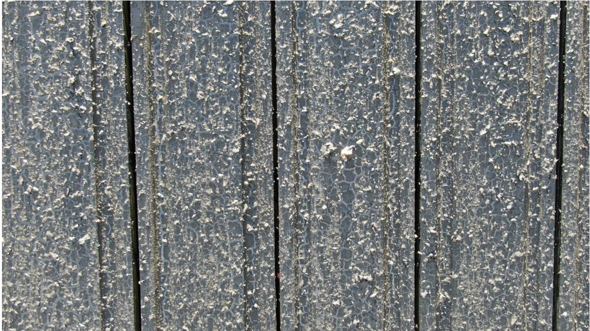
Kortakets norra takfall efter en strykning med kolblandad tjära.
