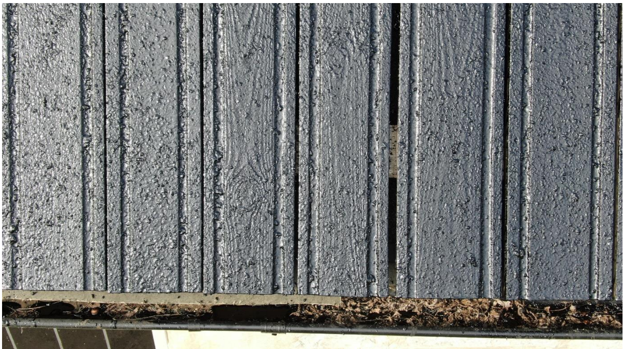
Kortakets södra takfall efter avslutad åtgärd.
