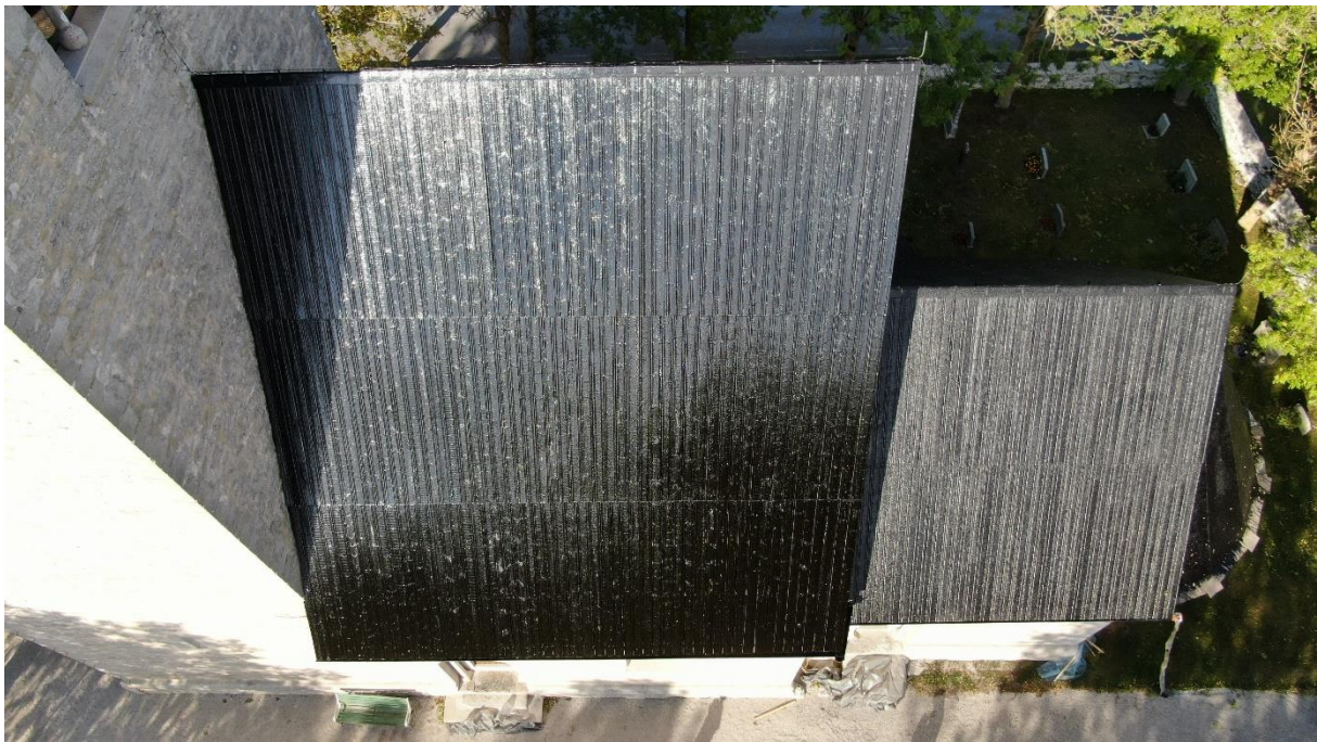
Långhus- och kortakens södra takfall fotograferade fem dagar efter fjärde tjärstrykningen.
