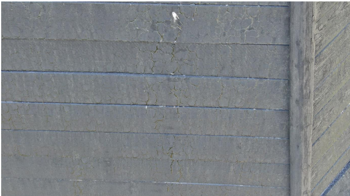
Närbild på takyta mot norr. I direkt nordlig riktning fanns det efter ett år en heltäckande tjäryta kvar.
