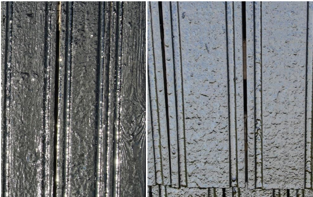
Långhusets södra takfall fotograferat fem dagar efter den fjärde strykningen med pigmenterad tjära. Till höger, långhusets norra takfall fotograferat fem dagar efter den andra strykningen med pigmenterad tjära.
