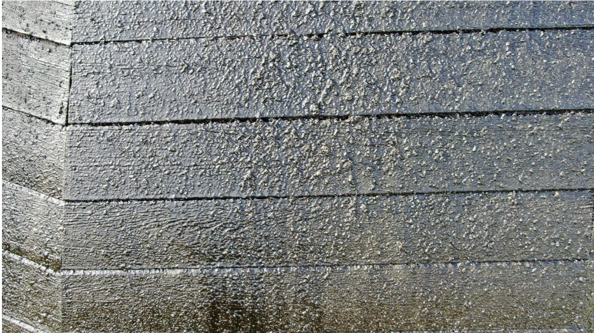
Korabsiden efter avslutad tjärstrykning.
