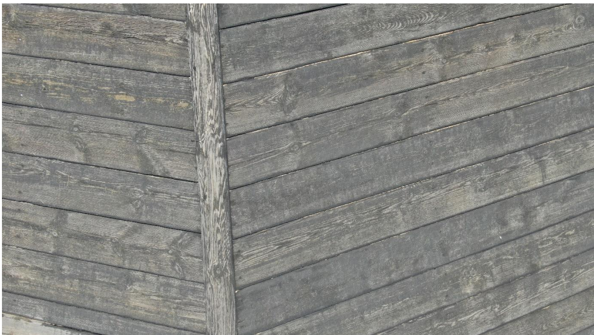
Närbild på en takyta mot söder. Notera att det inte finns kvar någon tjäryta.
