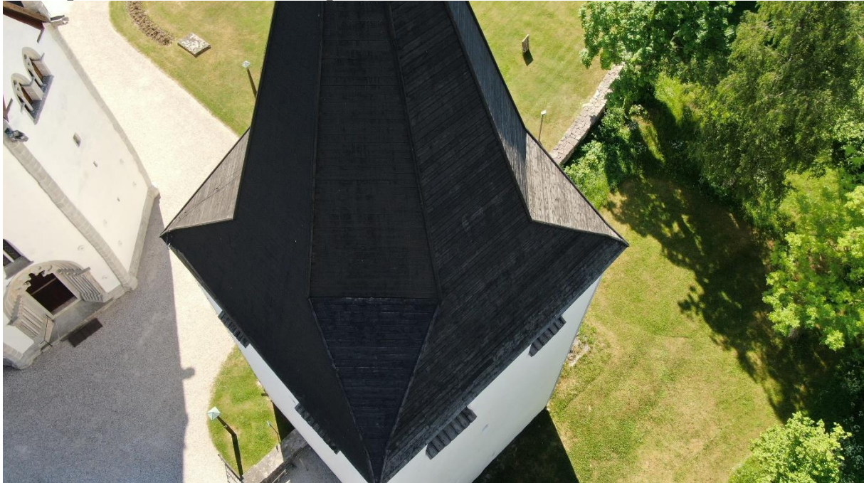
Vy över takets norra och nordvästra takfall.
