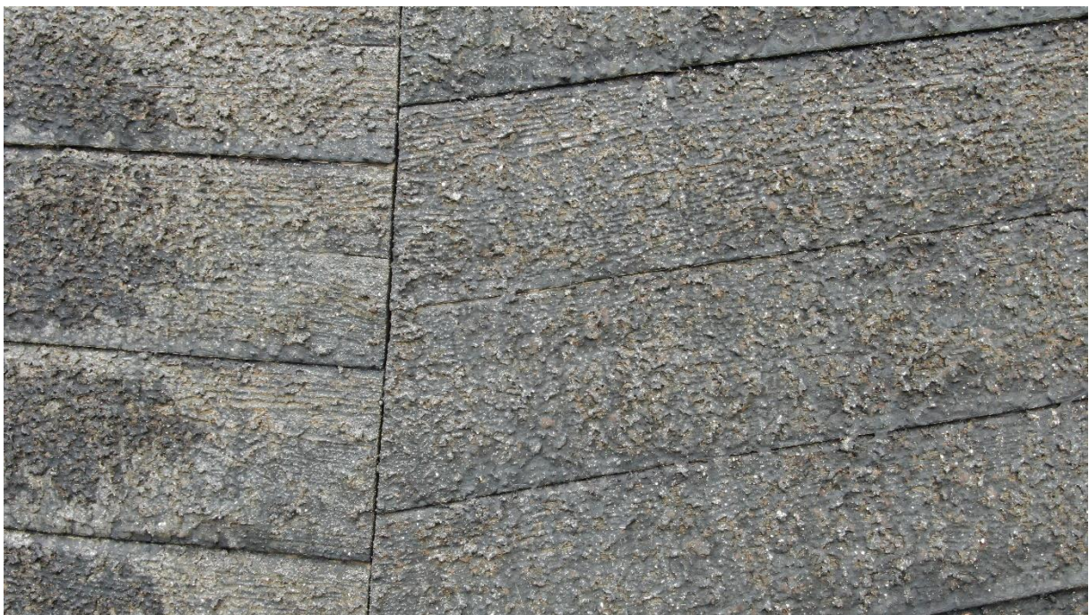
Korabsidens tak efter tre strykningar med kolblandad tjära.
