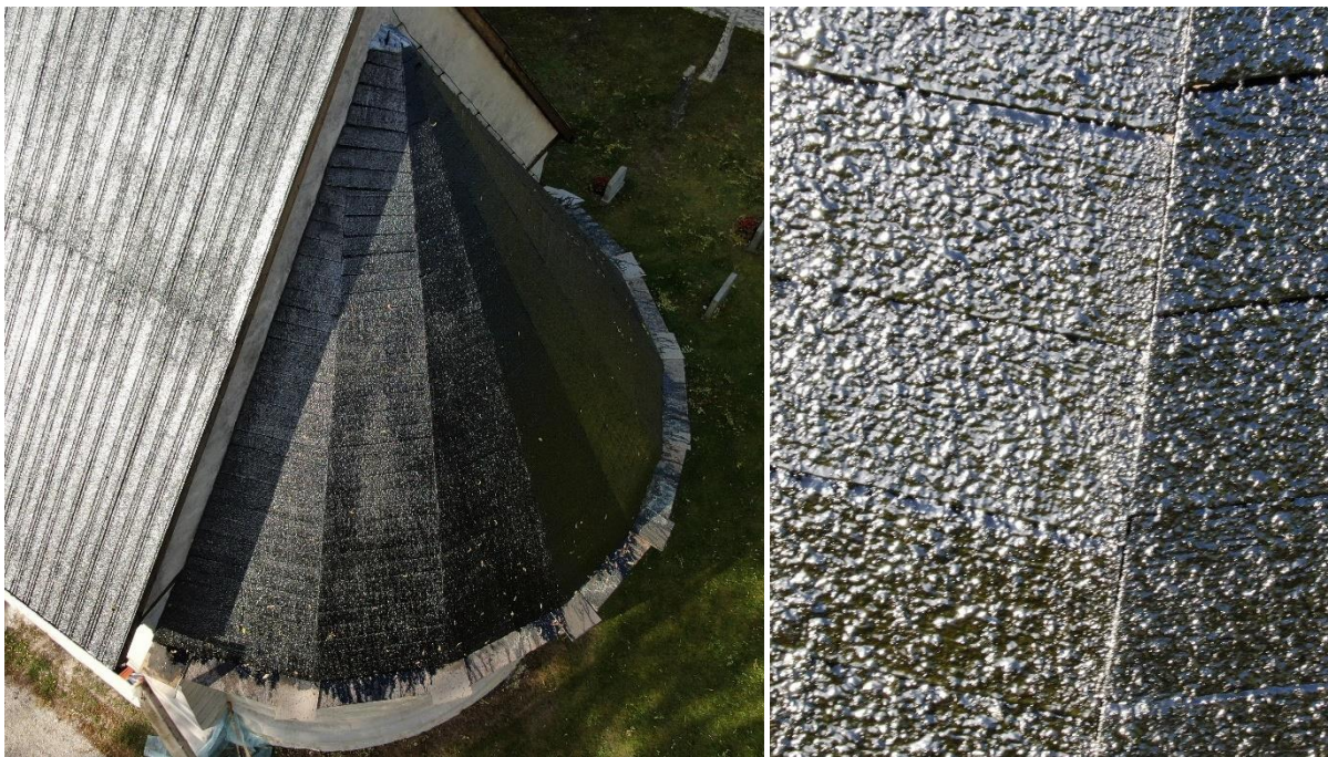
Korabsiden fotograferad fem dagar efter den fjärde tjärstrykningen kolblandad tjära. Bild till höger, närbild korabsiden tjäryta.
