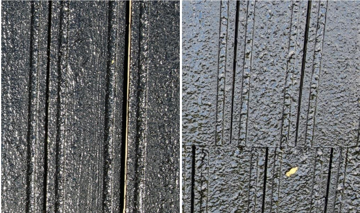
Korets södra takfall fotograferat fem dagar efter den fjärde strykningen med kolblandad tjära. Bild till höger, korets norra takfall fotograferat fem dagar efter den andra strykningen med kolblandad tjära.
