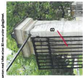
Säng B satts snett ner och mål mot tegelkärnan. Satta i upprättställning
