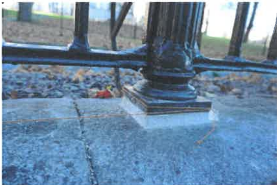
Utmed Hantverkargatan bytts 23 baser ut mot nytillverkade. T.v. en nytillverkad bas. T.h. en bevarad äldre bas.
