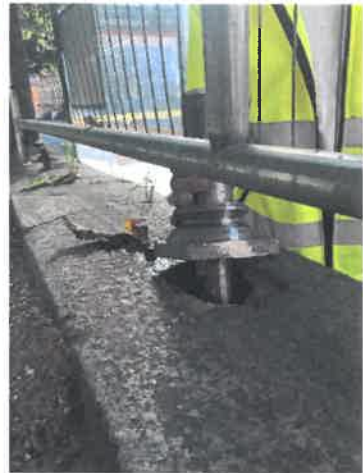
Nyttillverkad bas prövas på plats.
