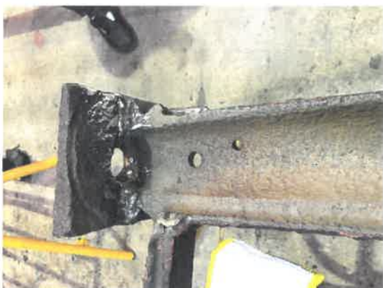
Vissa stolpar hade hål i botten för förankring.
