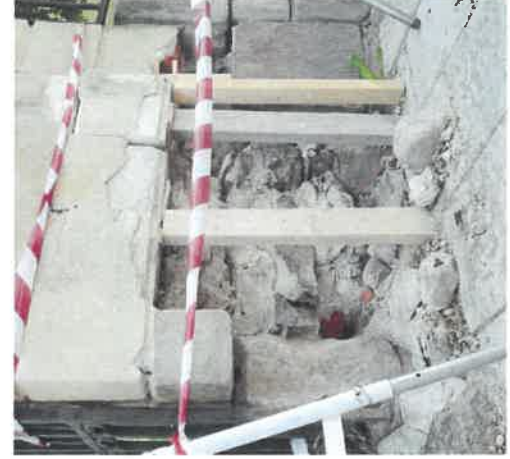
Detalj 3. Kärnan bakom beklädnadstenarna var murad av nubbsstenar /Roslagssandsten) i bruk. Stenarna var kramlade in i kärnan och sträckkramlade in i varandra. Delar av kärnan murades om.
