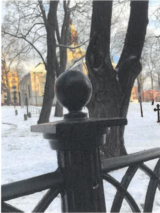
Stolparna har två olika utföranden på hattarna. Den högra är den äldsta varianten. Den vänstra är yngre modell. Hatten på bilden är nytillverkad. Utmed Hantverkargatan byttes 14 hattar ut.
