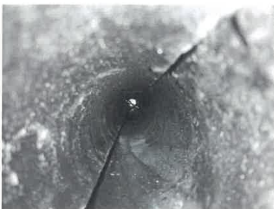
Foto i en monterad stolpe med synlig gängstång i botten.
