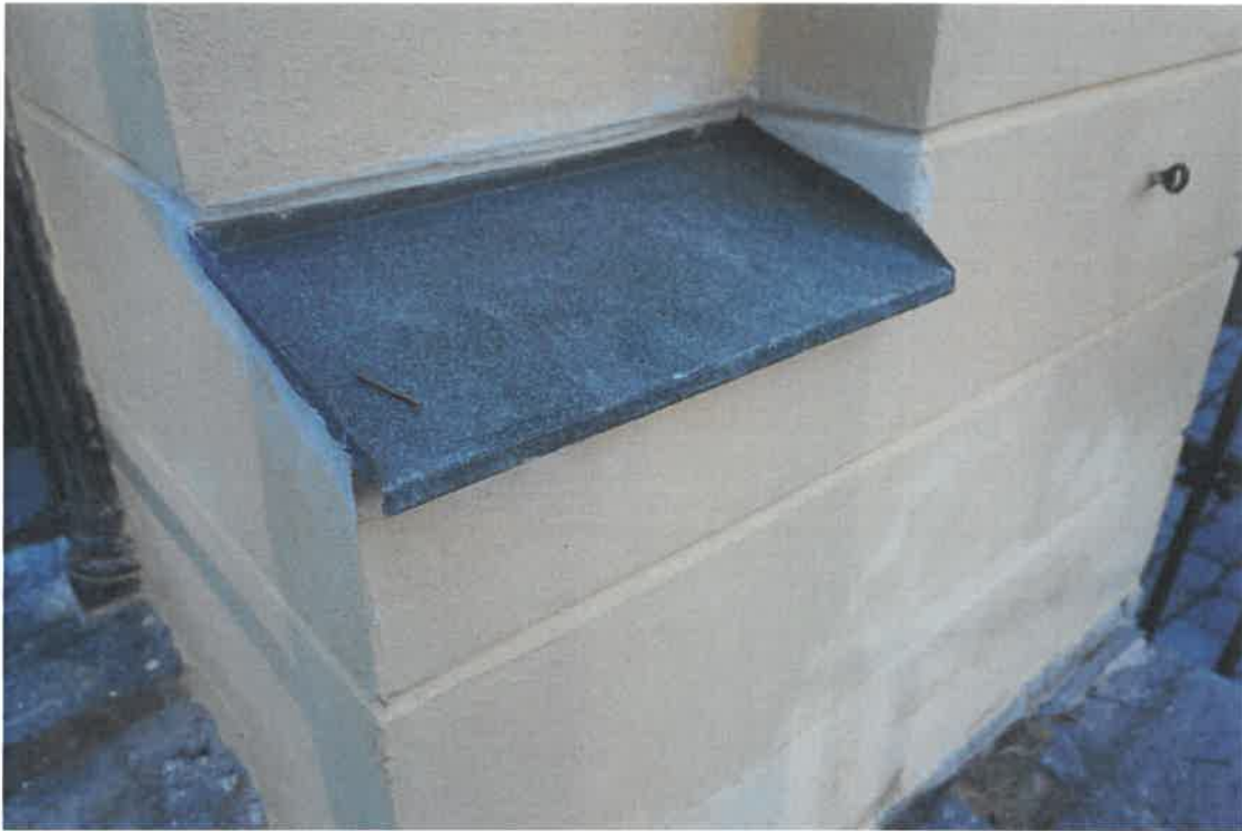
Bleck på port A:s pelare byttes ut. För bibehållen kulör användes förpatinerad koppar.
