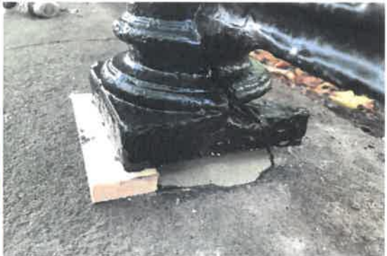
Utmed Hantverkargatan bytts 23 baser ut mot nytillverkade. T.v. en nytillverkad bas. T.h. en bevarad äldre bas.
