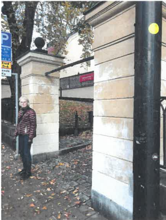
Östra porten efter putslagning.
