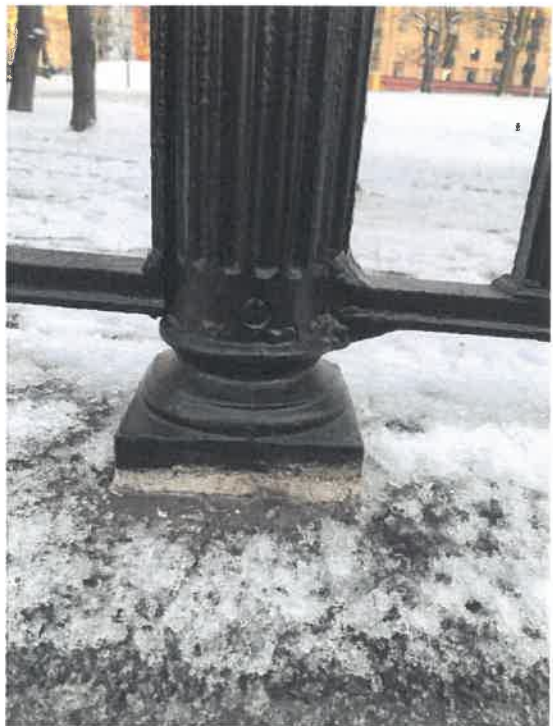
Utmed Hantverkargatan valdes betong som mellanlägg.
