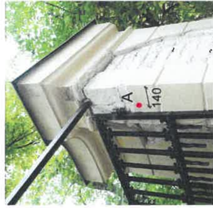
Säng A. Sitts ca 140 mm in från kanten med luter minst 40 mm under åleputset.
