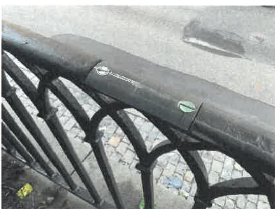
Flera skarvdelar behövde nytillverkas.
