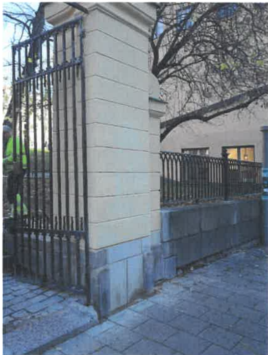
Pelaren efter putslagning och målning.
