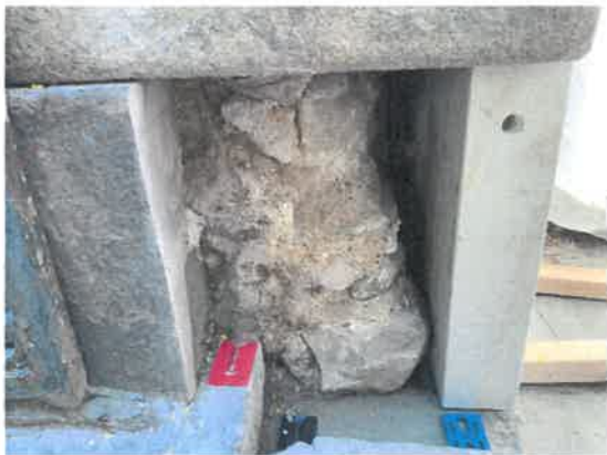
Montage av ny sockelsten på port B.
