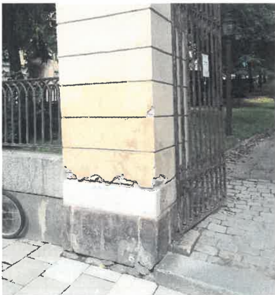
Ny sten på västra pelaren port B.
