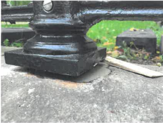
Stolpe gjuts fast efter att staketet har riktats. Exempel på en ny bas.
