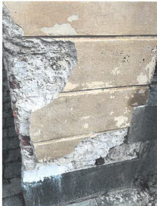
Äldre puts och färglager framkom när lös puts togs ned.
