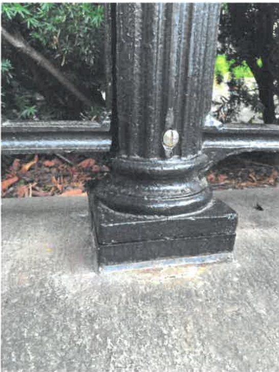
Vid det sydöstra hörnet var distansen mellan stenen och stolpen så stor att en extra platt behövdes.
