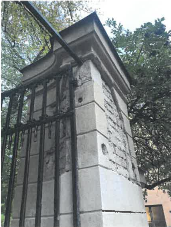
P.g.a. sprickbildningar förankrades några fasadstenar.
