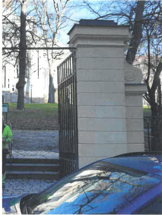
Volut och pelare vid slutbesiktningen.
