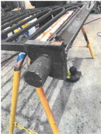
Stolpe från Kaplansbacken med konisk tapp som försänks i stenen.
