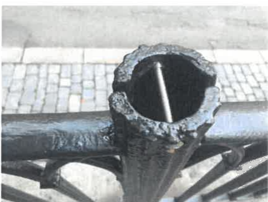
De båda stolpdelarna är ihopskruvade med försänkta skruvar
