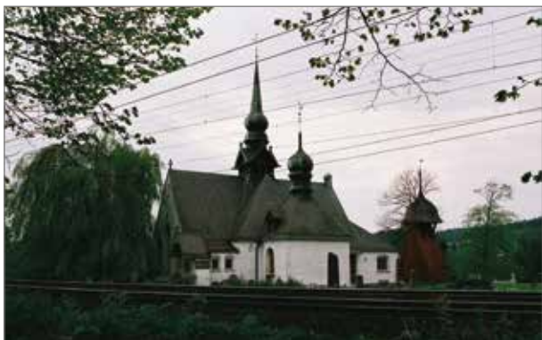
Här från järnvägen syns hur den enorma boken dolde kyrkans södra korsarm. Foto Carina Carlsson.
