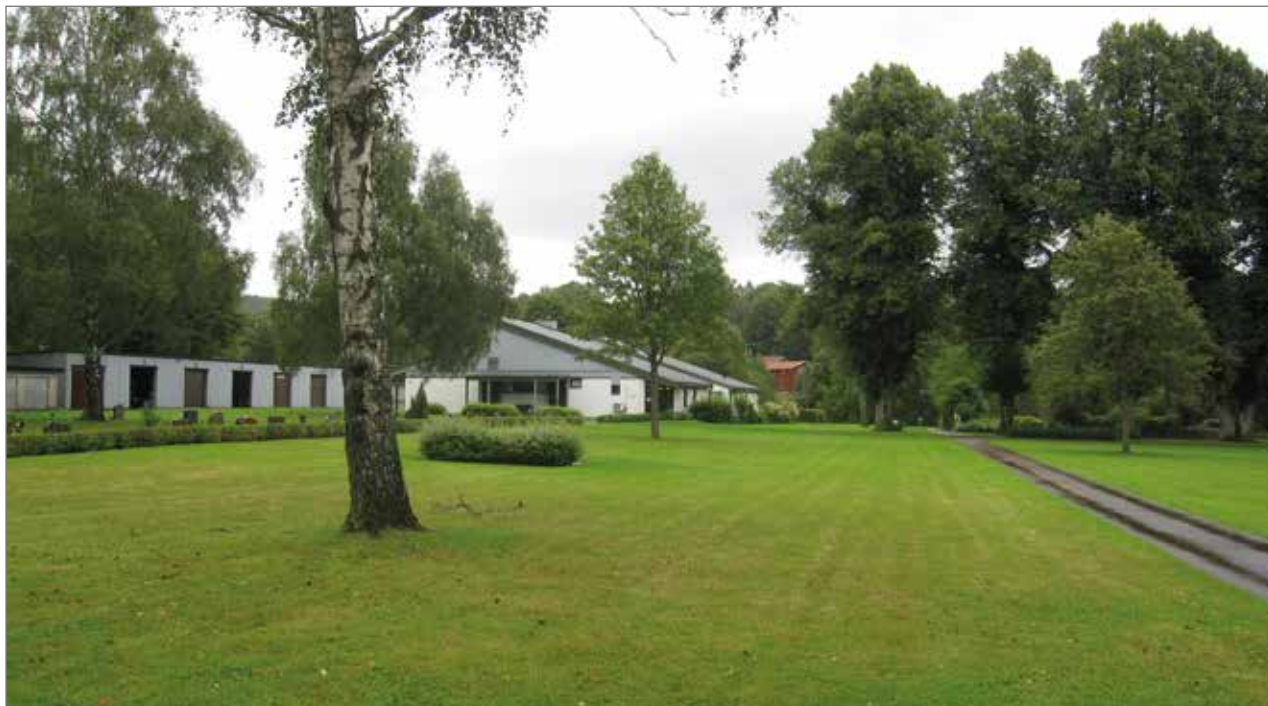
Byggnad för personalutrymmen med mera som nu byggs om.
