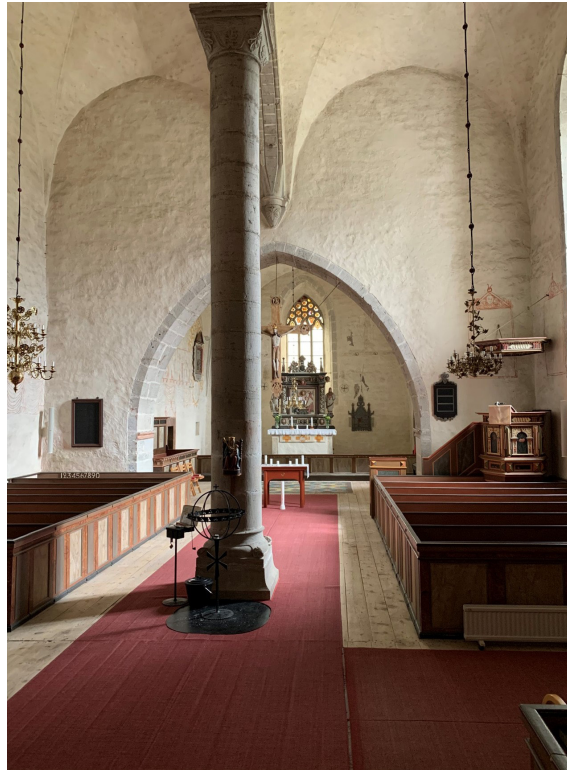
Långhuset, innan restaureringen. Foto: Jakob Lindblad.
