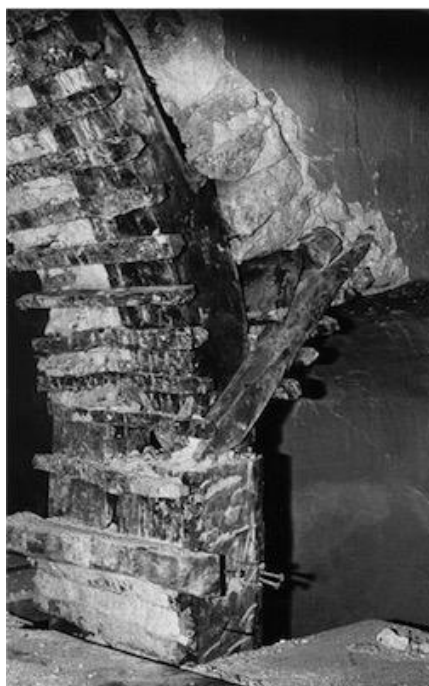
Ovan. Triumfbågens träkonstruktion, södra delen mot predikstolssuppgången, under restaurering 1971-73. Tvärsläarna skulle ge fäste åt putsen. Ersatt med ny konstruktion. Foto Göran Ström 197##. Gotlands Museums arkiv (GFF 892:74). Till höger. Interiör mot öster före restaureringen 2019. Kyrkorummet saknade då ännu elektrisk belysning. Foto JL 2018.
