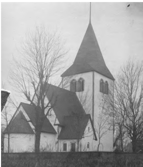
Exteriör från nordöst efter restaureringen 1931 med nybyggd sakristia. Foto Carl Wilhelm Pettersson 1931. RAÄ, Kulturmiljöbild.
