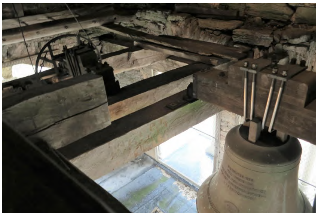
Klockornas upphängning i bjälkar mellan yttermurarna. Foto JL 2019.
