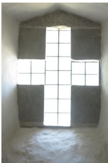
Fönstret i tornets västfasad, sett inifrån. Foto Johan Gardelin, Gotlands museum, 2019 (20190619:1525).
