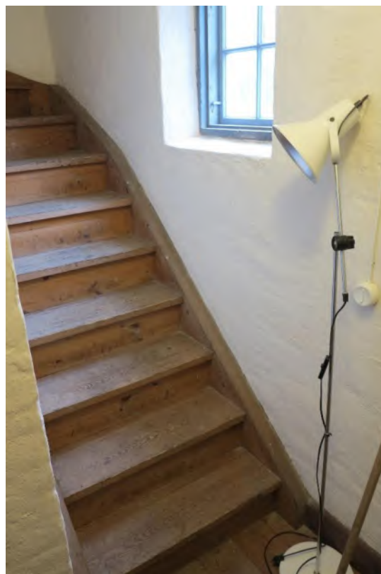
Vindstrappa i sakristian, sedd mot nordväst. Foto JL 2019.
