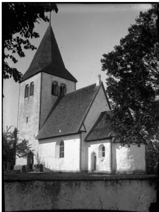
Kyrkogårdsmuren är putsad. Foto Einar Erici 1915. Riksantikvarieämbetet, Kulturmiljöbild.
