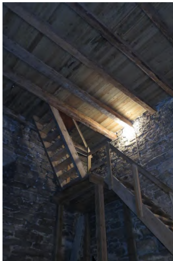
Tornets första övervåning, sedd uppåt mot nordväst genom det som tidigare var en andra övervåning upp mot bjälklaget till klockdäcket. Foto JL 2019.
