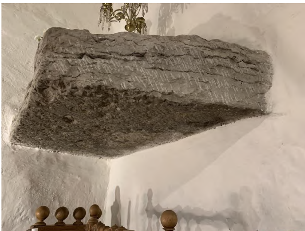
Inmurad häll i ringkammarens sydvästra hörn med okänd funktion, sedd snett ovanifrån och snett nedifrån. Möjligen avsats för steg till den 1931 igensatta öppning i valvets södra del som före sakristians tillkomst utgjorde tornuppgång. Foto JL 2019.
