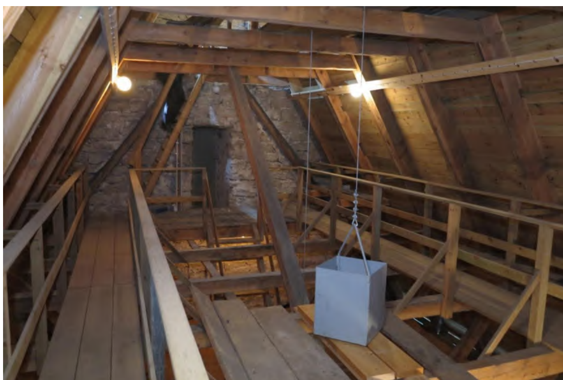
Övre delen av långhusets vind sedd mot väster. I fonden tornets östra mur med passage och med kvarstående äldre takstol med lägre vinkel närmast muren. Foto JL 2019.
