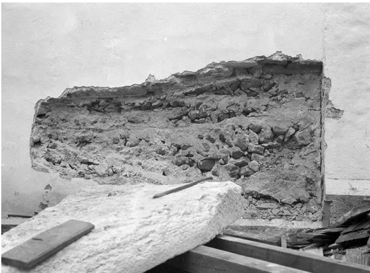
Bildstenen uttagen ur muren på långhusets norra sida under restaureringen 1931. Foto Karl Gustafson 1931. RAÄ, Kulturmiljöbild.
