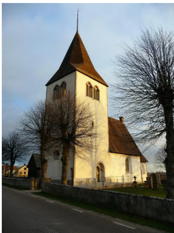
Akebäck kyrka. Muren mot landsvägen är putsad på den yttre sidan och delvis på den inre sidan. Foto ES 2019.
