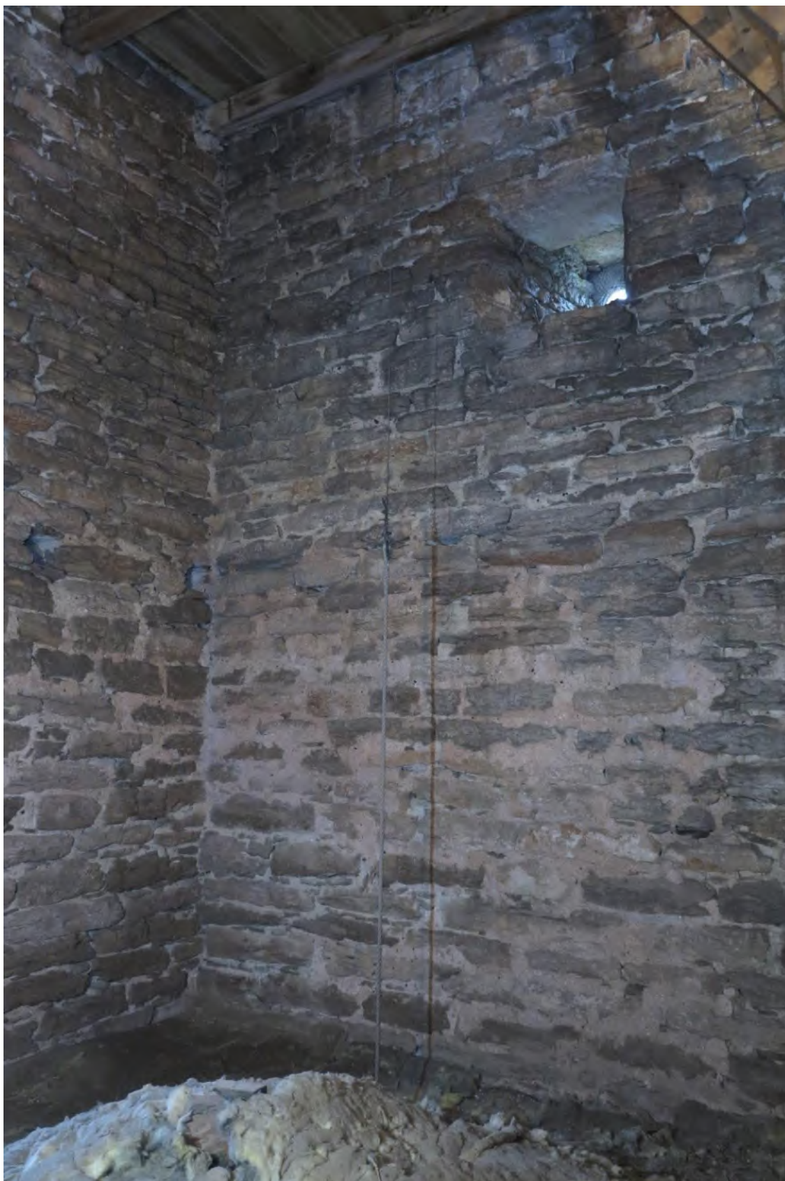
Tornets första övervåning sedd mot sydväst. Rummet tidigare delat i två våningar. Den runda ljusgluggen i västfasaden synlig inifrån. En inre avtrappning av murverket ligger i nivå med gluggen. Foto JL 2019.
