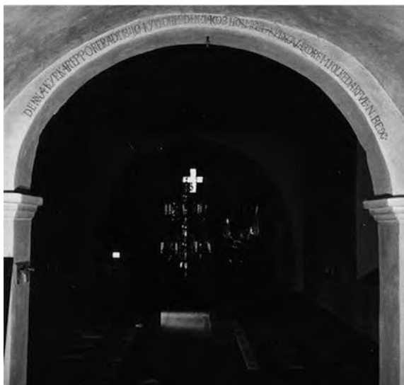
Inskrift på triumfbågens östra sida, borttagen 1971-73 vid bågens ommurning. Inskriften berättade om den reparation år 1840 då bågen vidgades. Foto ca 1970 i Gotlands Museums arkiv (GFF 892:00).
