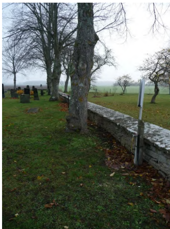
Murarna i norr, öster och söder saknar puts på insidan. Hela kyrkogårdsmuren är täckt av kalkstenshällar. Foto ES 2019.
