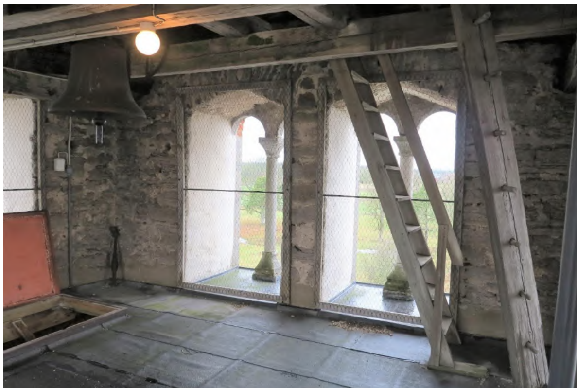
Klockvåningen mot nordväst. Foto JL 2019.
