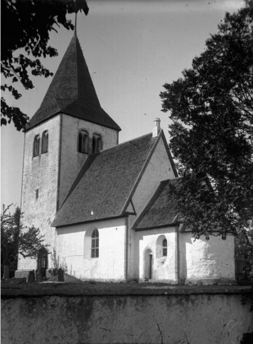
Kyrkan från sydöst efter ca 1910. Taken och tornhuven täcks med spåntak och skorstenen har tillkommit. Foto Einar Erici 1915. RAÄ, Kulturmiljöbild.
