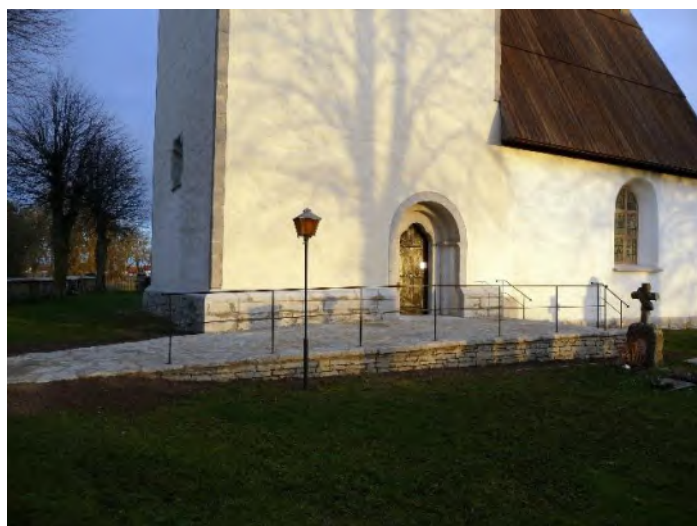
Vid den södra ingången till kyrkan är marken förhöjd för att jämna ut nivåskillnader. Foto ES 2019.
