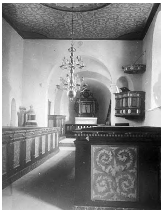
Interiör mot öster efter restaureringen 1931. Foto Carl Wilhelm Pettersson 1931. RAÄ, Kulturmiljöbild.
