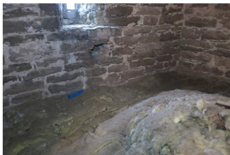
Tornets första övervåning mot sydväst. Valvets ovansida täcks av isoleringsmattor. Under ljusluggen mynnade före 1931 hålet genom valvet som tidigare utgjorde tornuppgång. Foto JL 2019.
