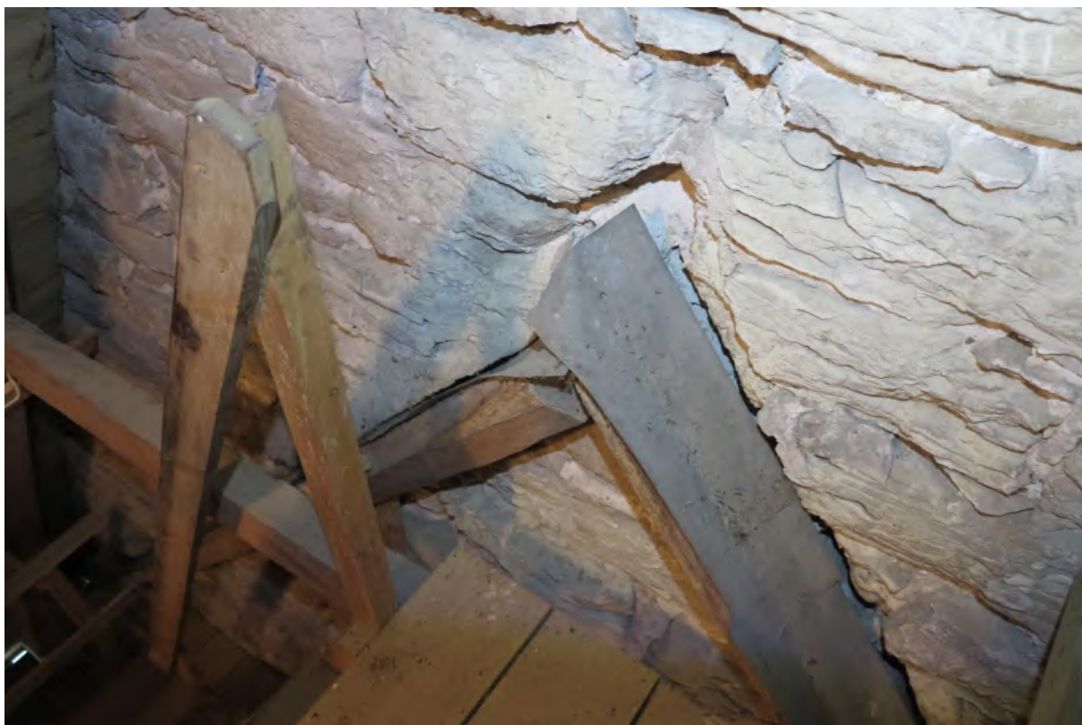
Tornets östra mur sedd från långhusvinden med inmurad äldre takstol som visar långhusets ursprungliga lägre takresning. Foto JL 2019.
