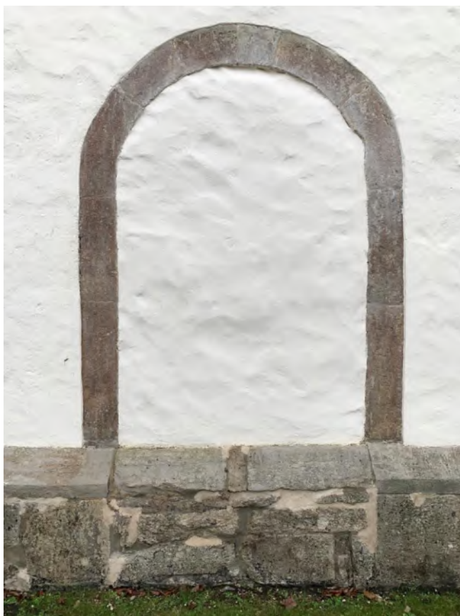
Tornets nordportal, vars omfattning förmodligen ursprungligen var sydportal på långhuset, igenmurad vid okänd tidpunkt. Foto JL 2019.
