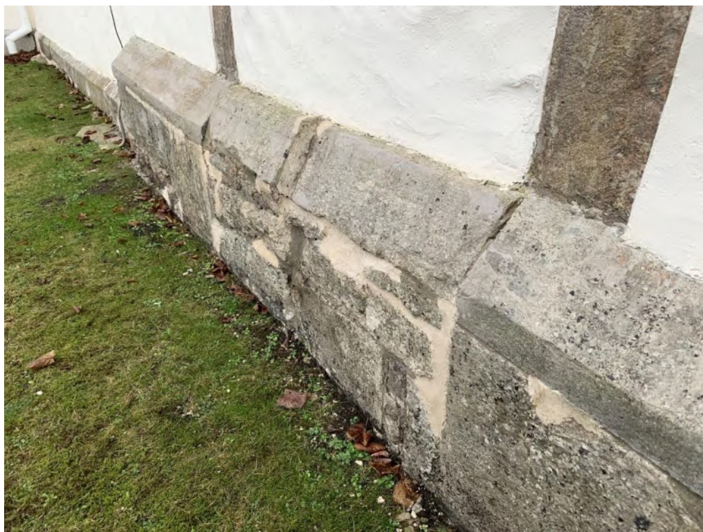
Tornets igenmurade nordportal. Återanvänd huggen sten placerad som sockelsten, kanske från portalens inre omfattning eller från en tidigare omfattning till långhusets södra fönster. Foto JL 2019.
