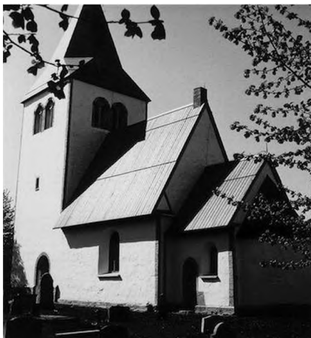
Exteriör från sydöst efter avslutad restaurering 1971-73. Faltaken omlagda. Foto Jan Utas 197##. Gotlands Museums arkiv (GFF 892:32). Skorstenen har senare försetts med en klassiserande kransgesims.
