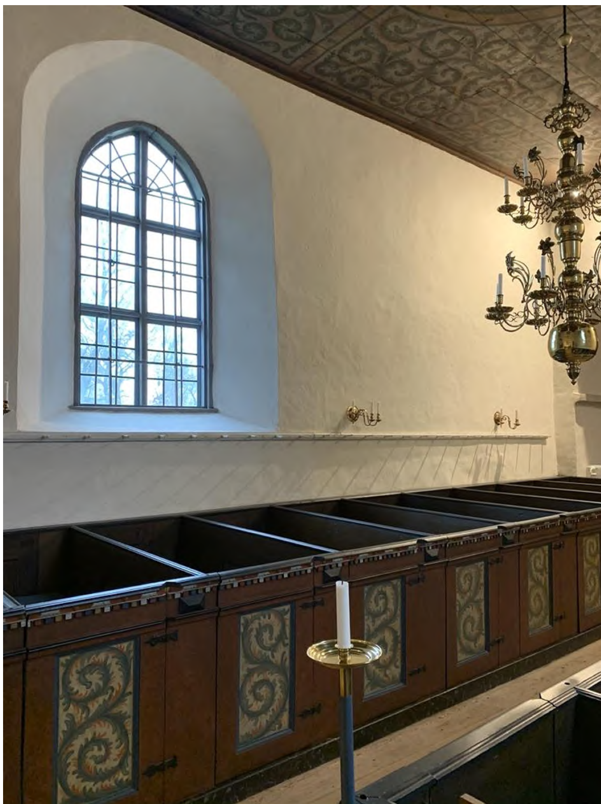
Långhusets södra fönster och södra sidans bänkinredning. Observera knaggarna på muren, de på en bräda fästa hatthängarna. Foto JL 2019.
