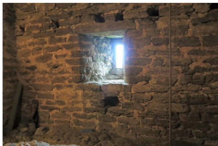
Tornets första övervåning mot söder med ljuslugg och däröver hål från våningsindelade tidigare bjälklag. Foto JL 2019.
