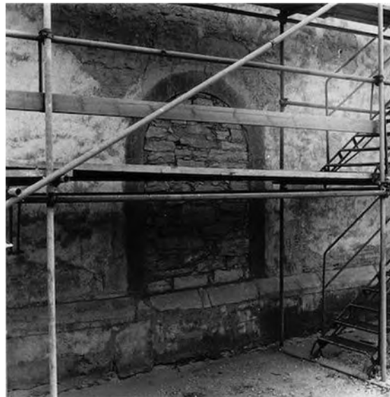
Tornets igensatta nordportal frilagd under restaureringen 1971-73. Foto Jan Utas 197##. Gotlands Museums arkiv (GFF 892:35).
