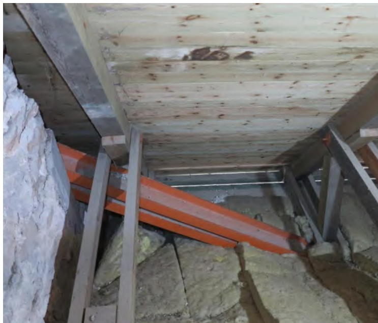
Korvinden mot öster. Till höger korvinden mot sydöst med förstärkning och takstol från 1971-73. Foto JL 2019.
