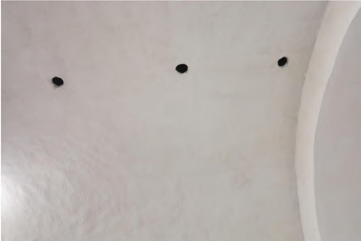
Korets tunnvalv med ljudkrukor, inmurade keramiska kärl för att öka resonansen. Foto JL 2019.
