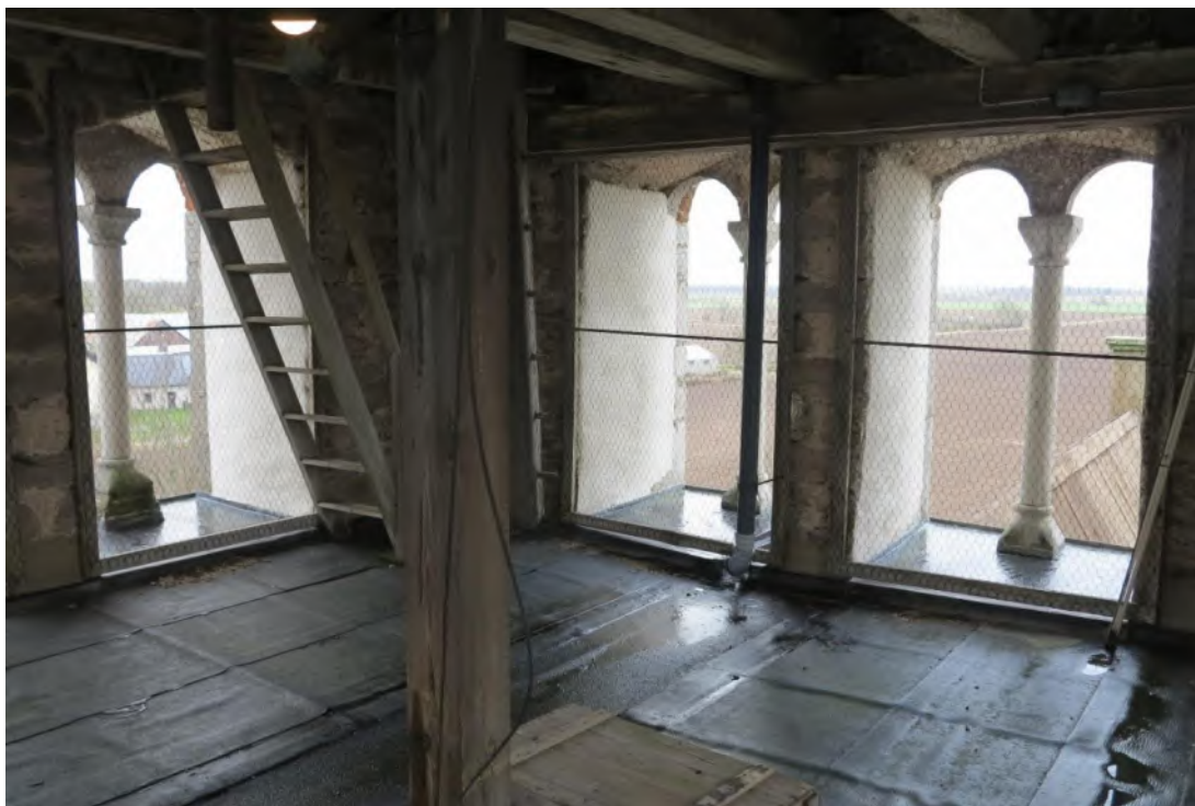
Klockvåningen mot nordöst. Foto JL 2019.
