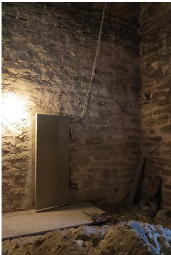
Tornets första övervåning mot sydöst med passage till långhusvinden. Foto JL 2019.
