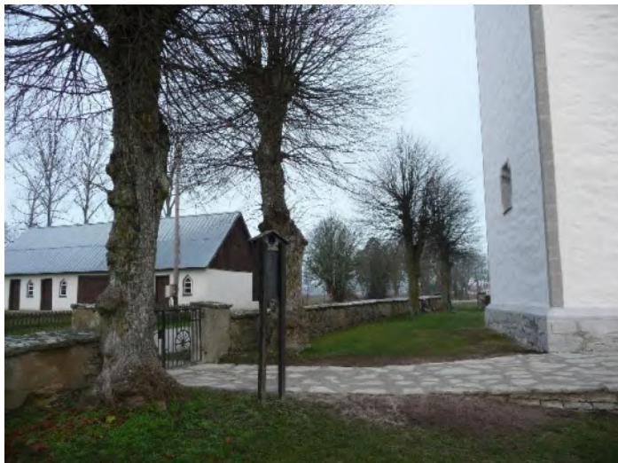
Nyanlagd gång i råskuren kalksten. Foto ES 2019.
