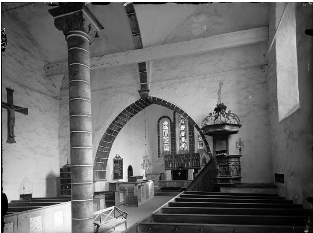
Interiör mot öster före restaureringen 1915-16. Nya glasmålningar har tillkommit i östfönstren och värmekamin i långhuset. De, kanske omkr. 1860, mörkt målade stenarna kontrasterar mot den vita putsen. Dragstaget av trä är senare ersatt av ett järnstag. Foto Anders Roland 1913. RAÄ,
