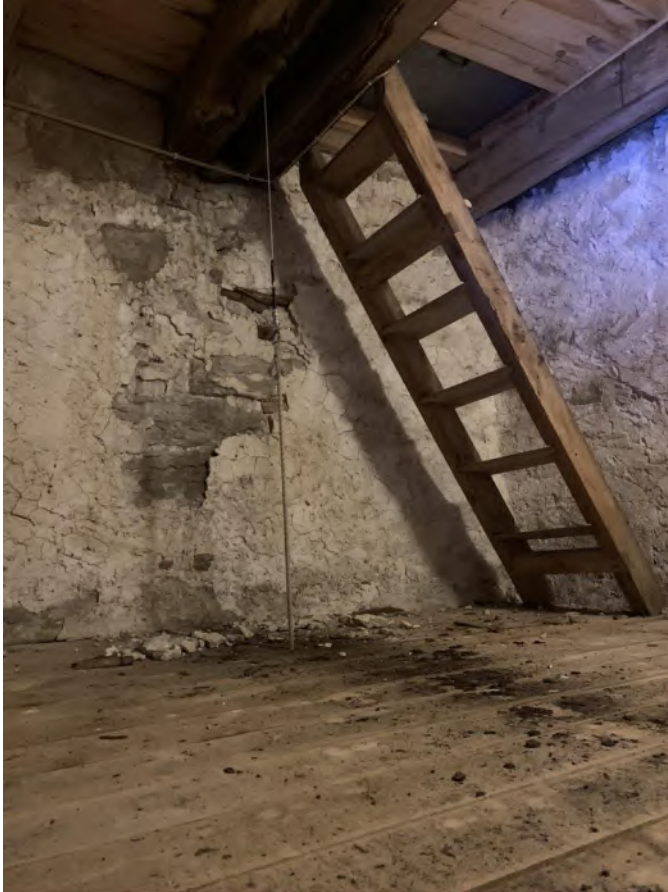
Tornets fjärde övervåning mot sydväst. Foto JL 2019.
