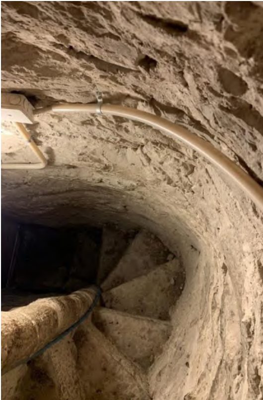
Spiraltrappa till vinden. Långhusets sydvästra hörn. Foto JL 2019.
