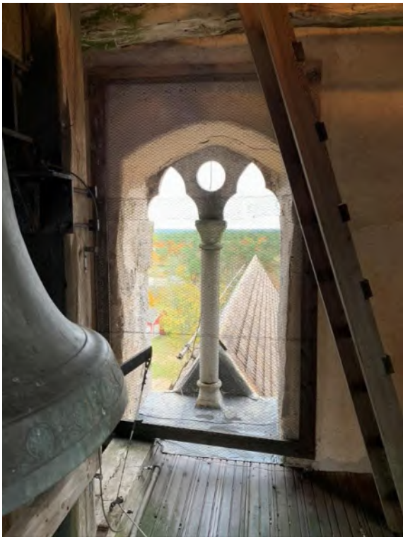
Klockrummet i tornets femte övervåning. Östra ljudgluggen med kolonnett och masverk från 1915–16. JL 2019.
