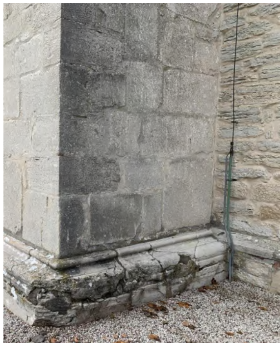
Murverk och socklar i långhuset och kor. Korets sockel går in bakom långhusets och visar att koret är äldre. Foto JL 2019.
