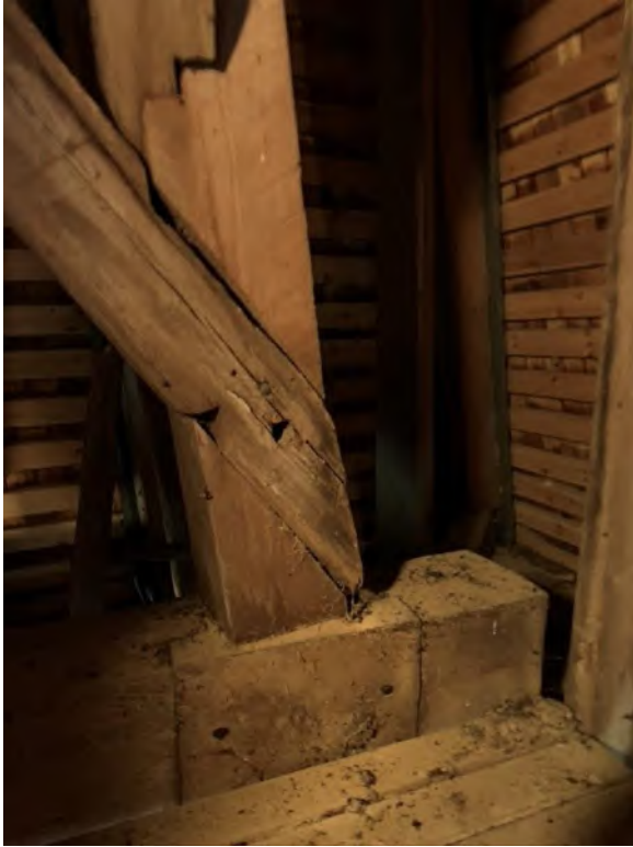
Tornhuvets bärkonstruktion. Kryss mellan stolpar något indragna från hörnen, t h mittstolpen. Foto JL 2019.
