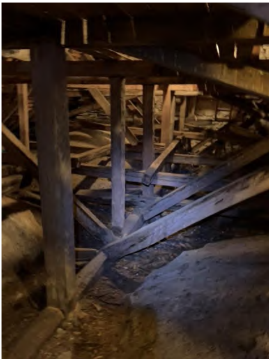
Långhusets takstol sedd mot väster. Foto JL 2019.
