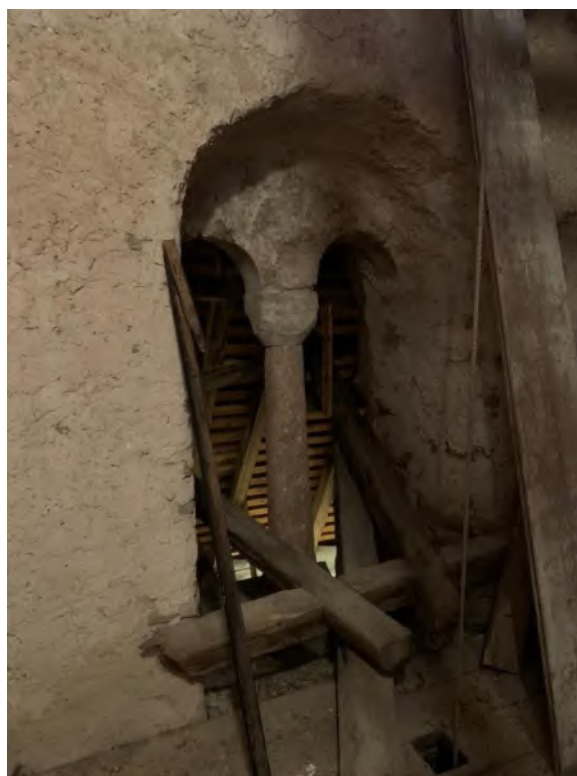
Tornets andra övervåning sedd mot öster och söder. Ingång genom den tidigare östra ljudgluggen. Ljudgluggarna mot söder och norr har kolonnetter i behåll. Murverket putsat på inåt tornet, oputsat utåt vinden. Foto JL 2019
