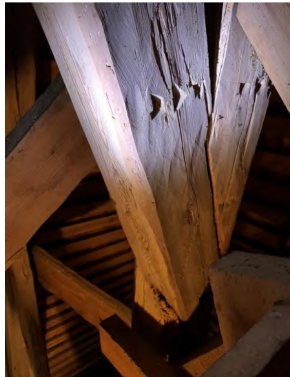
Tornhuvens bärkonstruktion. Knutpunkt med huggen märkning av delarna. Foto JL 2019.
