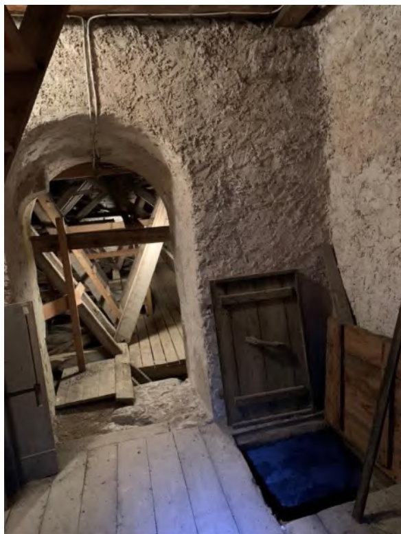
Tornets andra övervåning sedd mot öster och söder. Ingång genom den tidigare östra ljudgluggen. Ljudgluggarna mot söder och norr har kolonnetter i behåll. Murverket putsat på inåt tornet, oputsat utåt vinden. Foto JL 2019
