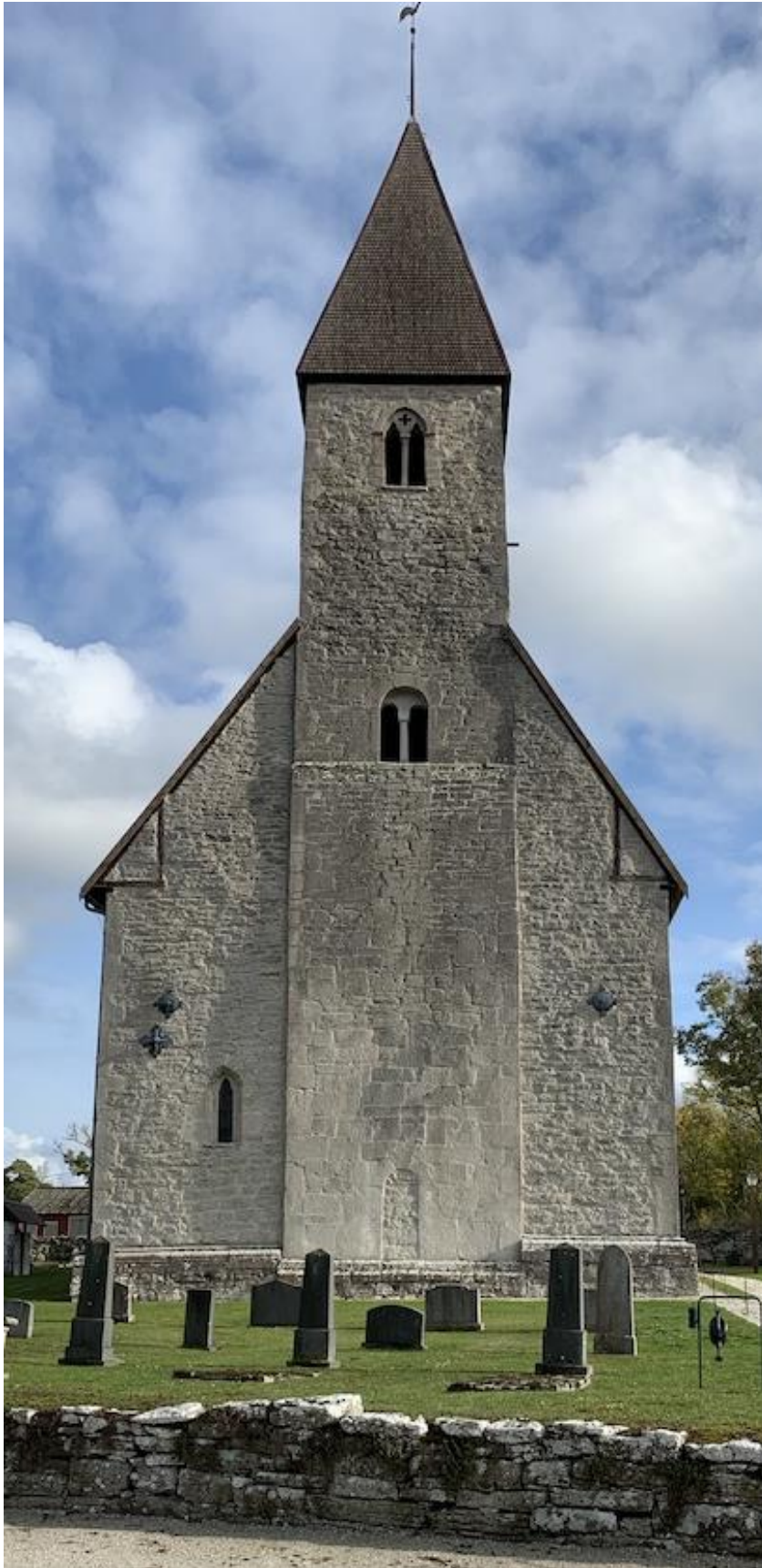
Västfasaden. Tornets tidigare höjd framgår tydligt av murverkets ytbehandling strax ovanför den ursprungliga ljudgluggen. Foto JL 2019.
