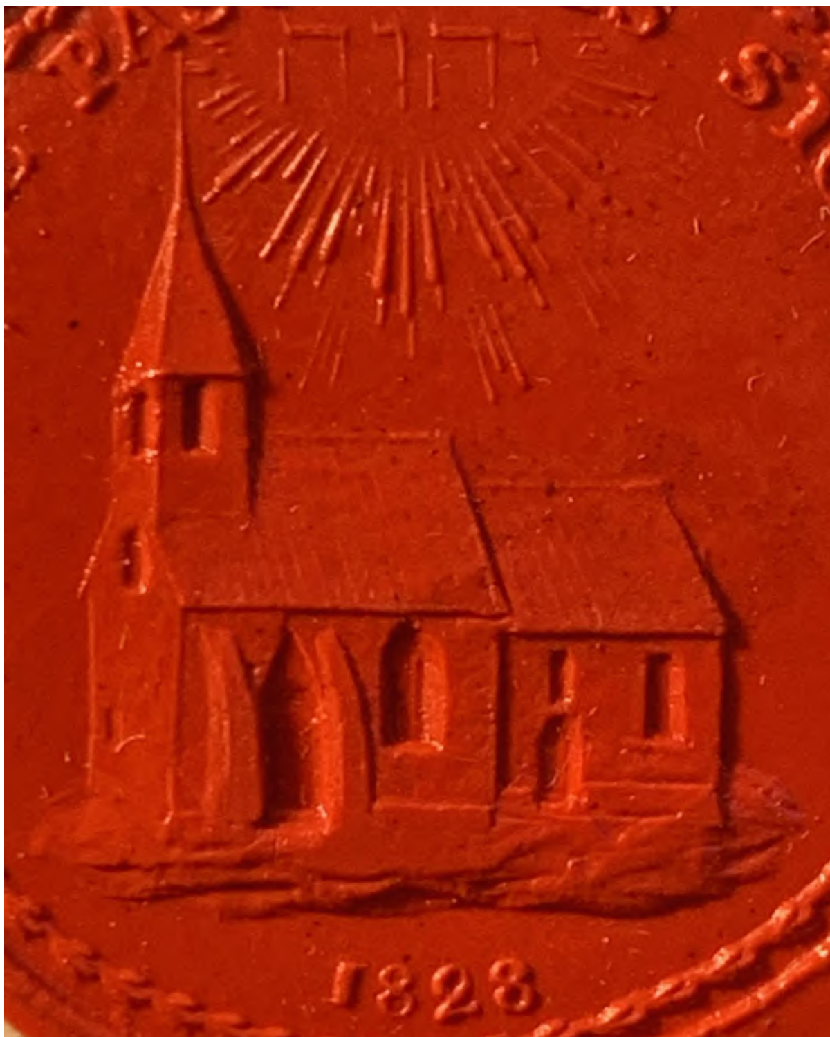
Kyrkan från sydväst med de på 1860-talet rivna strävpelarna mot långhusets södra mur. Endre pastorats sigill 1828 av Gustaf Adolf Unnerus, sannolikt efter egen förlageteckning. Stark förstoring. ATA, Sveriges Kyrkors arkiv, okat. Foto JL 2019.
