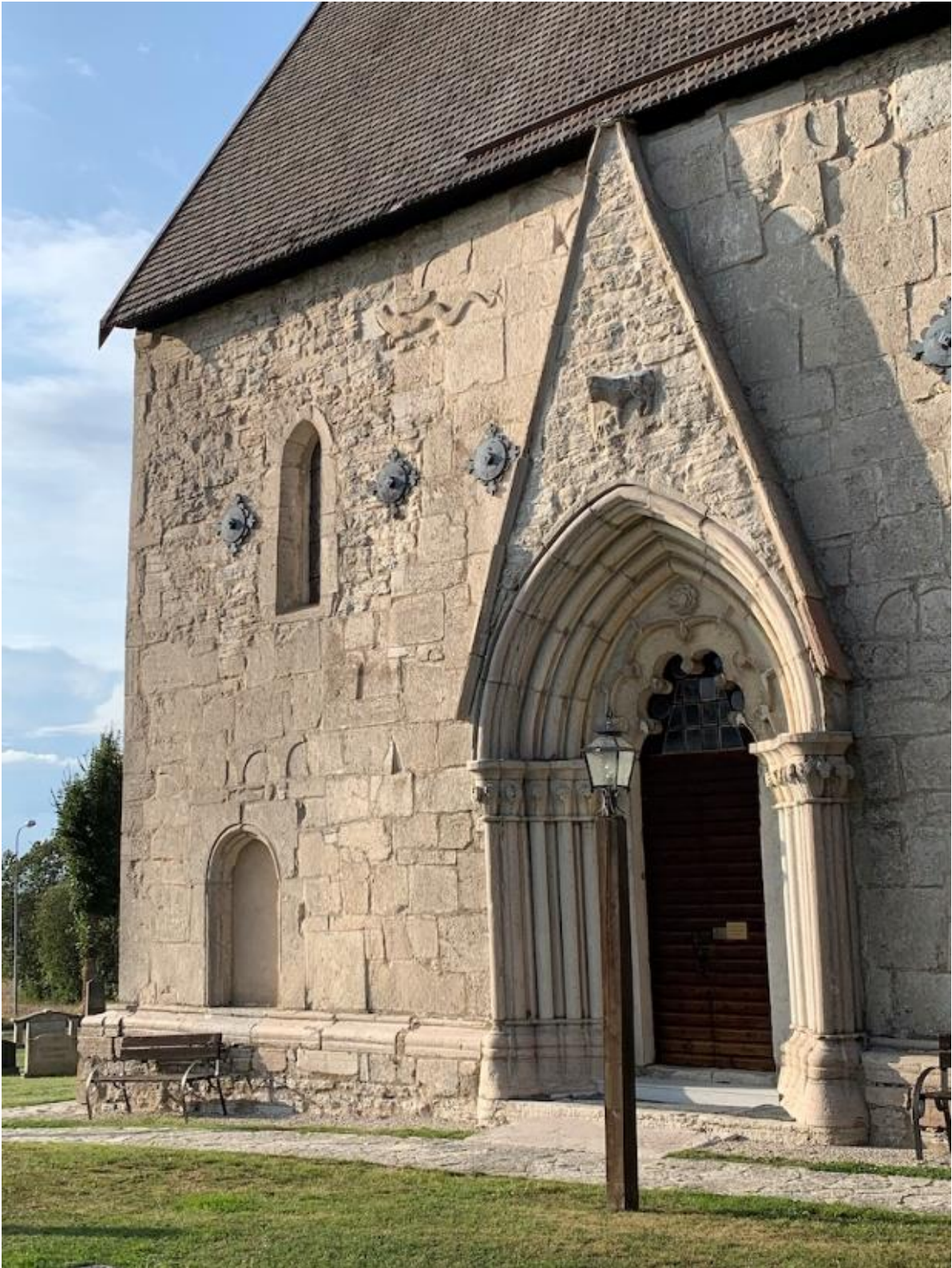
Västra delen av långhusets sydfasad. Murverket visar den tidigare bönecellens höjd. Foto JL 2019.
