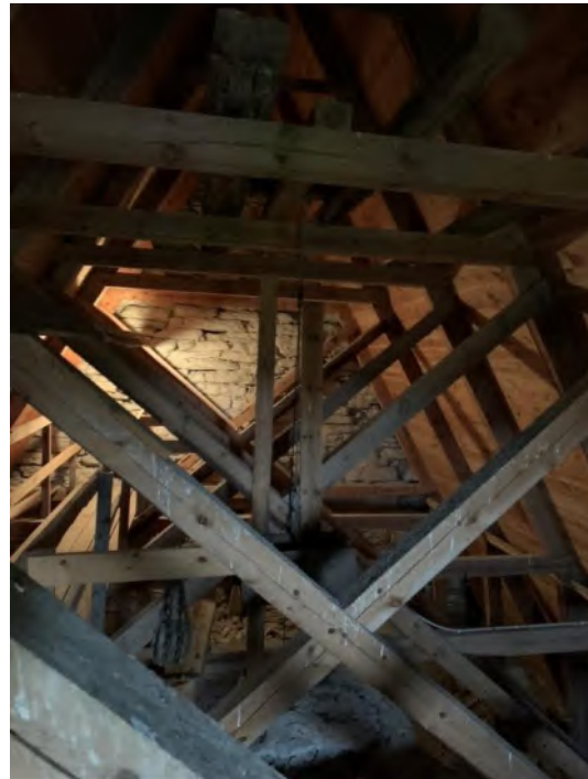
Korets takstol sedd mot väster. Foto JL 2019.
