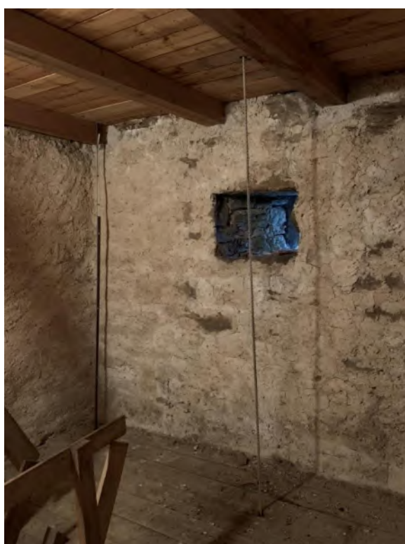
Tornets tredje övervåning mot söder. Foto JL 2019.
