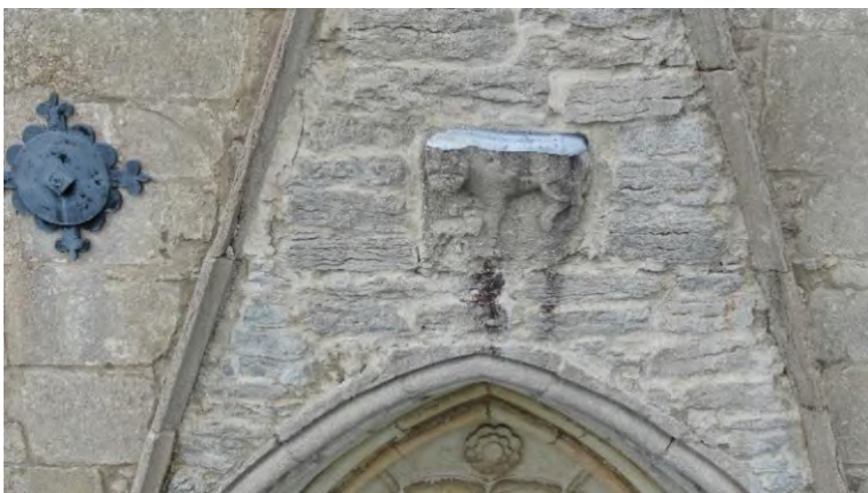
Tornkrönet samt från äldre kyrkan inmurade reliefer och en ankarslut, sannolikt från omkring 1860. Foto Pär Malmros, Visby stift, 2019.
