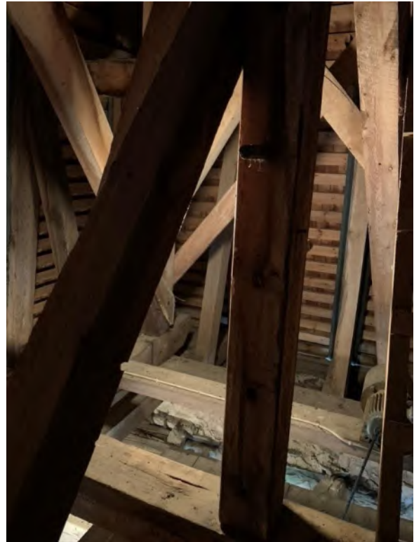
Tornhuvets bärkonstruktion. Kryss mellan stolpar något indragna från hörnen, t h mittstolpen. Foto JL 2019.
