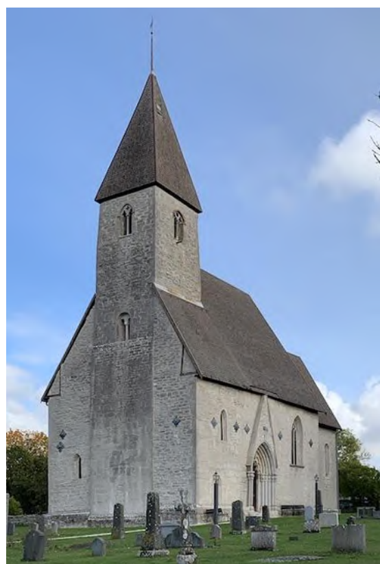
Kyrkan från sydväst. 1988 avlägsnades skorstenen från början av 1900-talet, korets tegeltak byttes mot spån. Foto JL 2019.
