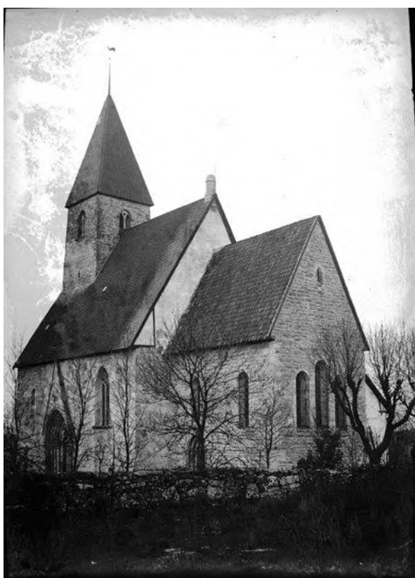
Kyrkan från sydöst efter restaureringen 1915–16. Fasadmurverket är frilagt från puts. Foto Einar Erici 1919, RAÄ, Kulturmiljöbild.
