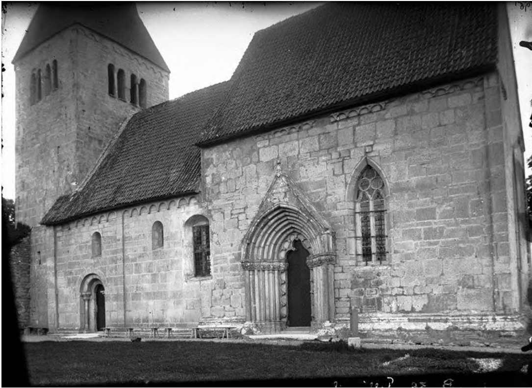
Kyrkans södra fasad. Skillnaden mellan långhusets äldre och korets yngre kvadermurar syns tydligt liksom den skillnad i stenens kvalitet som Carl Georg Brunius omtalade från sitt besök i kyrkan 1862. Foto Olof Sörling, troligen omkring 1890. RAÄ Kulturmiljöbild.
