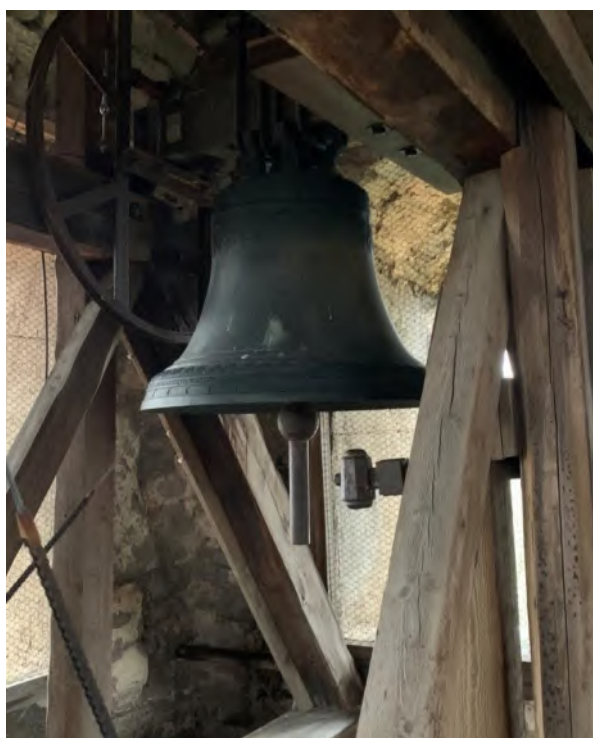
Klocka, gjuten av Gerhardt Meyer i Stockholm 1699 sedan dess föregångare spräcktes under Karl XI:s likringning. Foto JL 2019.
