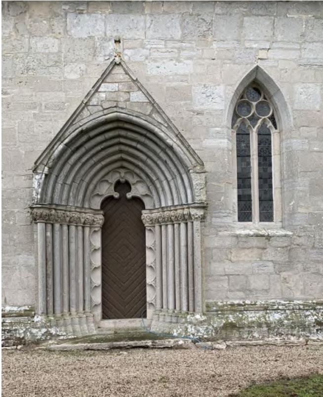
Korets portal och södra fönster. Foto JL 2019.
