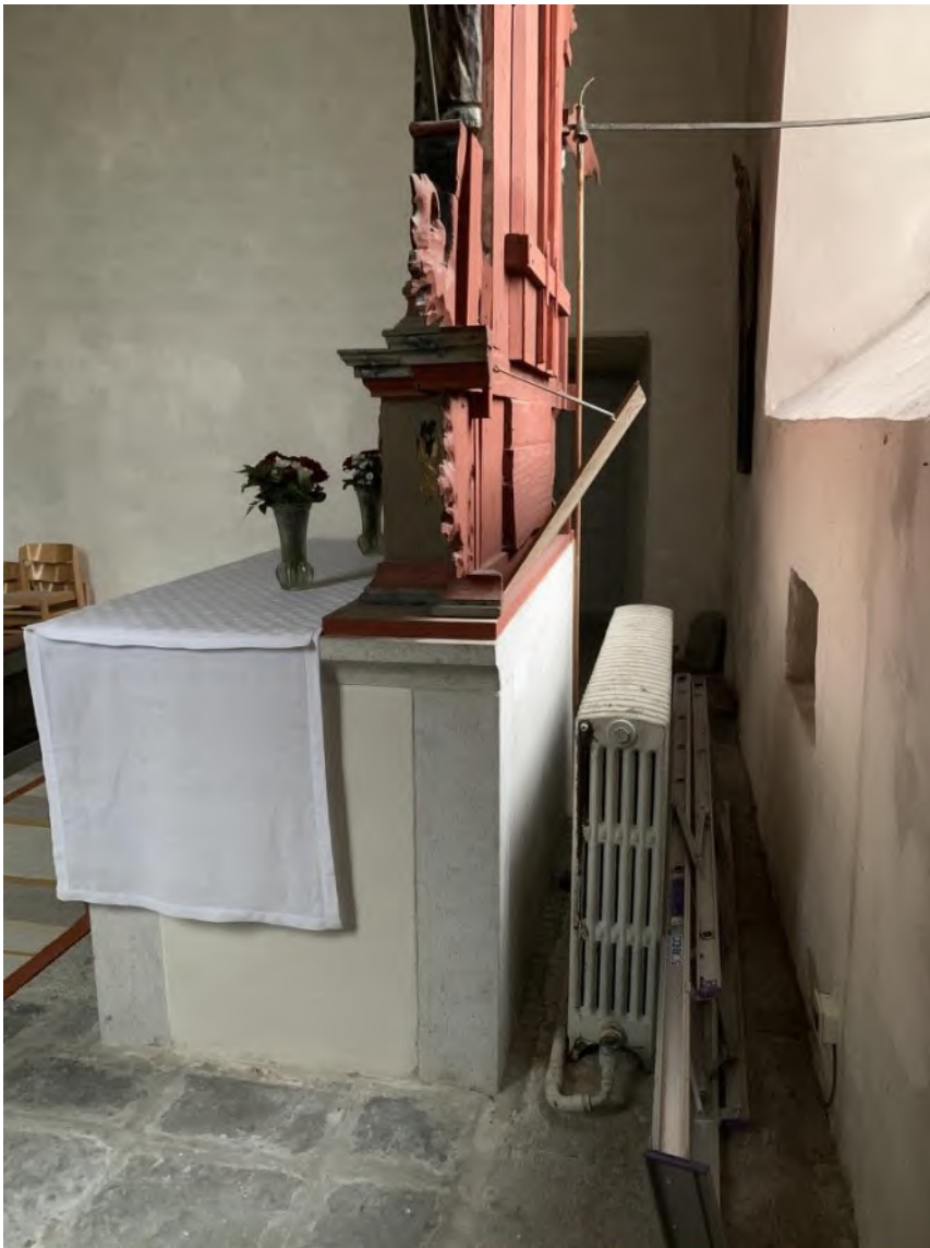
Altaret, i sin nuvarande form sedan 1955-56, samt altartavlan av trä från 1646 med rödmålad baksida. I muren bakom altaret en dold förvaringsnisch. Foto JL 2019,
