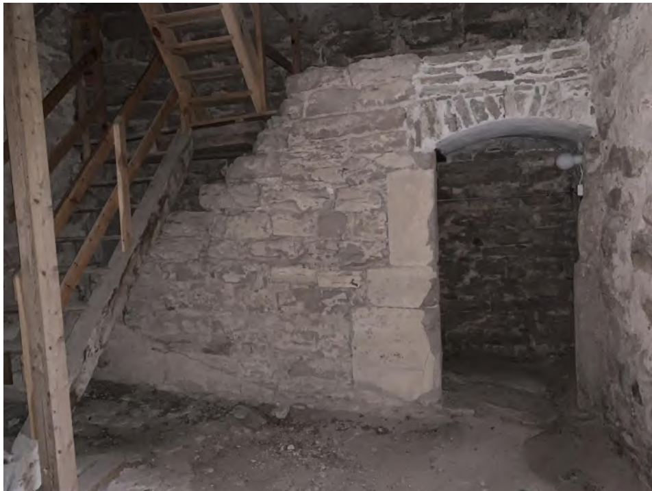
Tornets första övervåning sedd mot söder med mynning från murtrappan. Öppningen försedd med huggna poster och möjligen spår av stängningsanordning. Valvet över öppningen ommurat 2000 efter ras. Till vänster syns trätrappor placerade ovanpå en tidigare murad trappa upp till nästa våning, vars försvunna bjälklag låg i nivå med den murade avsatsen. Foto JL 2019.
