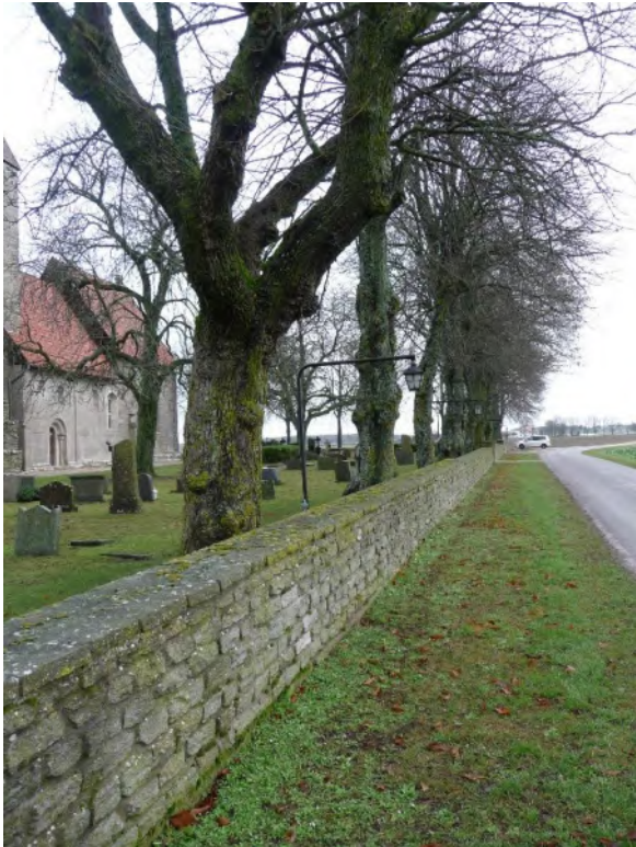
Den södra muren vid landsvägen. Foto ES 2019.
