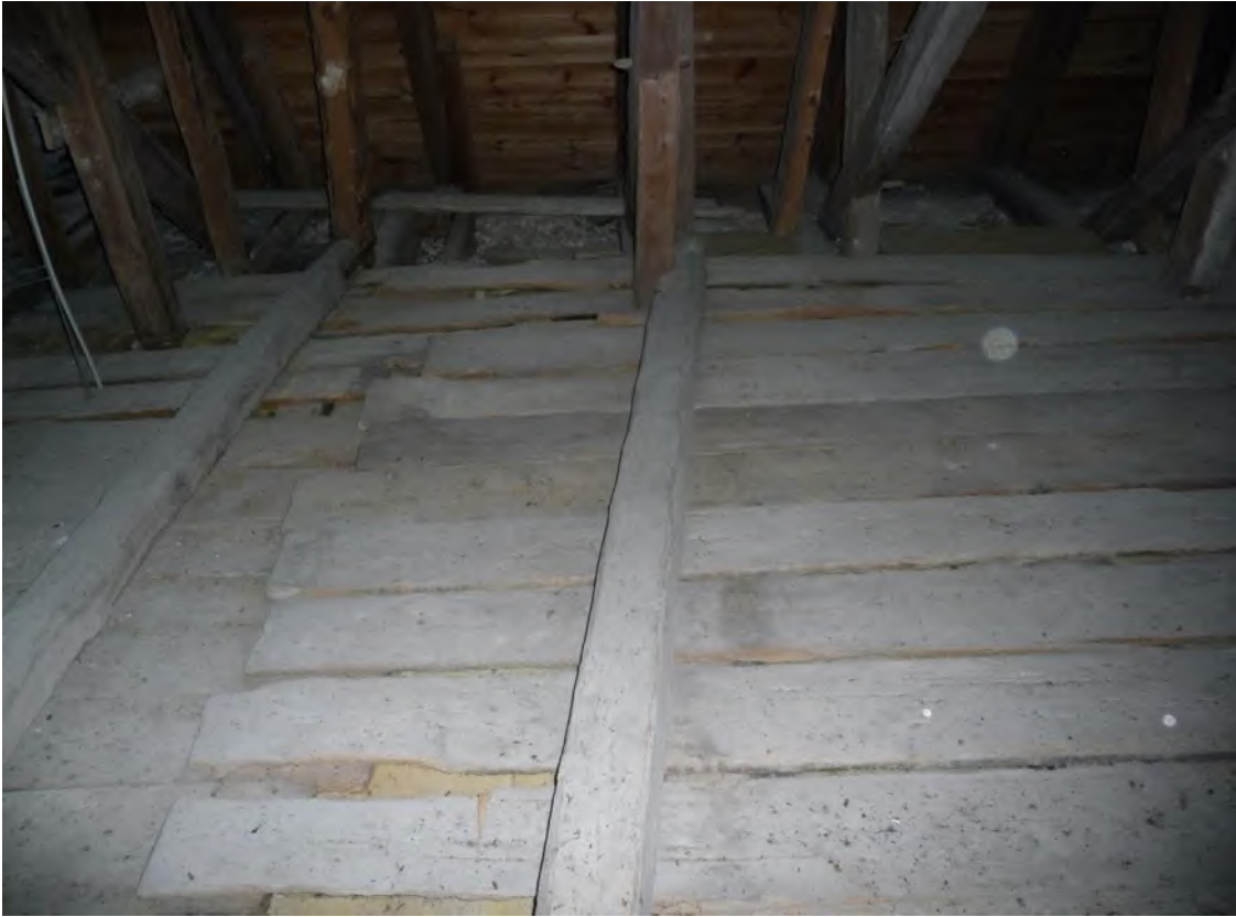
Ovansidan av långhusets innertak. Foto ES 2019.
