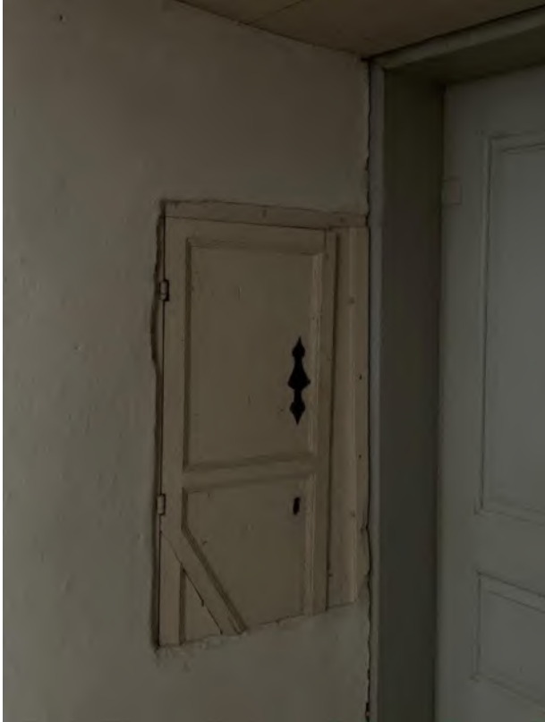
Väggsåp i öppningen till sakristians ingång från koret. Återanvända dörrar sannolikt från medeltida ej bevarad nisch med spetsig överdel, förmodligen på samma plats som sakristieingången togs upp. Foto JL 2019.
