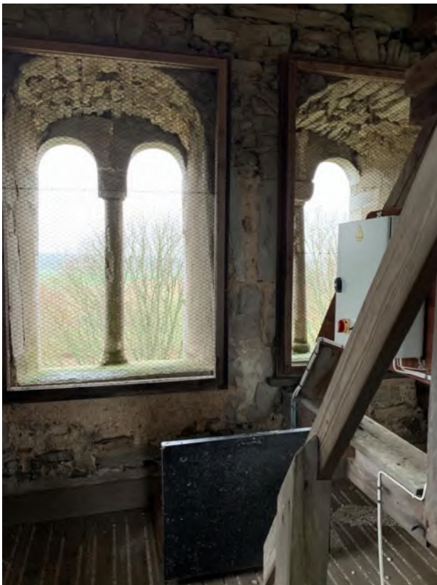
Klockvåningen sedd mot norr med ljudgluggarna sedda inifrån. Foto JL 2019.
