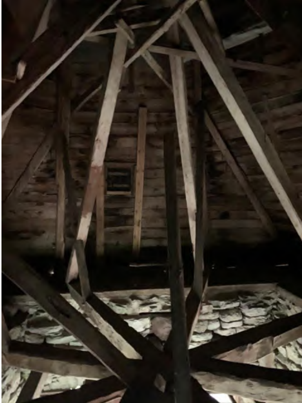
Tornhuvens konstruktion. Foto JL 2019.
