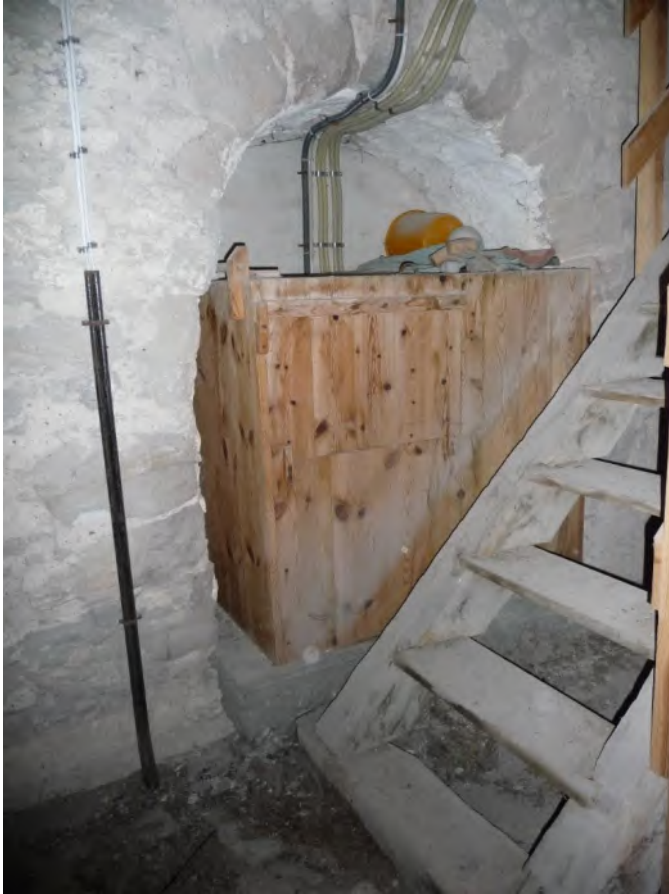
Tornets första övervåning sedd mot öster. Ursprunglig öppning mot långhuset i nivå med långhusfönstren. Förmodligen en emporöppning, det vill säga öppning med fri sikt mot altaret från ett kapell eller avskild kammare i tornet eller utgång till läktare i långhuset av ett slag som på Gotland annars endast är känd från Visby. Igenmurad, troligen sedan 1950-talet, som ersättning för tidigare brädvägg. Ianspråktagen som teknikutrymme och sannolikt på 1990-talet försedd med nuvarande betongplatta och träinbyggnad. Foto ES 2019.
