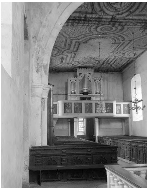
Interiör mot väster före inre ommålning 1910. Kaminen anskaffades ca 1900. Foto Johnny Roosval ca 1905. RAÄ Kulturmiljöbild.
