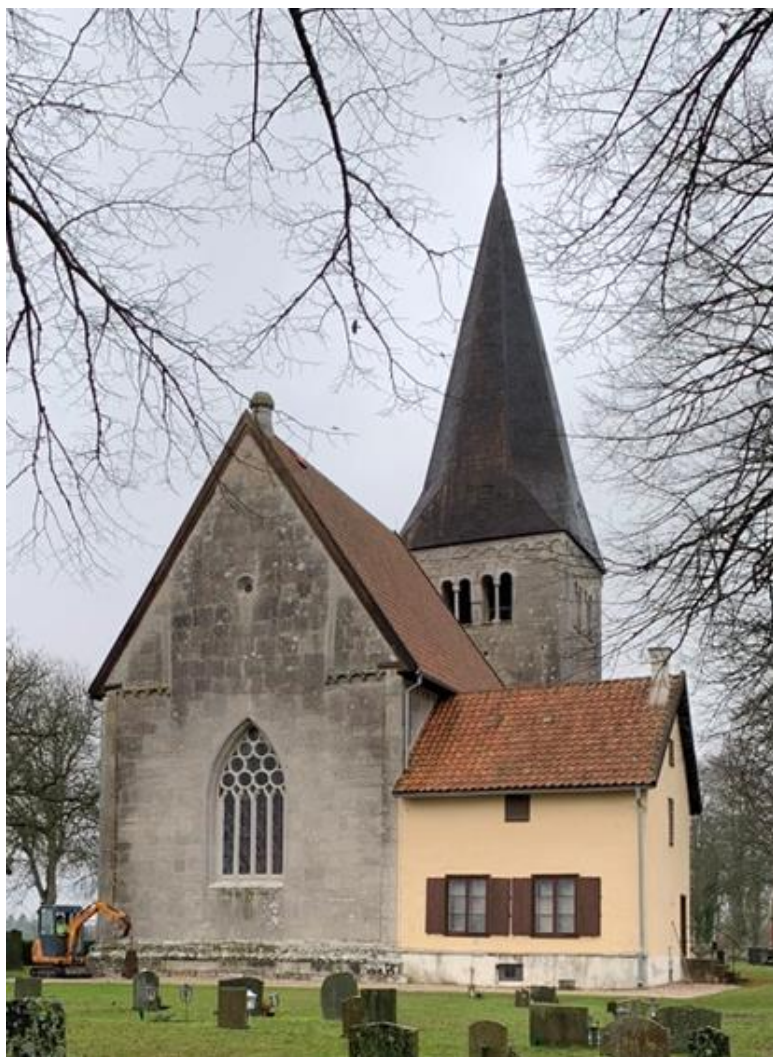
Exteriör från nordöst. Foto JL 2019.
