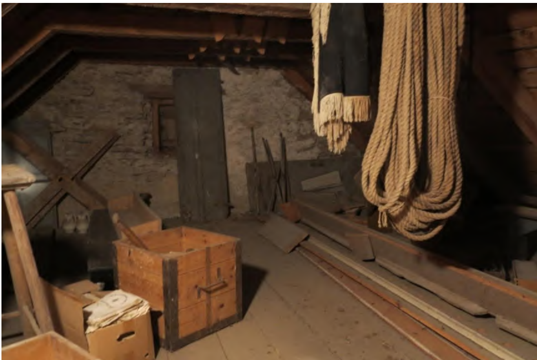
Sakristiebyggnadens vindsvåning. Foto JL 2019.
