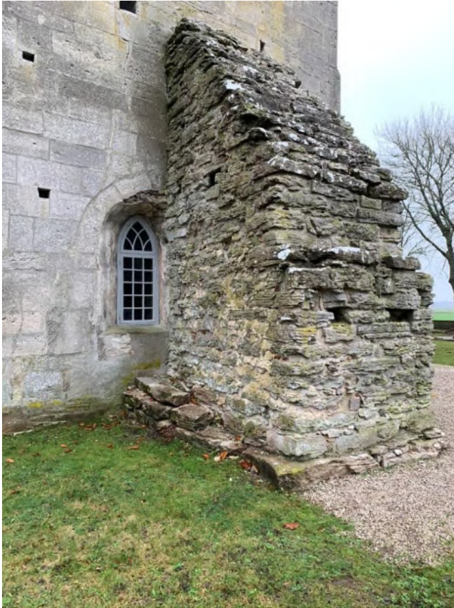
Strävpelare och fönster vid tornets västra sida. Omfattningen kring fönstret hör till en tidigare västportal. Grunden i förhållande till pelarens sneda läge talar för att man först inte avsett att spara öppningen men sedan försökt att spara öppningen. Fönstret tillkom möjligen vid 1800-talets mitt då ringkammaren slutade att användas som magasin. Fönstrets nuvarande form härrör från ca 1870. Foto JL 2019.
