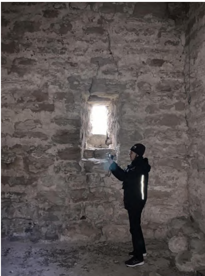
Tornets första övervåning sedd mot väster. Foto JL 2019.
