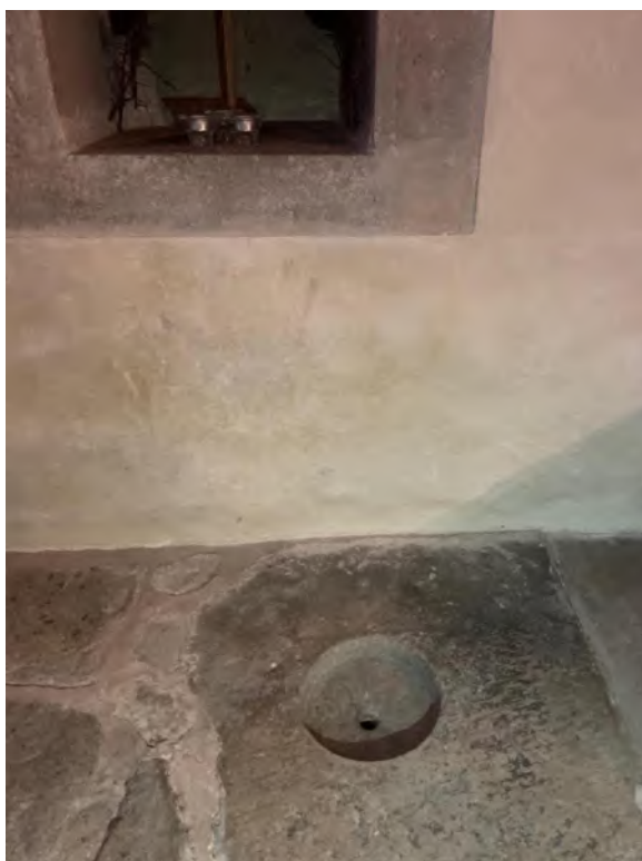
Avrinningshål i korgolvet framför nischerna i korets södra mur. Foto JL 2020.
