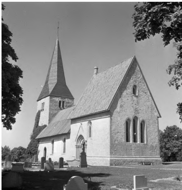
Exteriör från söder efter restaureringen 1935–38. Foto Sören Hallgren 1959, RAÄ, Kulturmiljöbild.
