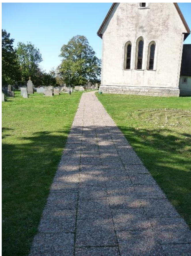
Gång belagd med cementplattor vilken leder fram till kyrkan från öster. Foto ES 2019.
