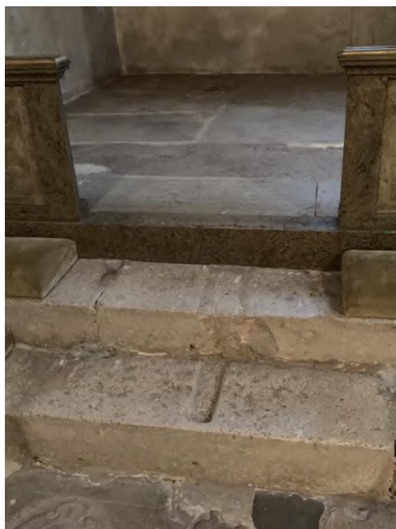
Öppning i altarskranket från 1935-38 och trappsteg med huggen ränna för okänd funktion. Foto JL 2020.
