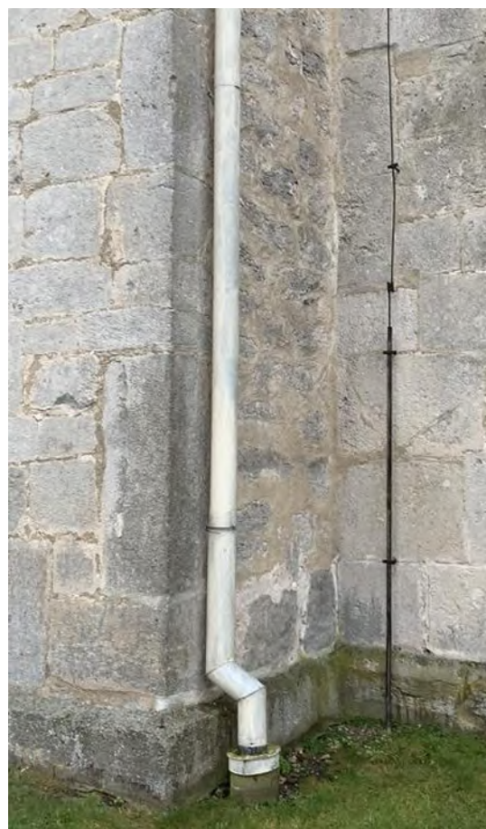
Långhusets norra fasad. Nordvästra hörnet mellan långhus och torn. Ett grövre murverk används i långhusets västra mur än i anslutande kvaderstensmurar. Foto JL 2020.
