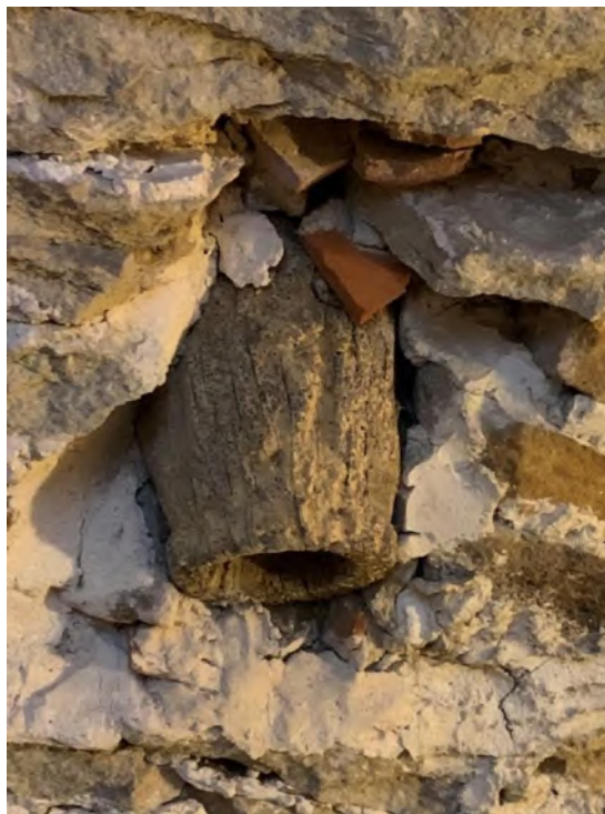
Sturk, träskoning för klockrep i valvet över andra övervåningen. Foto JL 2020.
