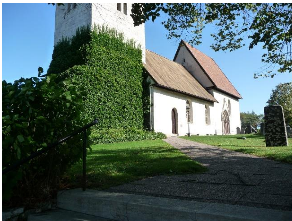
Gång belagd med cementplattor, vilken leder fram till kyrkan från väster. Foto ES 2019.
