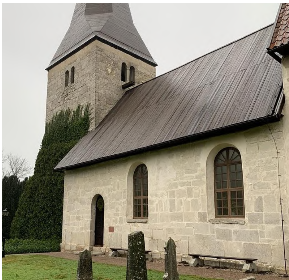
Långhuset södra fasat och tornet från sydost. Foto JL 2020.
