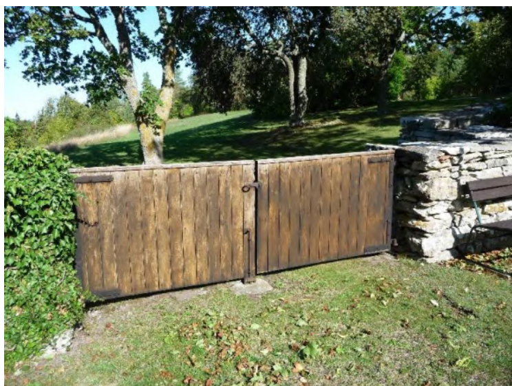
Dubbel trägrind i den norra muren. Foto ES 2019.
