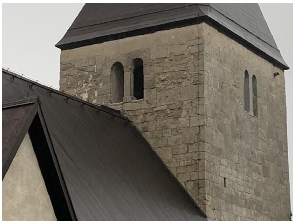
Tornets övre del från nordöst. Till höger en utskjutande bjälke från den ursprungliga tornhuvens nedre bjälklag. Foto JL 2020.
