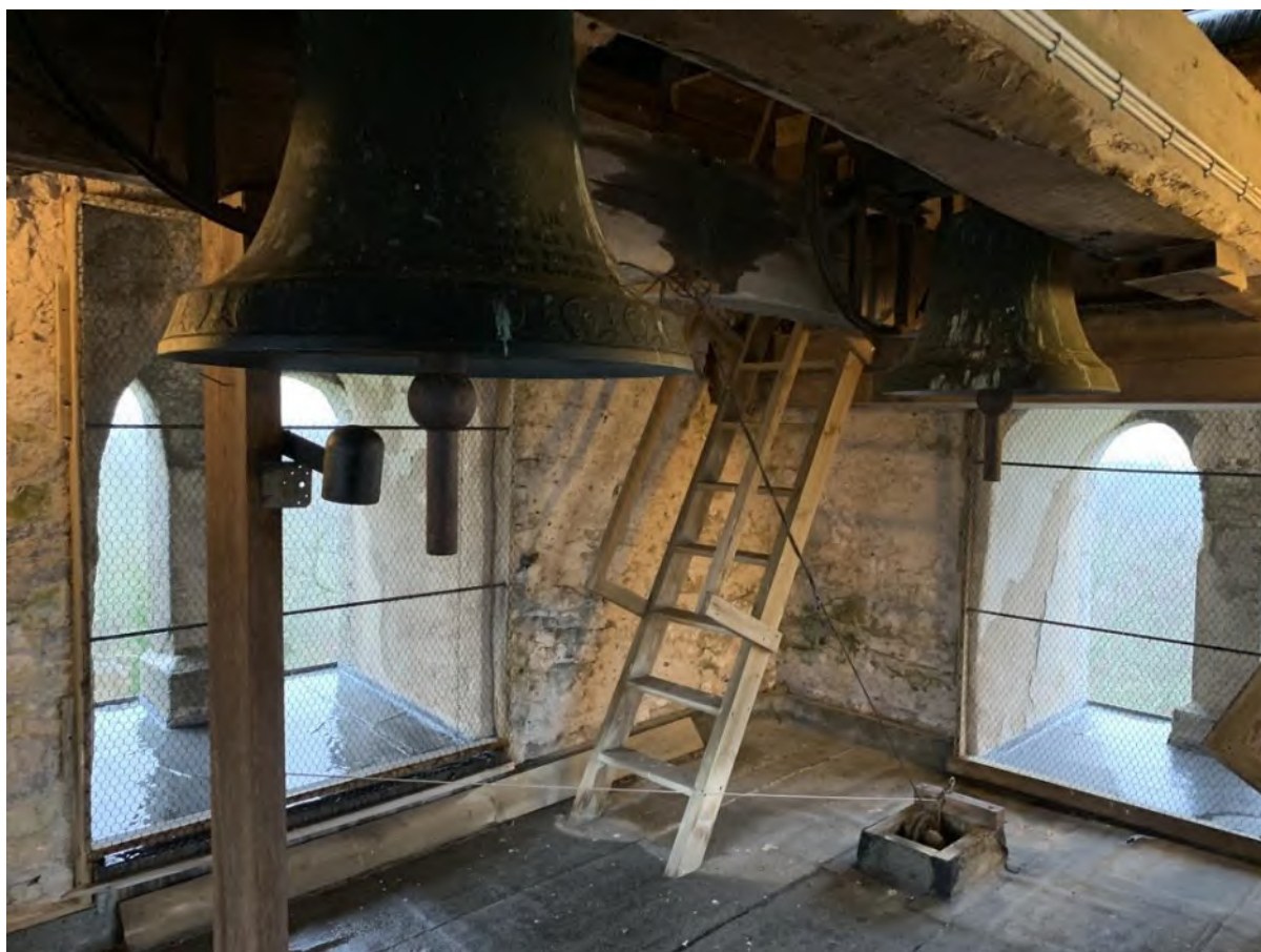
Klockvåningen mot sydväst. Foto JL 2020.
