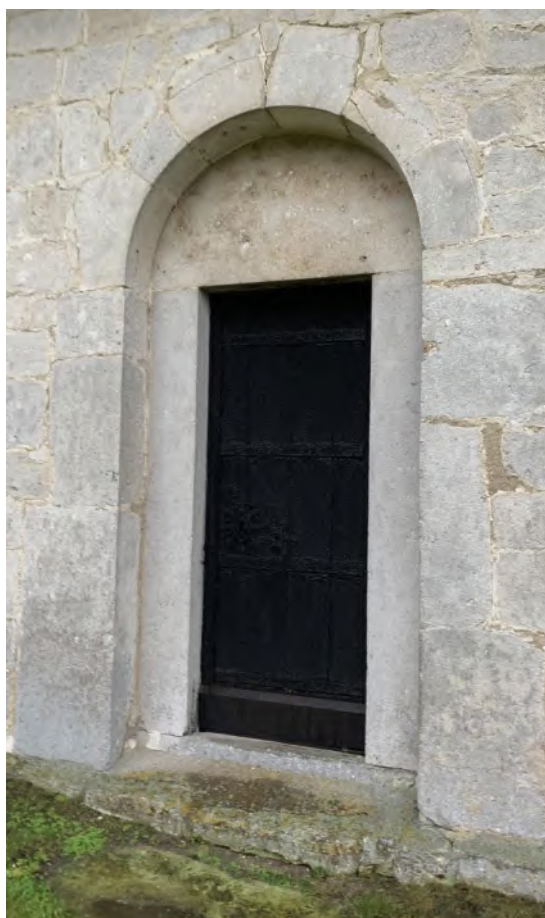
Långhusets norra fasad. Nordvästra hörnet mellan långhus och torn. Ett grövre murverk används i långhusets västra mur än i anslutande kvaderstensmurar. Foto JL 2020.
