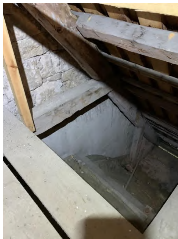
Triumfbågsmurens södra del från långhusvinden med putsad yta. Foto JL 2020.
