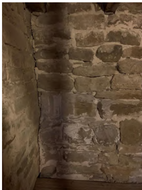
Till vänster: Öppning, före 1935 utgång till vinden. Till höger: Sydöstra hörnet i tornets första övervåning med stötfog som visar att tornet är yngre än långhuset. Foto JL 2020.
