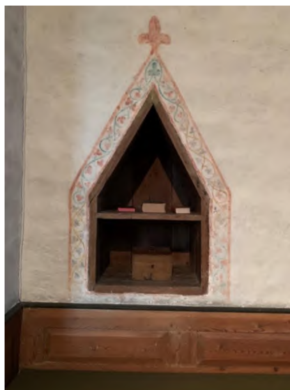
Nisch i korets norra mur bakom korbänken. Foto JL 2020.
