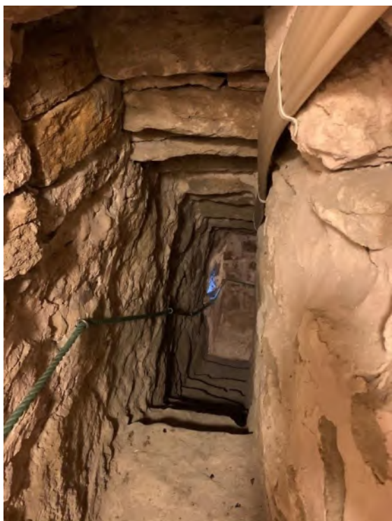
Trappa i tornets norra mur mellan andra och tredje våningen, sedd uppifrån mot öster. Foto JL 2020.
