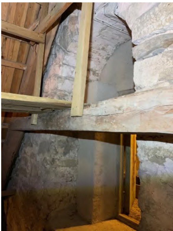
Välvd öppning i triumfbågsmuren, sedd från långhusvinden. Foto JL 2020.
