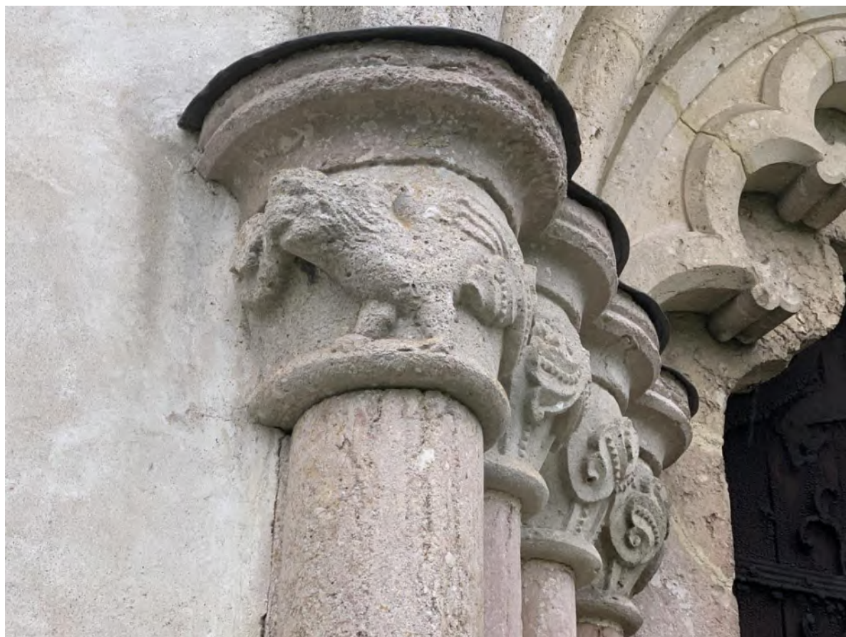
Korportalens västra kapitälband, detalj. Foto JL 2020.
