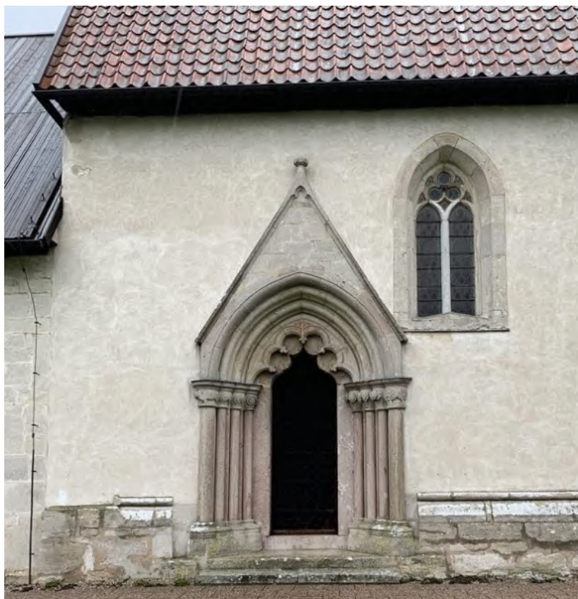
Korportalen och södra korfönstret. Observera sockelns anslutning till portalen och förtagningen för ett ej utfört långhus. Foto JL 2020.
