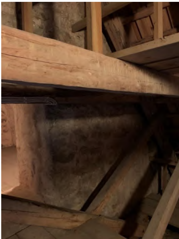
Långhusets västra gavel, sedd från långhusvinden. Foto JL 2020.
