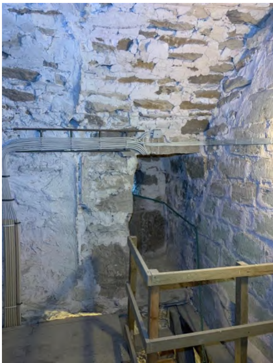
Tornets andra övervåning. Öppning till murtrappan till klockvåningen. Foto JL 2020.
