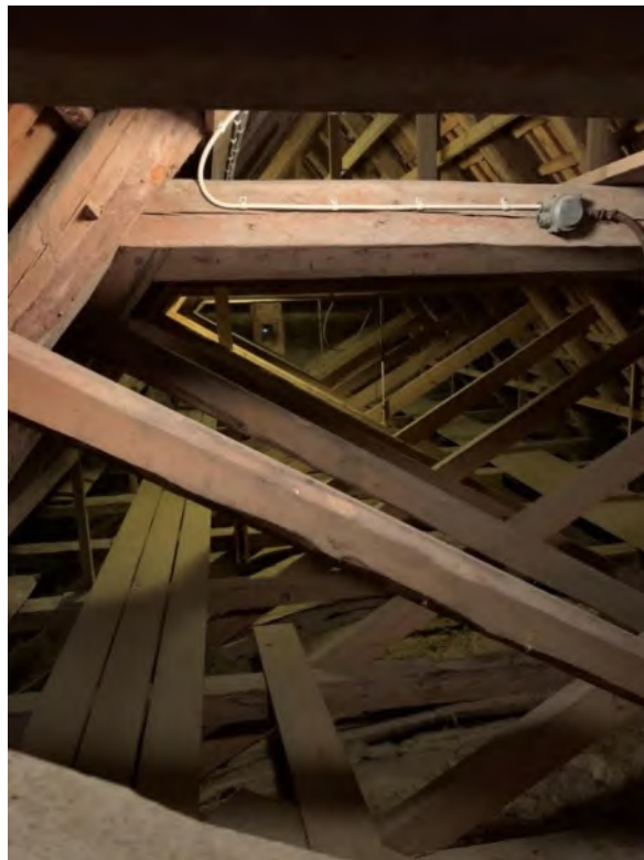
Långhusets takstol sedd mot öster. Foto JL 2020.
