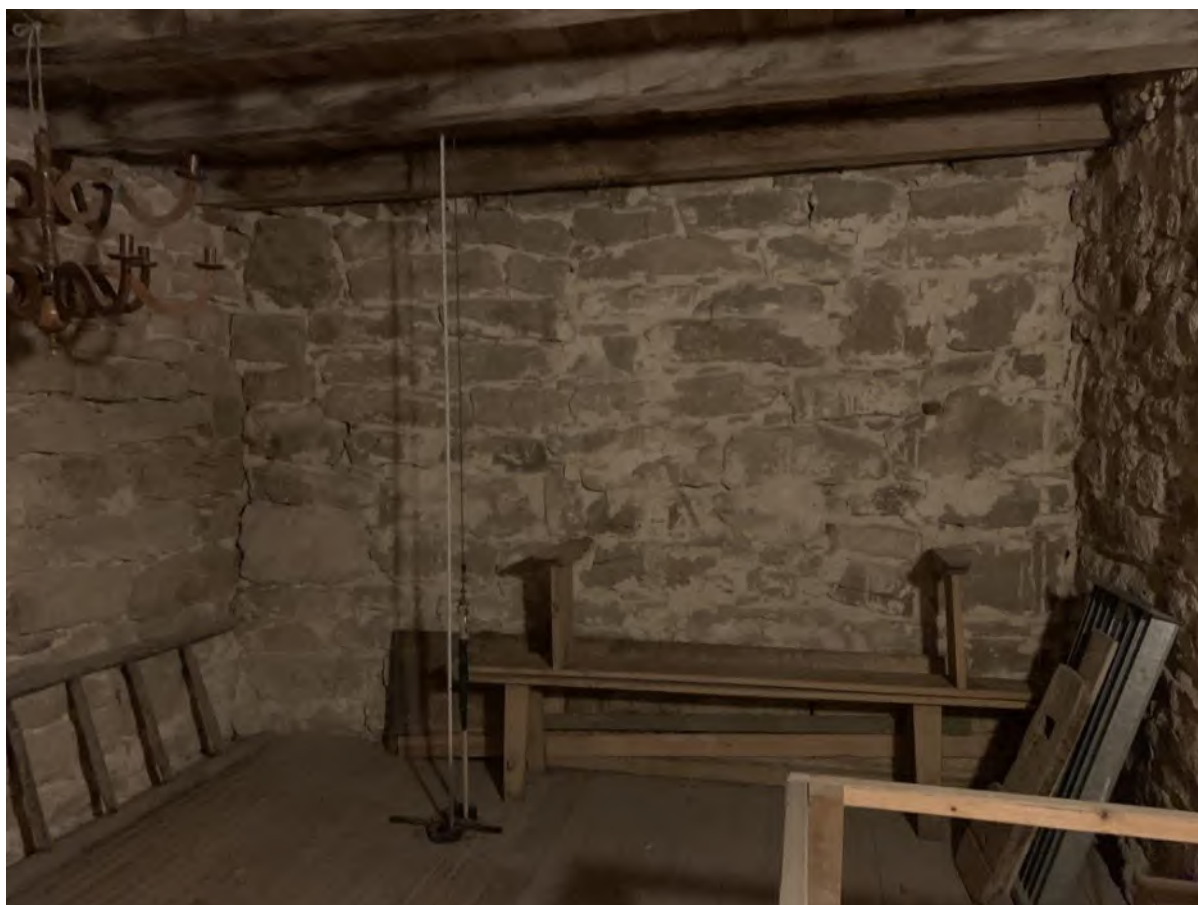
Tornets första övervåning sedd mot väster. Foto JL 2020.
