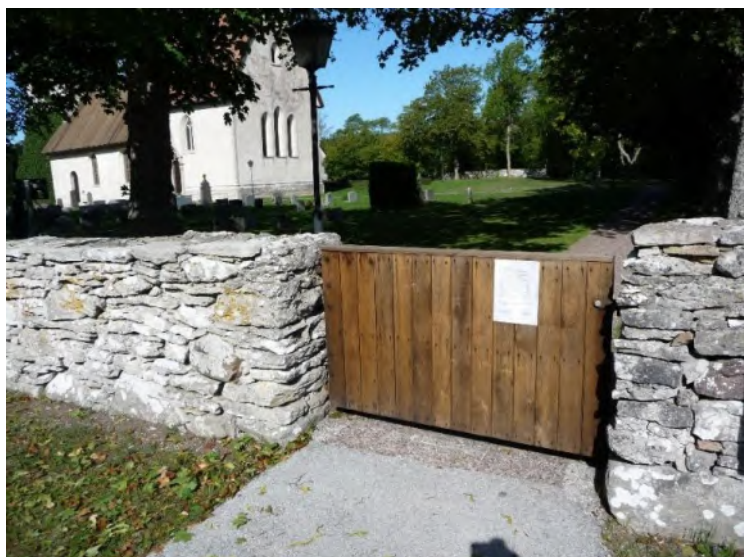
Enkel trägrind i den södra muren vid parkeringen. Foto ES 2019.
