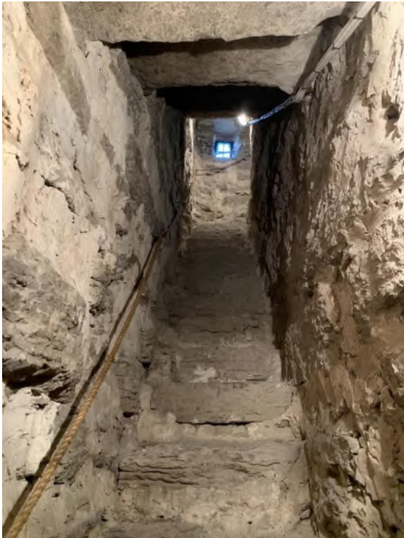
Murtrappa i tornets västra mur. Foto JL 2019.
