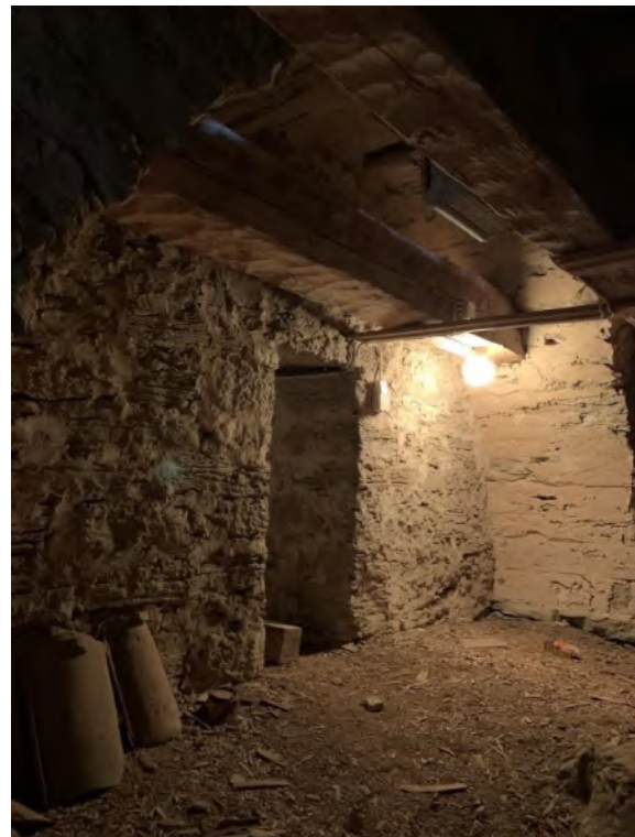
Tornets första övervåning sedd mot sydöst. Sparbåge i östra tornmuren med ingång till långhusvinden. En av de kraftiga bjälkar som ligger inne i murverket. Foto JL 2019. Nordportalens västra kapitälband. 1200-talets slut. Foto JL 2019.
