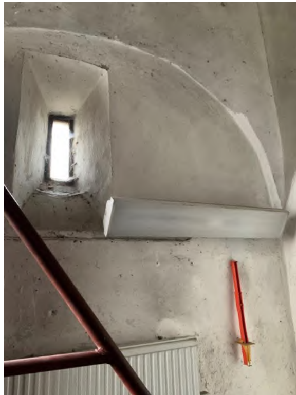
Driftrum i sakristiebyggnadens västra kammare sedd mot, inredd till pannrum 1908 då golvet sänktes. Valv och murar och muröppningar medeltida. Interiör mot väster och norr Foto JL 2019.
