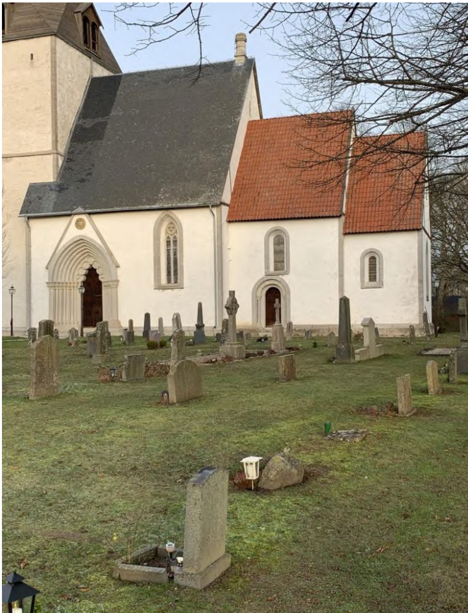
Långhus, kor och korutsprång från sydöst. Långhusportalens vimperg avskuren. Inget talar för att taket sänkts, utan portalen synes från början varit för stor för sin plats. Foto JL 2019.
