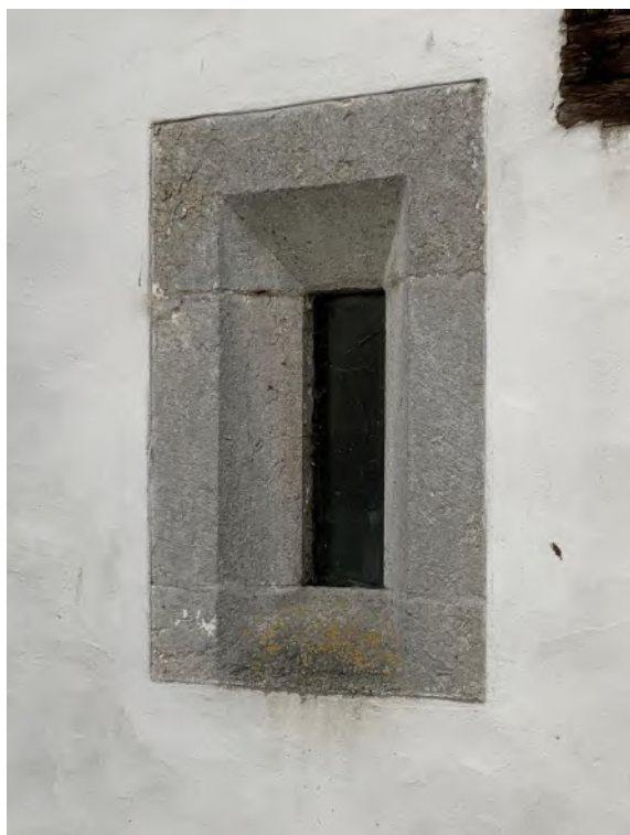
Fönsteröppning i sakristians östfasad. Foto JL 2019.
