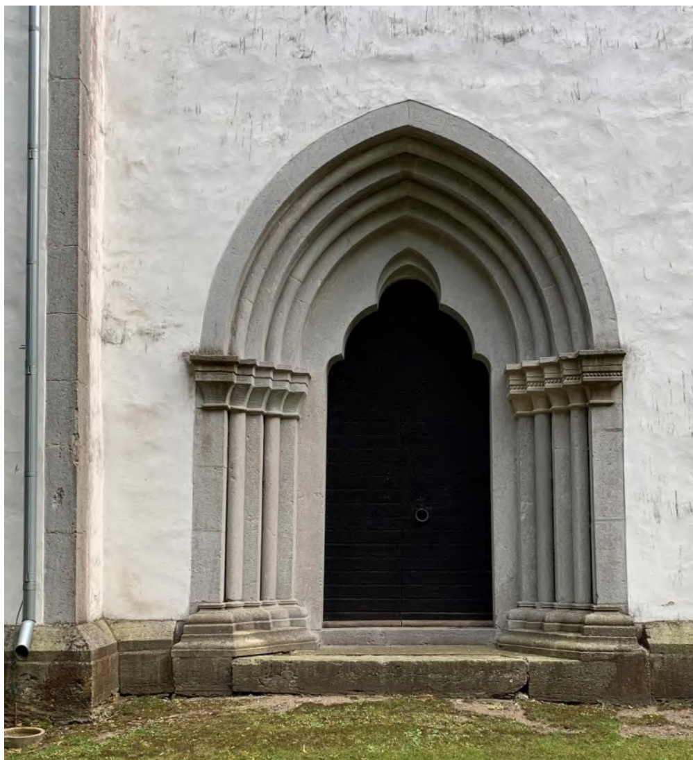
Nordportalen. Foto JL 2019.
