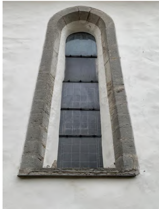
Långhusets norra fönster, sannolikt det ursprungliga östfönstret från 1200-talets förra hälft, flyttat till långhuset och förstorat vid 1200-talets slut. Foto JL 2019.
