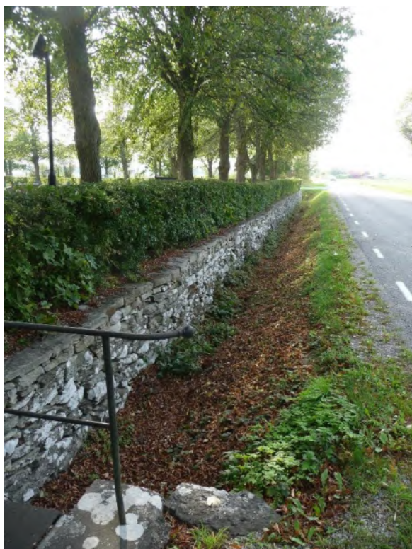
Den västra terrassmuren vid landsvägen. Foto ES 2019.
