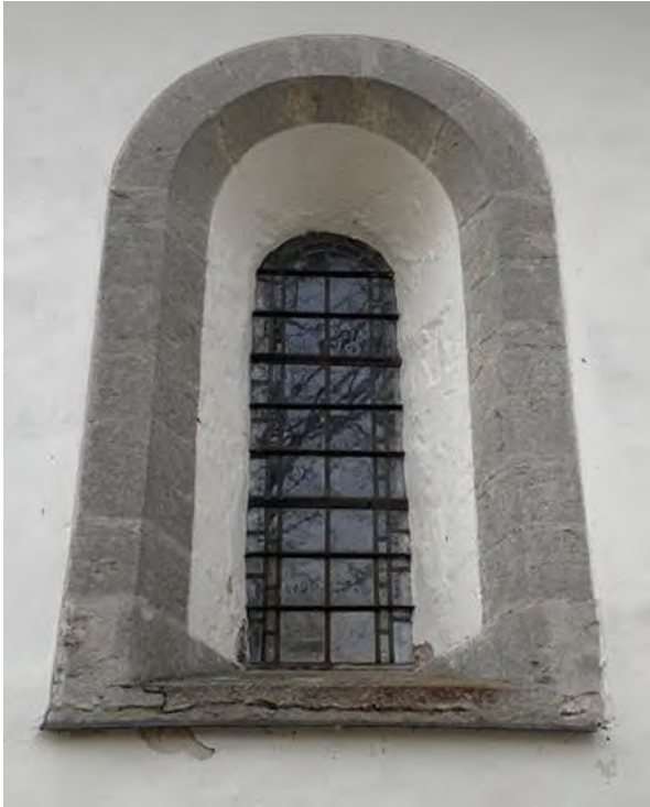
Korutsprångets norra fönster. 1200-talets förra hälft. Foto JL 2019.
