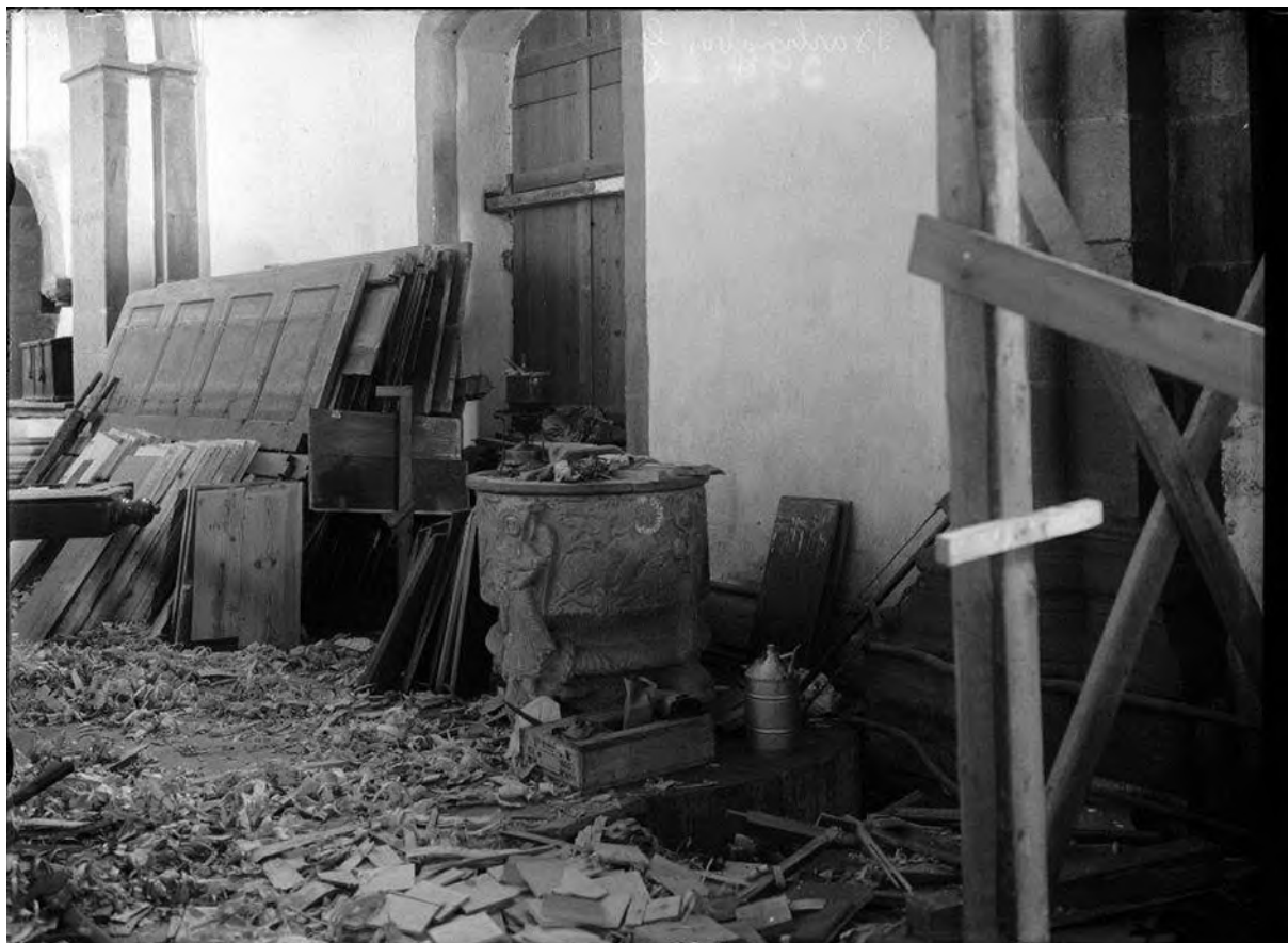
Koret under restaureringsarbeten 1924. Foto Alfred Edle 1924. RAÄ, Kulturmiljöbild.
