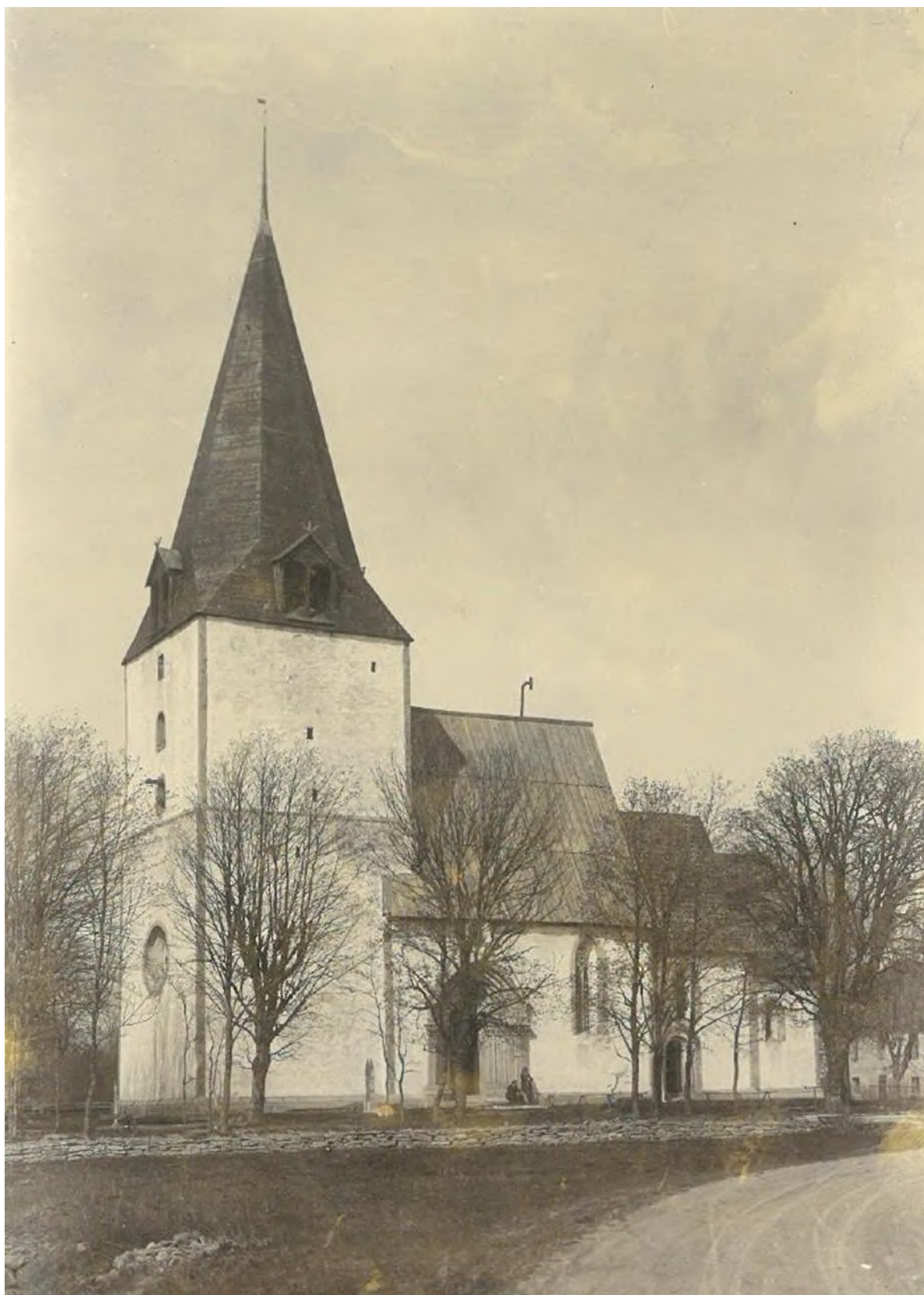
Äldre foto av kyrkan från sydväst. Observera långhusets faltak, kaminröret över taket samt hissbomen i en av tornets lastportar. Foto Louis Nilsson omkring 1900. GF arkiv.
