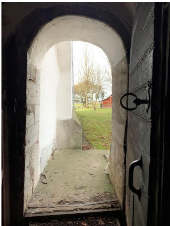
Driftrum i sakristiebyggnadens västra kammare sedd mot, inredd till pannrum 1908 då golvet sänktes. Valv och murar och muröppningar medeltida. Interiör mot väster och norr Foto JL 2019.
