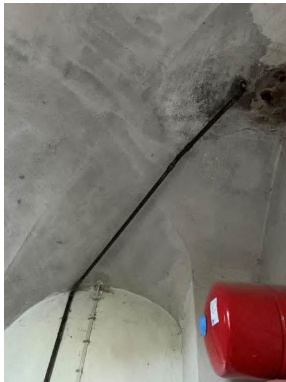
Driftrum i sakristiebyggnadens västra kammare sedd mot sydöst, inredd till pannrum 1908 då golvet sänktes. Valv och murar medeltida utom skorstensstocken i hörnet. Igensatt men ej skönjbar passage till sakristian i väggen till vänster. Till höger valvet. Foto JL 2019.
