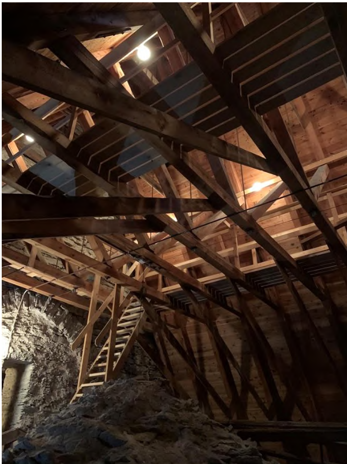
Långhusets vind sedd uppåt mot nordväst. Foto JL 2019.
