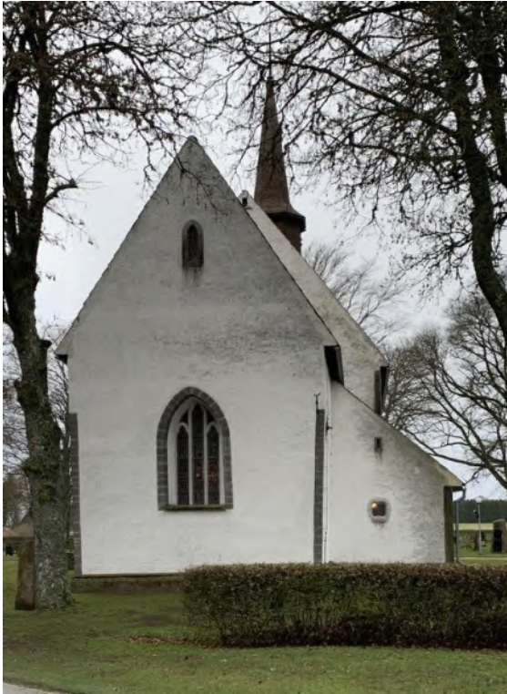
Exteriör från nordväst. Foto JL 2018.
