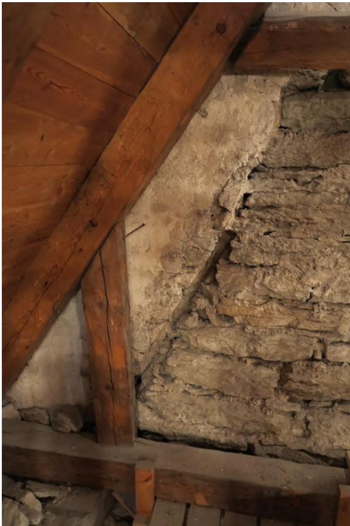
Korets vind mot sydväst med avtryck av det tidigare taket före 1860. Foto JL 2019.
