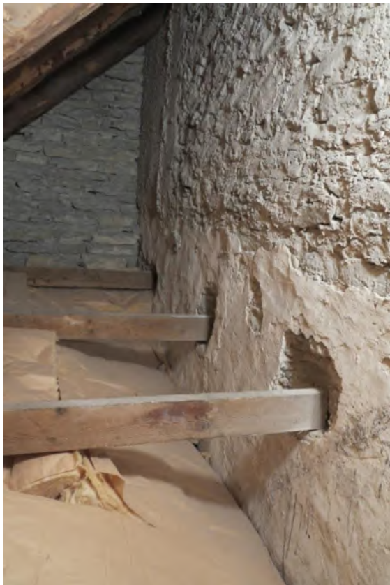
Sakristians vind, mot öster. Till höger korets nordmur med påbyggnad från 1860. Foto JL 2019.
