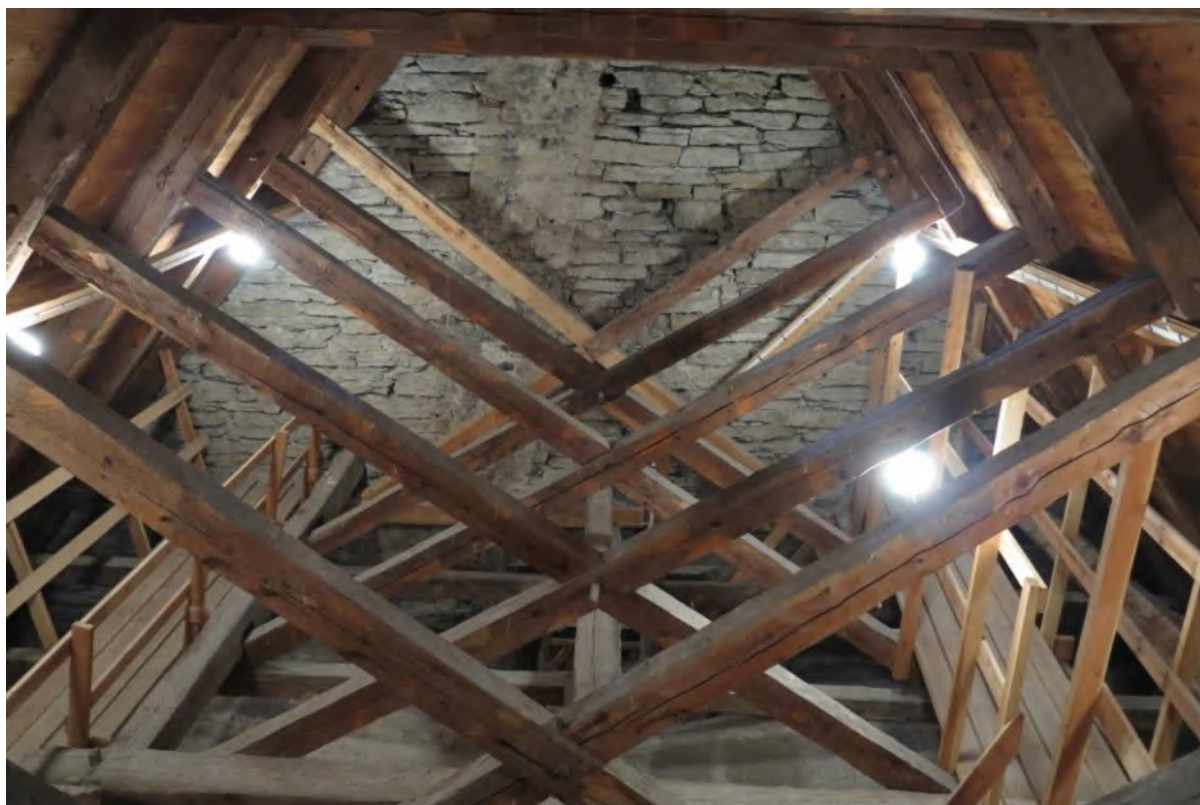
Långhusets vind mot öster. Foto JL 2019.
