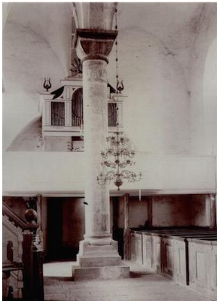
Interiör mot väster omkring 1900. Predikstolen flyttad till södra sidan, men bänkinredning och läktare kvar. Foto Louis Nilsson, Gotlands Museums arkiv.
