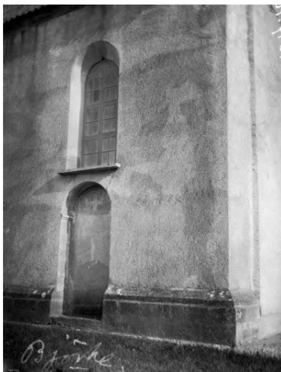
Kyrkans nordvästra hörn med den då igenmurade nordportalen och ett fönster ovanför denna. Portalen återupptagen och fönstret igenmurat ca 1900-ca 1910. Foto omkring 1900. RAÄ, Kulturmiljöbild.
