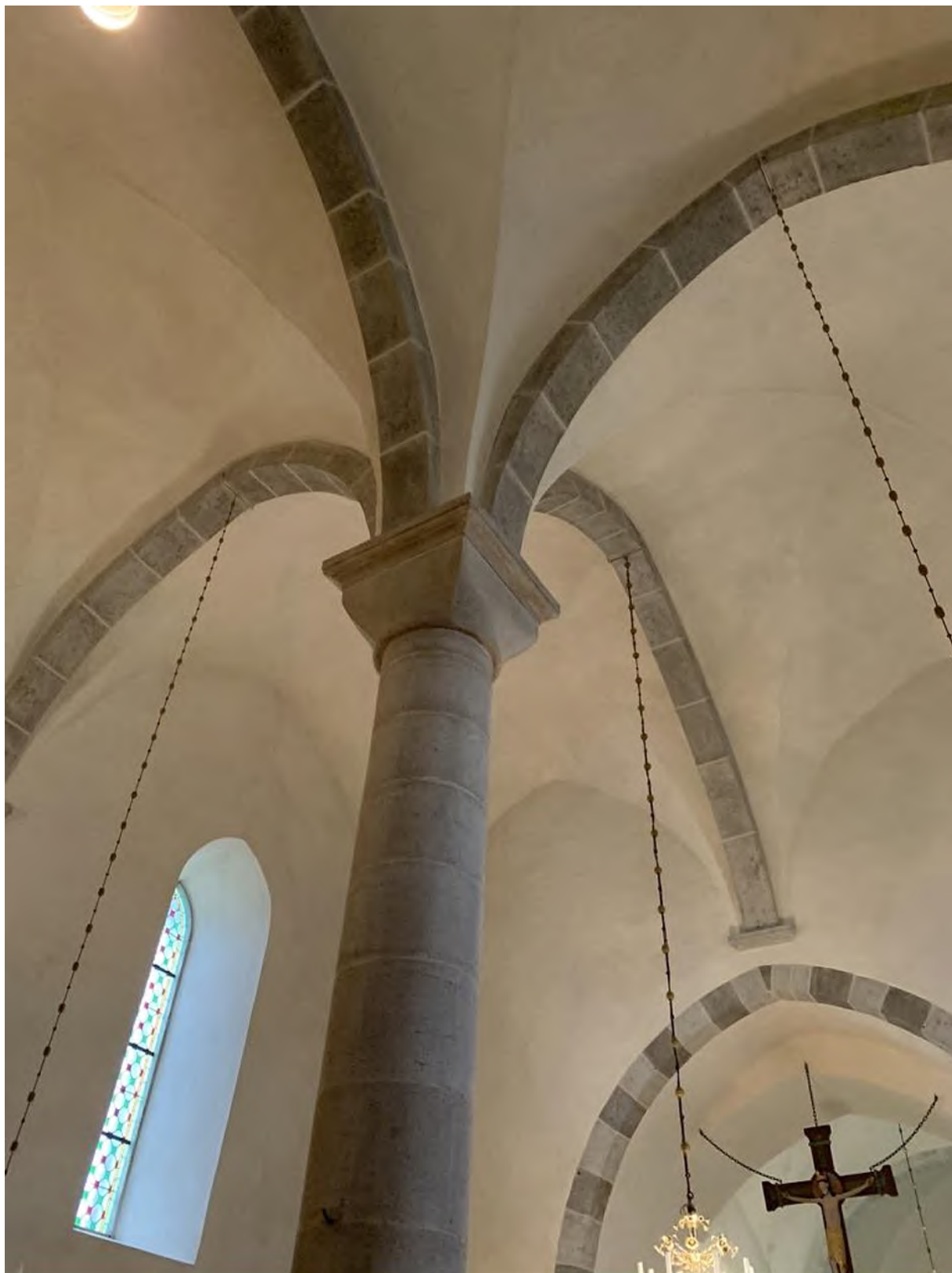
Långhusvalven, sedda underifrån mot nordöst. Foto JL 2019.
