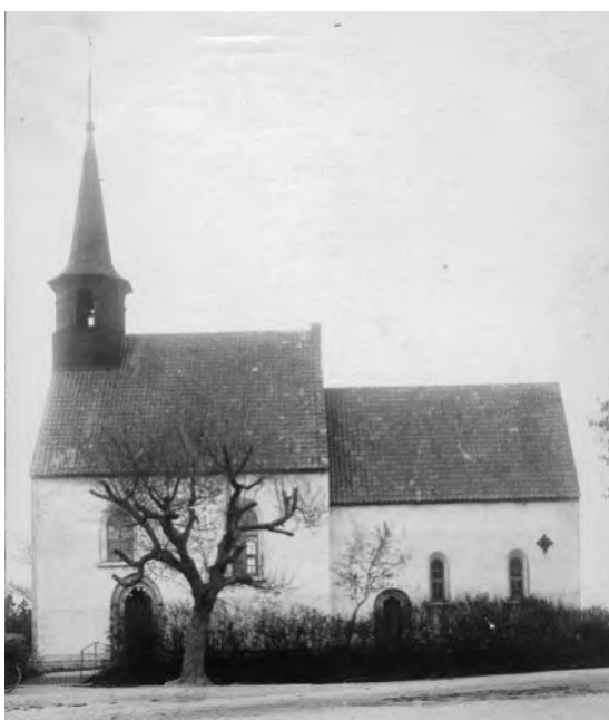
Kyrkans södra fasad efter takets ombyggnad 1860. Äldre foto omkring 1900. RAÄ, Kulturmiljöbild.
