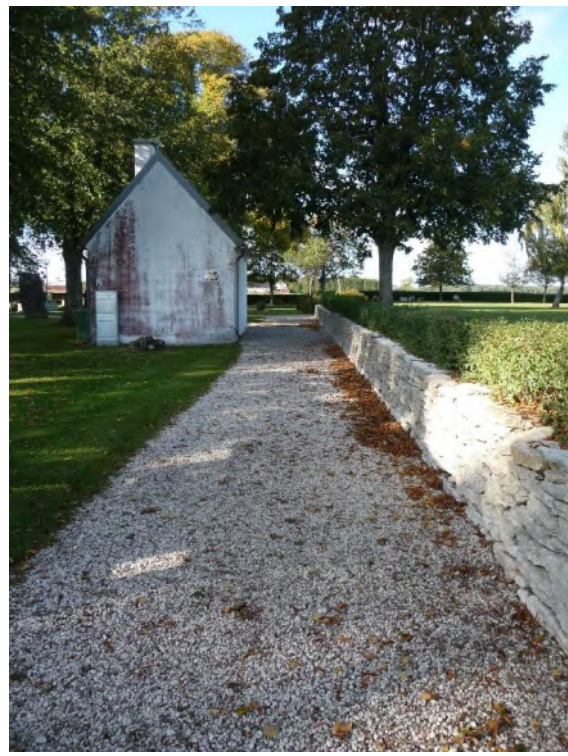
Grusad gång mellan den äldre och yngre kyrkogården. Till vänster syns ett pannrum, uppfört 1980. Foto ES 2019.
