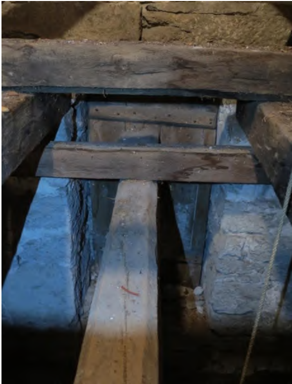
Planerad passage mellan långhusvind och tornets första övervåning, senare sannolikt använd som lastport. Överputsad utvändigt, troligen sedan 1860. Foto JL 2019.
