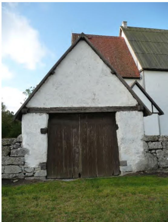
Stiglucka i den norra muren, fotograferad från norr. Foto ES 2019.
