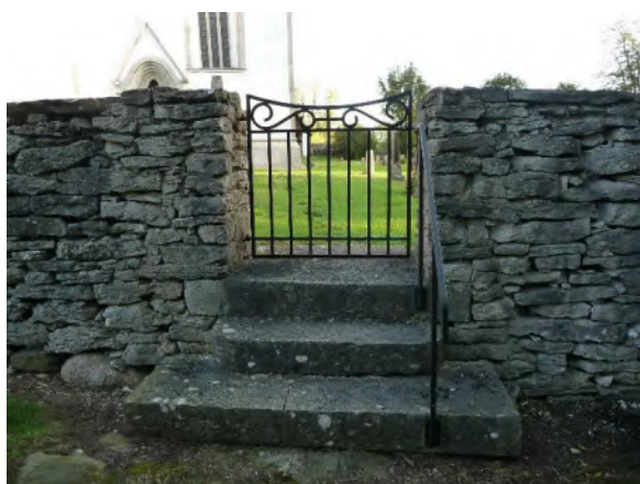
Den södra ingången. Foto ES 2019.
