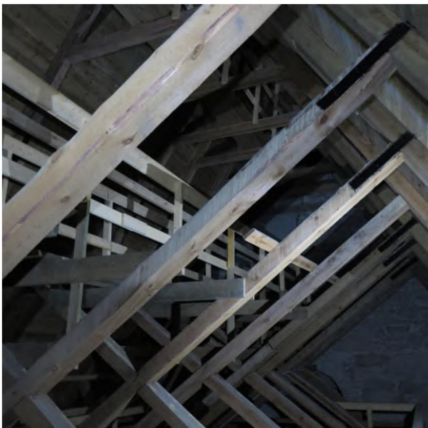
Långhusets vind sedd mot sydväst. Takstolen nybyggd på 1900-talet med den äldre som förebild. Foto JL 2019.
