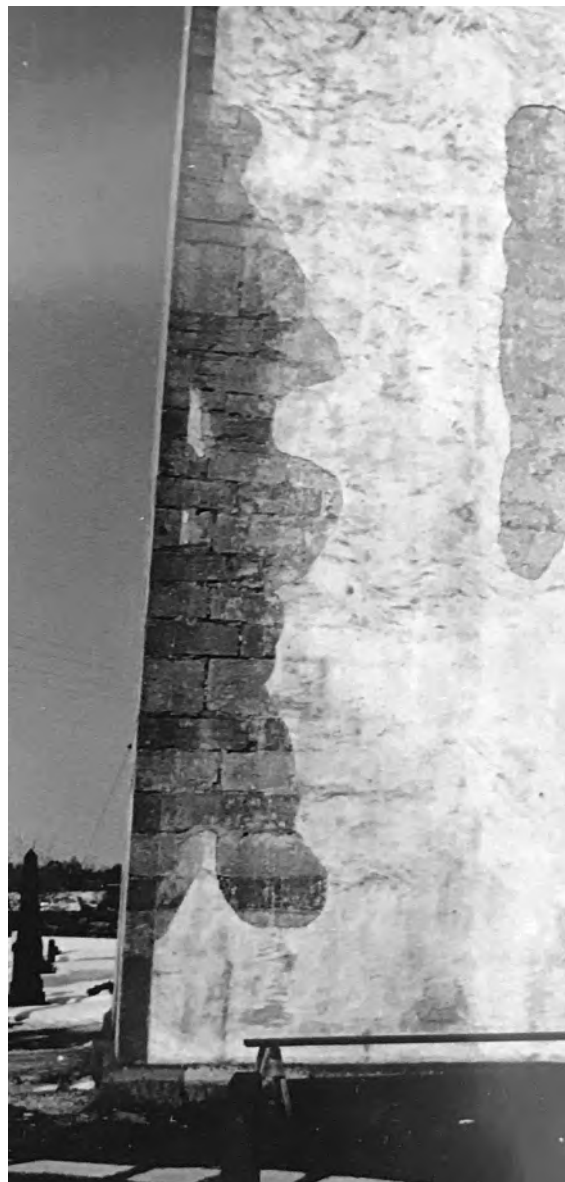
Del av tornets ursprungliga murverk med växling av grå och rosa stenskit. Svartvitt foto ca 1970. ATA K-byråns arkiv.
