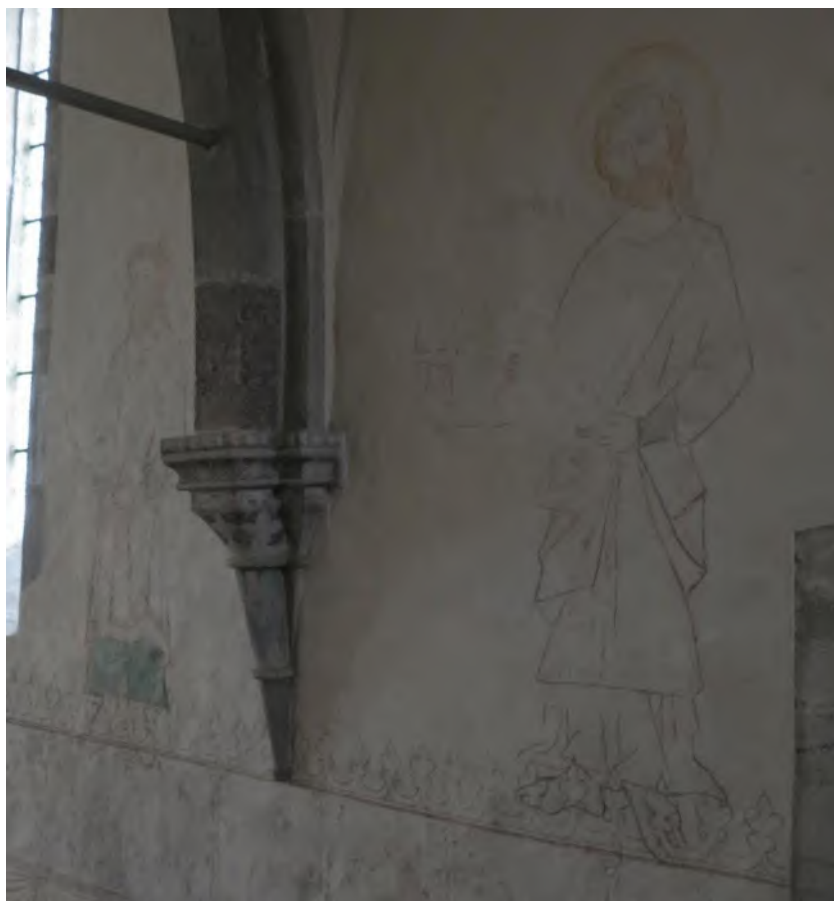
Långhusets södra mur med kalkmålningar av apostlar i stor skala. Skisserade grundlinjer från 1200-talets slut till kalkmålningar ifyllda 1942-43. Foto JL 2019.
