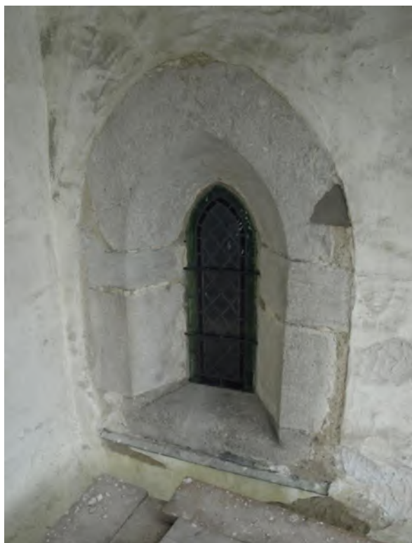
Fönster på södra sidan av långhusets västgavel, sett från byggnadsställning under yttre restaurering. Foto 20100817 P8165420, Gotlands Museum 2010.
