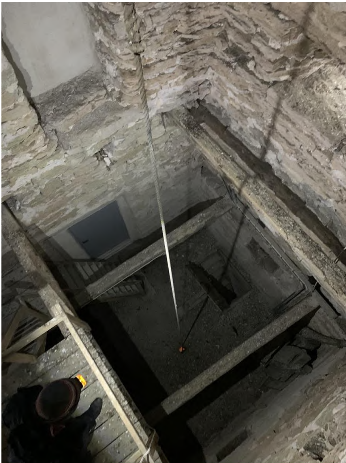
Tornets första övervåning sedd uppifrån. Bjälkarna markerar nivån för tidigare mellanvåningar. Den grå stäldörren är placerad i den östra ursprungliga ljudgluggen. Foto JL 2019.
