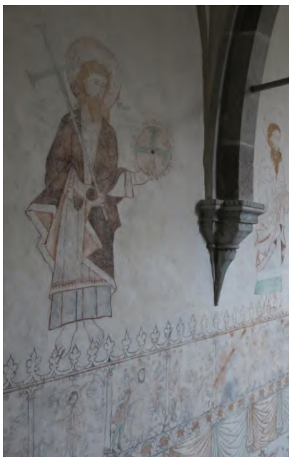
Långhusets norra mur med kalkmålningar av apostlar i stor skala från 1200-talets slut och passionssvit från 1400-talet, framtagna 1942–43. Foto JL 2019.
