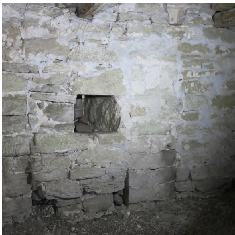
Tornets första övervåning, ursprungligen klockvåning, sedd mot väster med spår av igenmurad tidigare ljudglugg. Foto JL 2019
