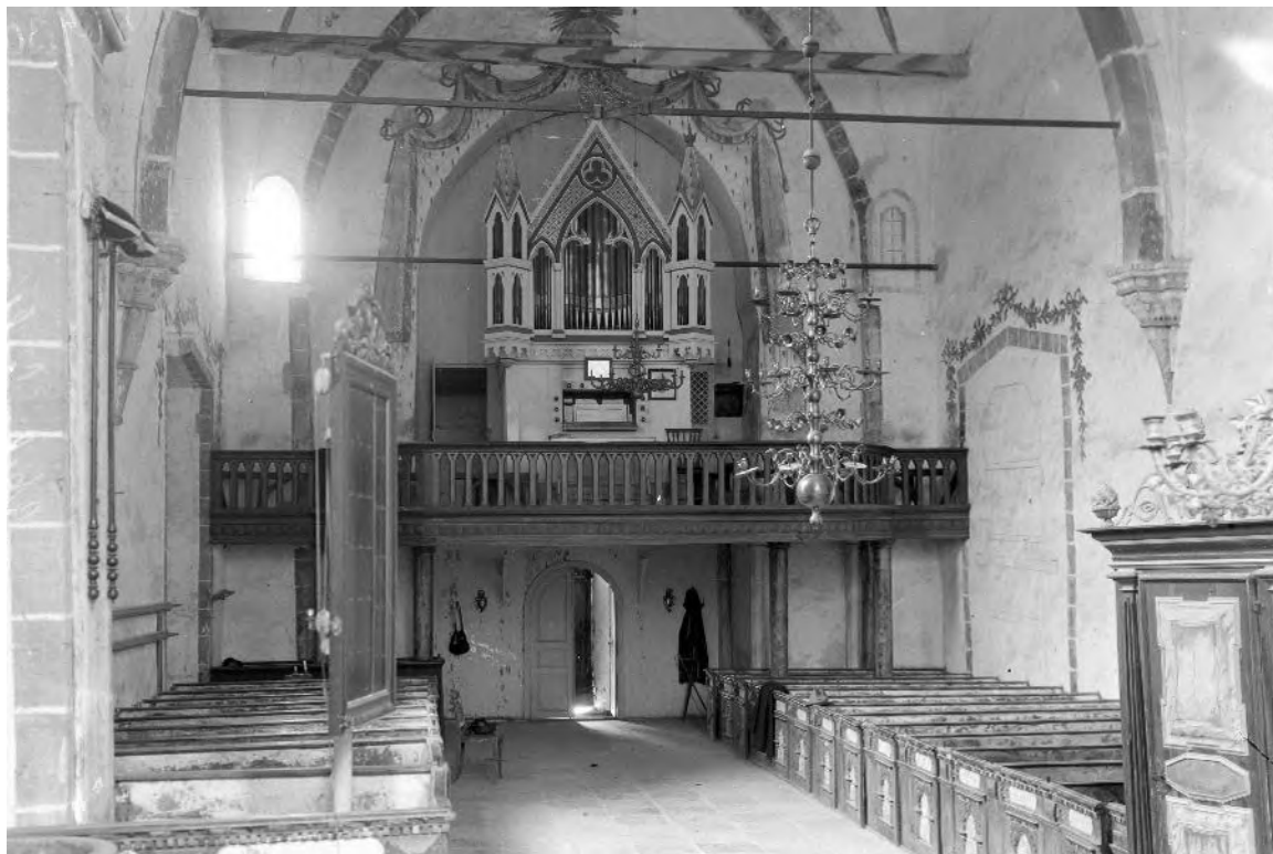
Interiör mot väster före restaureringen 1942–43. Foto Sven Brandel 1923. RAÄ, Kulturmiljöbild.
