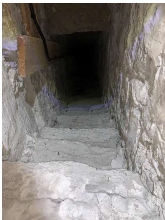
Den branta trappan i korets norra mur sedd mot väster och nästan rakt uppåt. Foto JL 2019.
