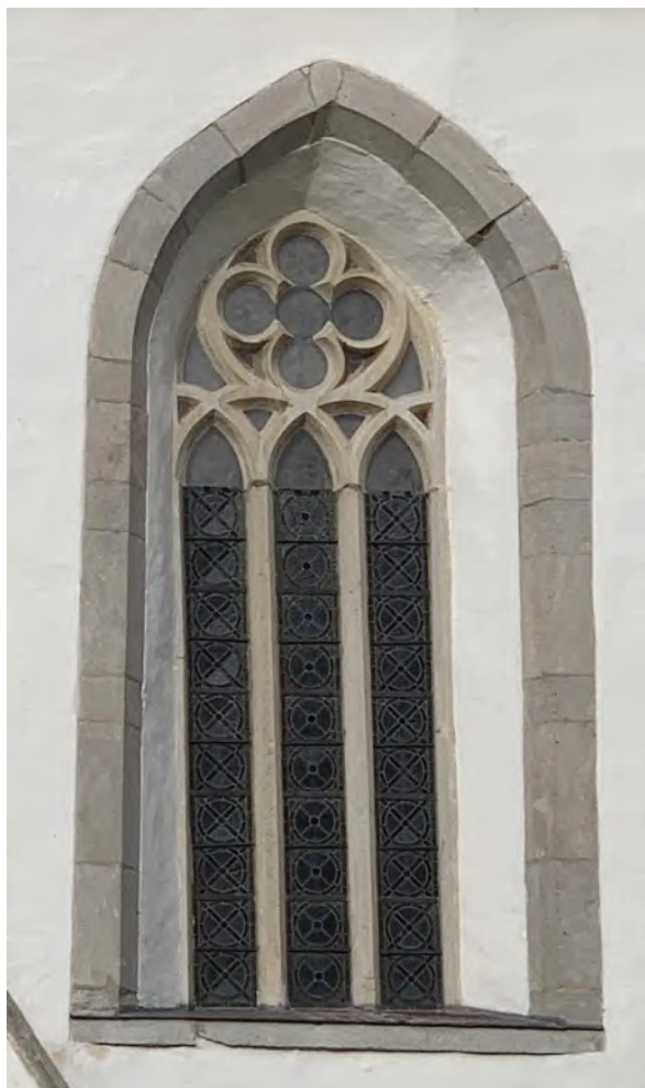
Korets södra fönster. Foto JL 2019.
