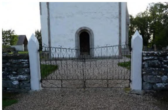
Den västra ingången med järngrind och grindstolpar i trä. Foto ES 2019.
