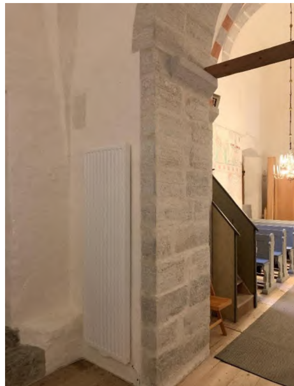
Triumfbågens södra vederlag och korets sydvästra hörn. Foto JL 2019.
