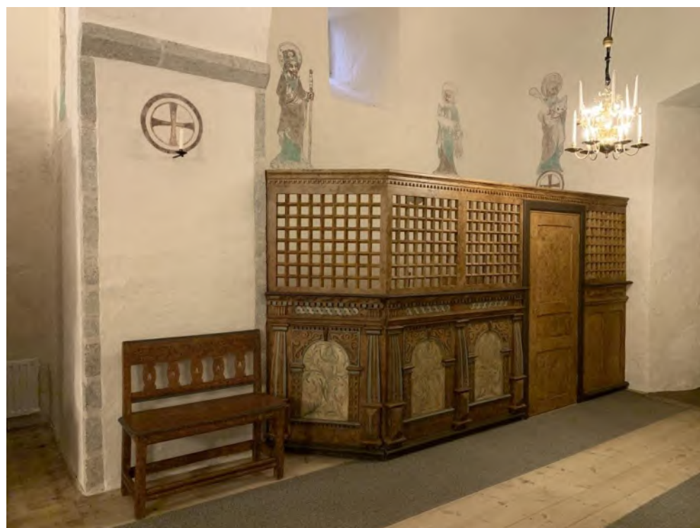
Ringkammaren sedd mot sydväst. Skärmvägg kring förvaringsrum, byggd 2017 med infogade delar av den tidigare korbänk som före 1930 utgjorde sakristia i koret. Till vänster brudbänk från 1700-talet. Foto JL 2019.
