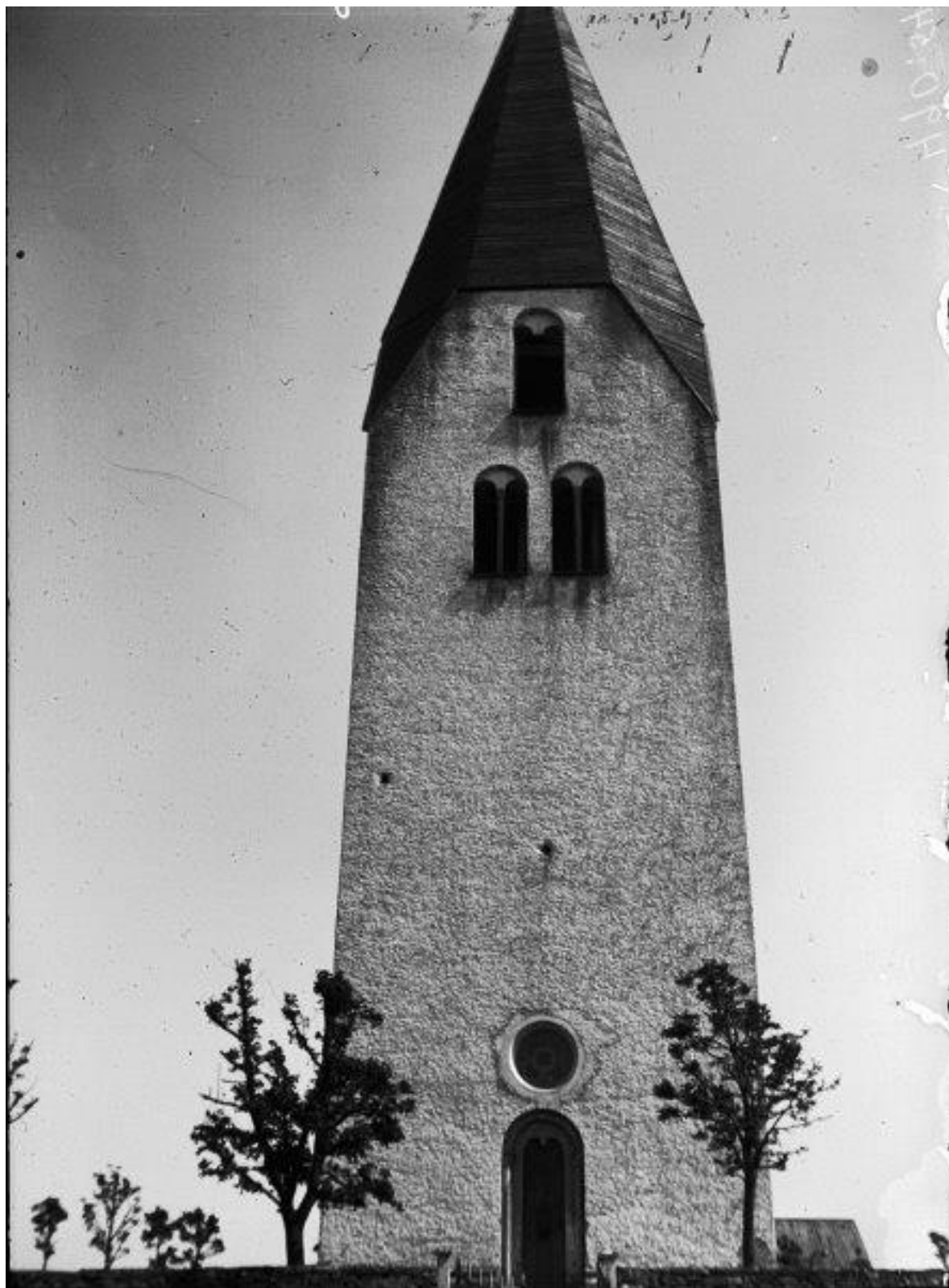
Tornet sett från väster. Bilden visar tornhuvens form innan den brandskadades 1900 och att den nya från 1901 följde den gamlas form. Spritputsen är från 1857. Rosettfönstret från 1882 med masverk ritades av Emil Langlet och sattes igen troligen 1966–67. Foto Oscar Almgren 1899. RAÄ, Kulturmiljöbild.
