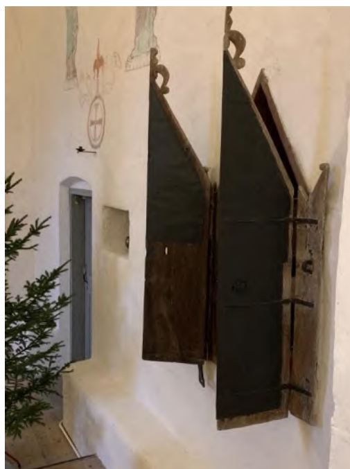
Korets norra mur, sedd mot väster. Närmast medeltida väggsåp med järnfodring, ursprungligen möjligen sakramentsåp. Längre bort ingång från 1930 till sakristian. Nedan murad avsats, förmodligen avsedd som sittbänk med motsvarighet på koret södra mur. Foto JL 2019.
