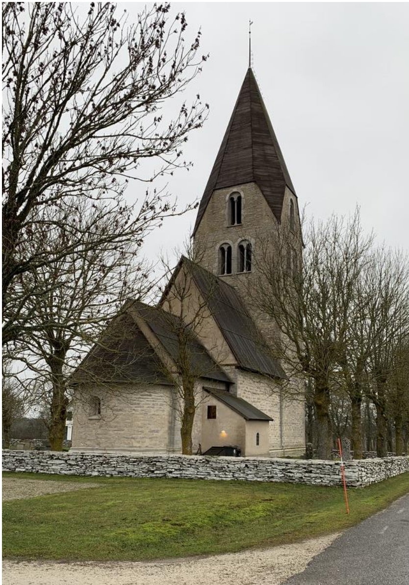
Exteriör från nordöst. Foto JL 2019.
