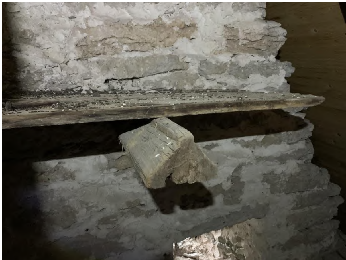
Kvarsittande ställningsvirke (?) i långhusets östra mur. Möjligen del av tidigare taknock. Foto JL 2019.
