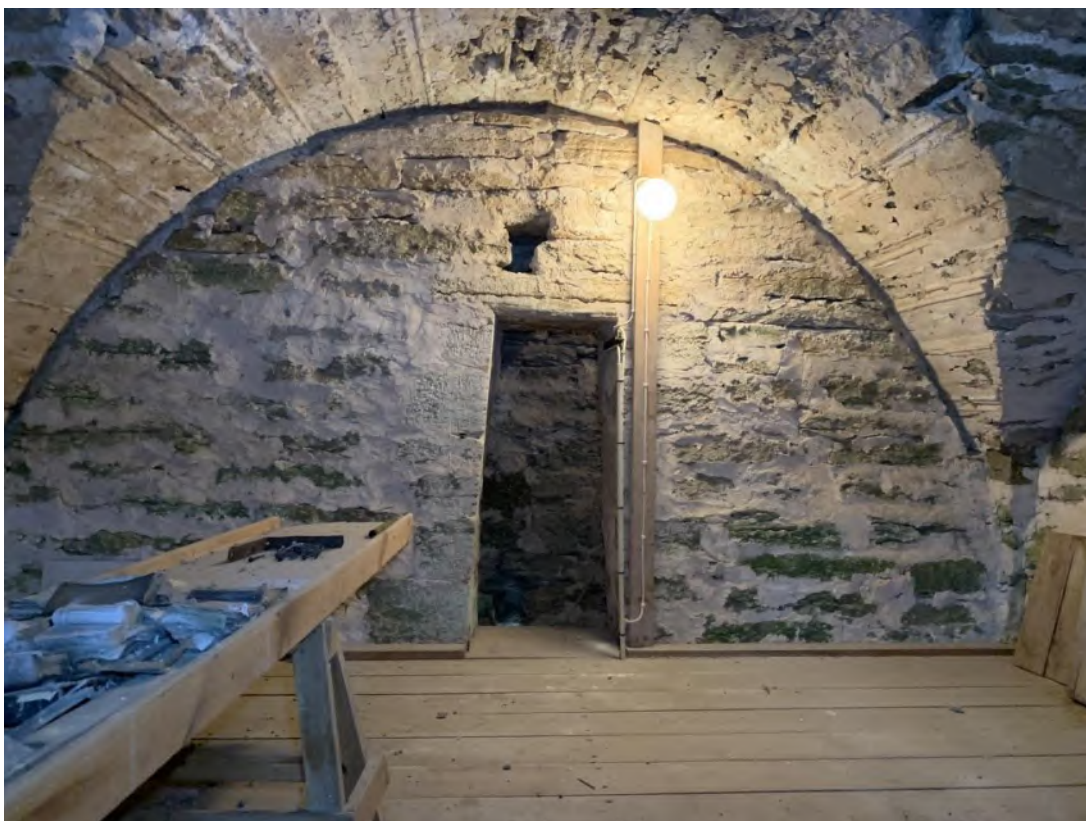
Tornets tredje övervåning, sedd mot norr. Öppningen över dörren är sannolikt ett led i en anordning av hål och genombrytningar för att kunna klämta en klocka nedifrån marken. Foto JL 2019.
