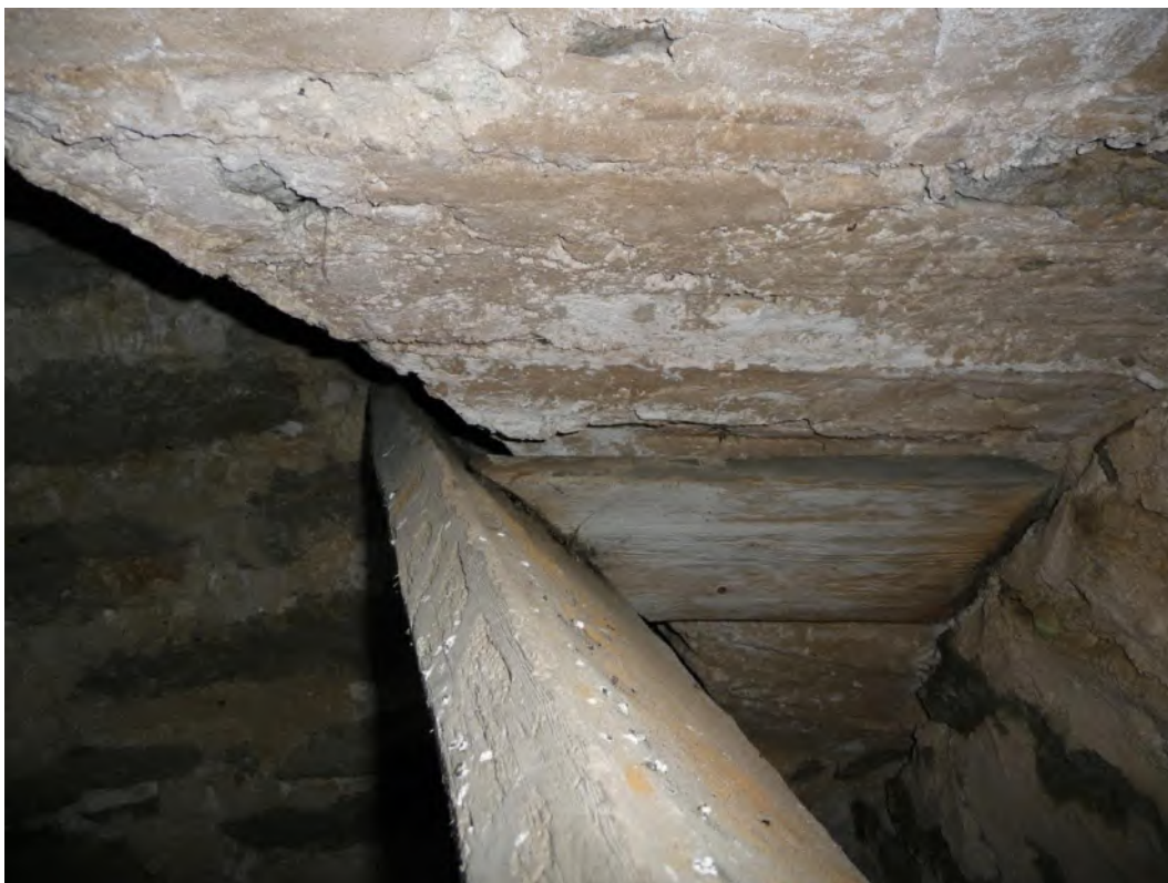
Tornets tredje övervåning. Kvarsittande skälbrädor som visar hur formen för valvslagningen byggdes upp med längre brädor för det längsgående valvet med kortare för de tvärställda valvkapporna. Den hitre brädan har skårer som visar att den tidigare ingått i ett faltak. Foto ES 2019.
