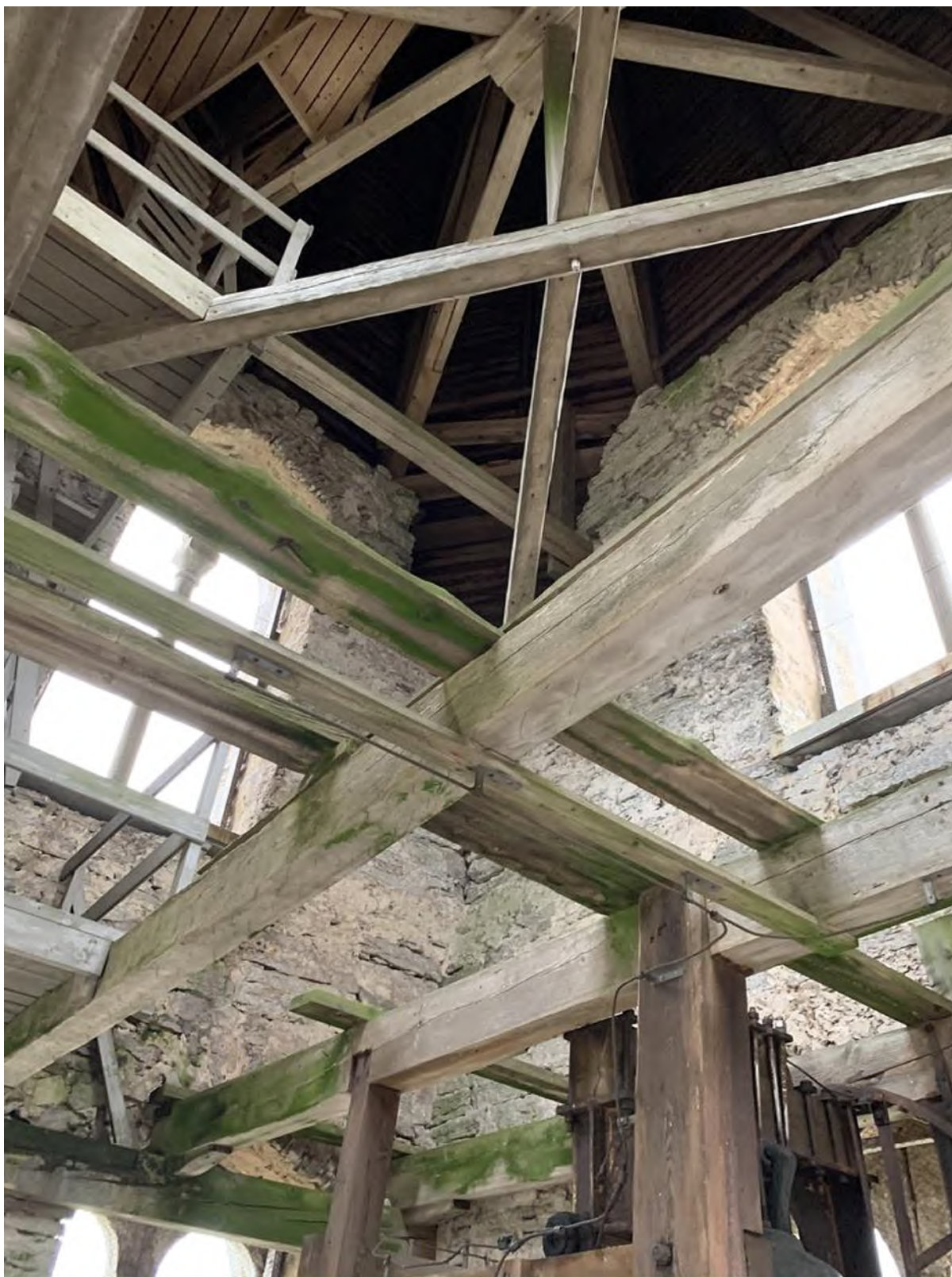
Klockvåningen sedd uppåt mot sydväst. Foto JL 2019.
