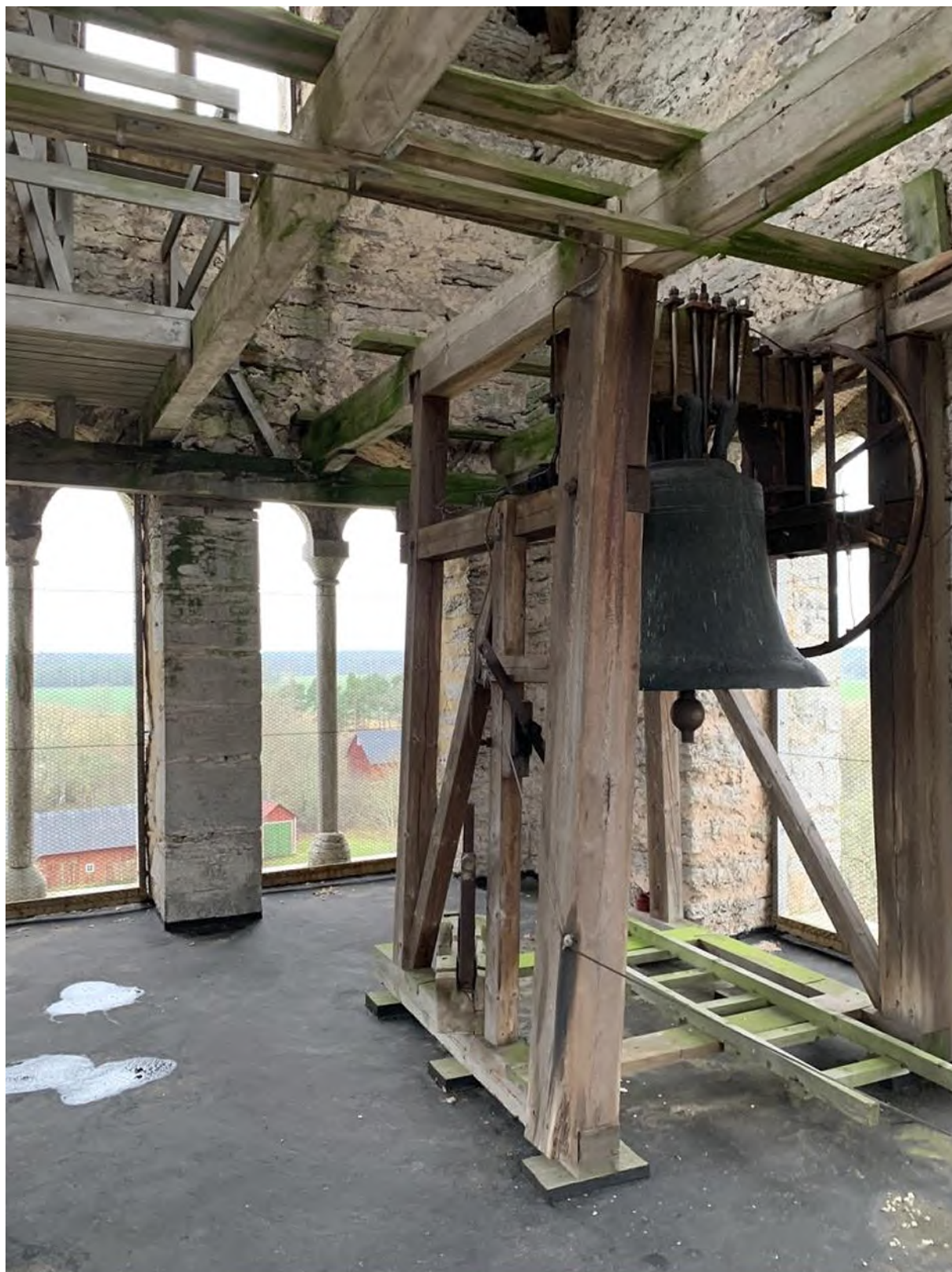
Klockvåningen sedd mot sydväst. Foto JL 2019.
