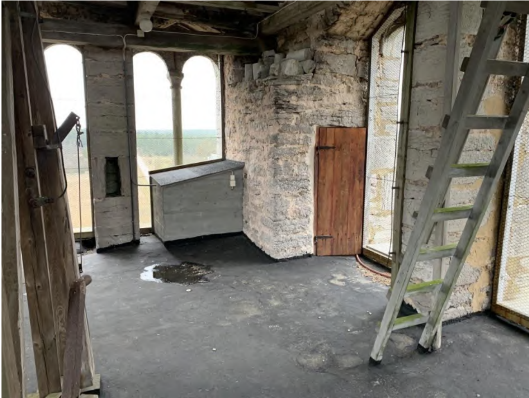
Klockväningen sedd mot nordöst. Dörren är trappans mynning. Trälådan utgör tak för trappan. Observera nischen i pelaren mellan ljudgluggarna mot norr. Foto JL 2019.
