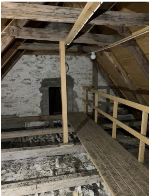
Korets vind, nordöstra hörnet. Takstolens nedre del bearbetad med yxa och har tolkats som avkapad tidigare bindbjälke i en öppen takstol. Korets romerska kryssvalv sett ovanifrån. Valvets sidor är dragna upp högt över korets sidomurar. Foto JL 2019.
