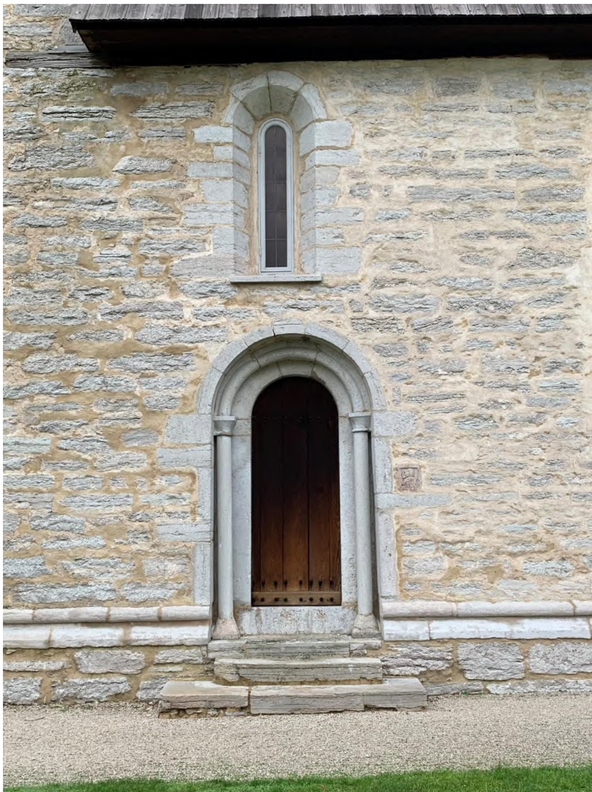
Långhusportalen och det västra av långhusets båda fönster. Foto JL 2019.
