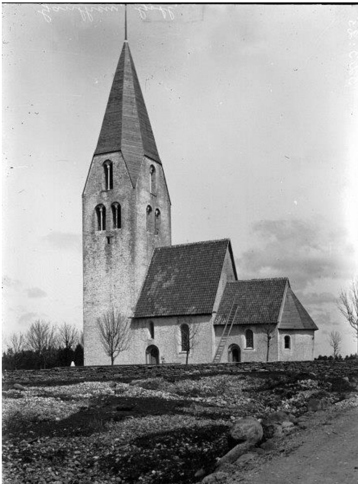
Exteriör från sydöst. Bilden är daterad 1900, men rimligare är att den är från 1902, då den förefaller visa den nya tornhuven som fastställdes i juni 1901. Foto J. W. Hamner. RAÄ, Kulturmiljöbild.
