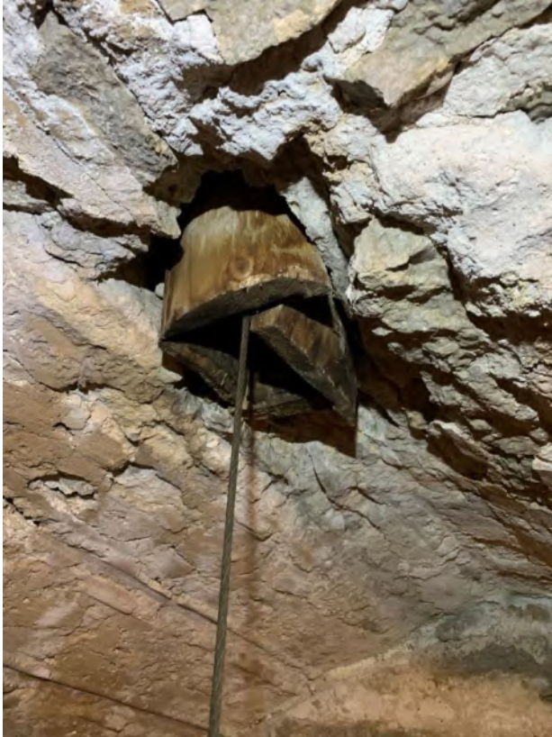
Kvarsittande sturk, träskoningen av hålet genom valvet över tornets tredje övervåning för klockans draglina. Foto JL 2019.
