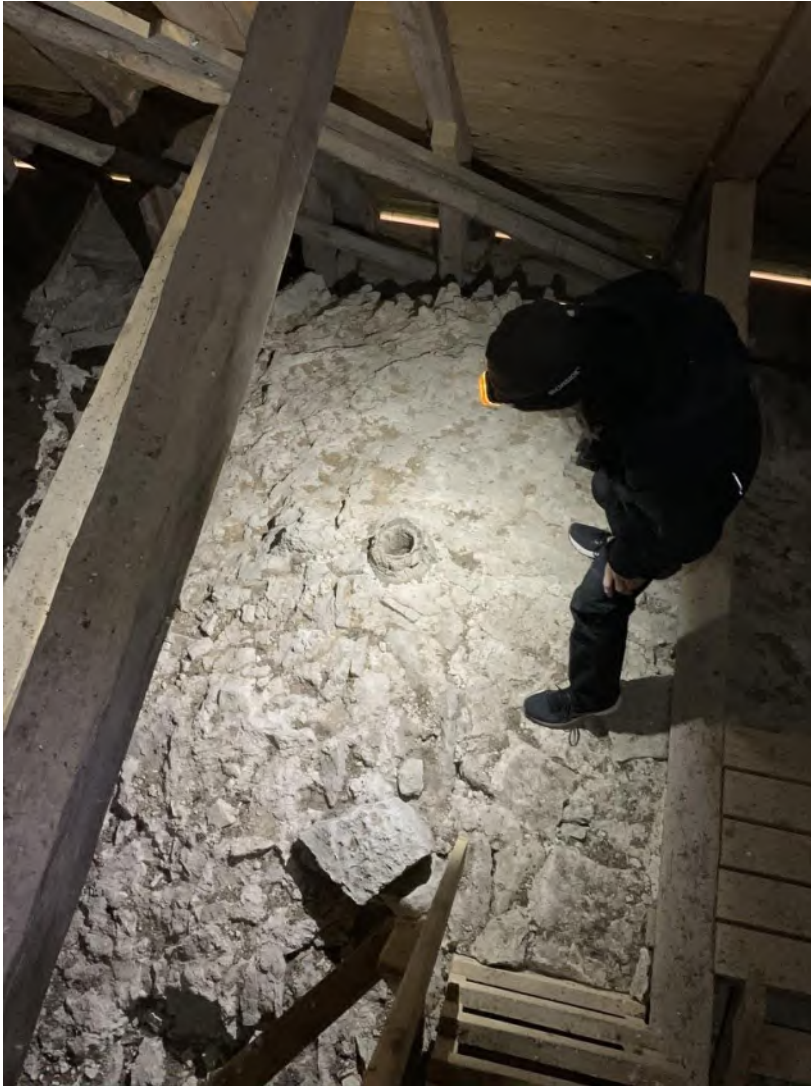
Långhusets nordöstra valv. Trästycke infogat som slutsten i långhusets båda östliga valv. Foto JL 2019.
