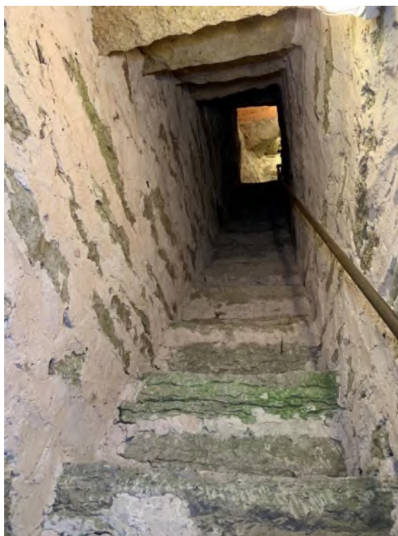
Tornets övre trapplopp, sett uppåt mot öster. Foto JL 2019.
