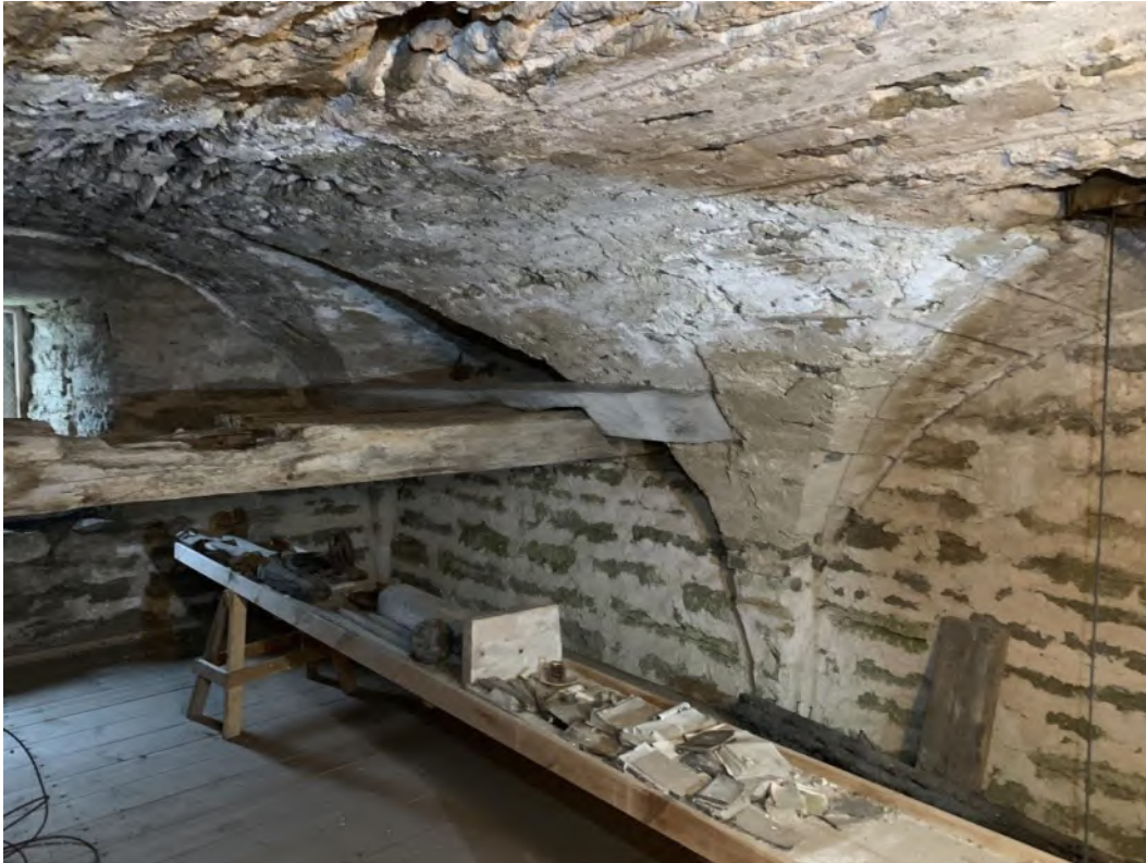
Tornets tredje övervåning sedd mot sydväst med tvärställda valvkappor och en kvarsittande längre skälbräda. Foto JL 2019.
