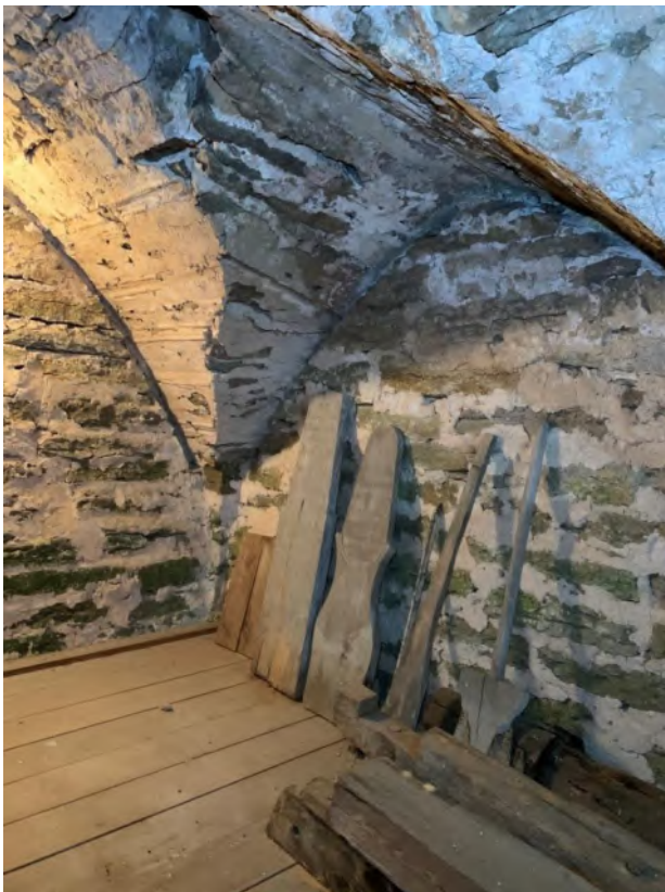
Tornets tredje övervåning, sedd mot nordöst. Gravvårdar av trä från kyrkogården. Av valvet framgår att en mindre konsol förbereddes under murningen av väggarna, medan resten av valvet slogs med en uppbyggd träkonstruktion som underlag. Foto JL 2019.
