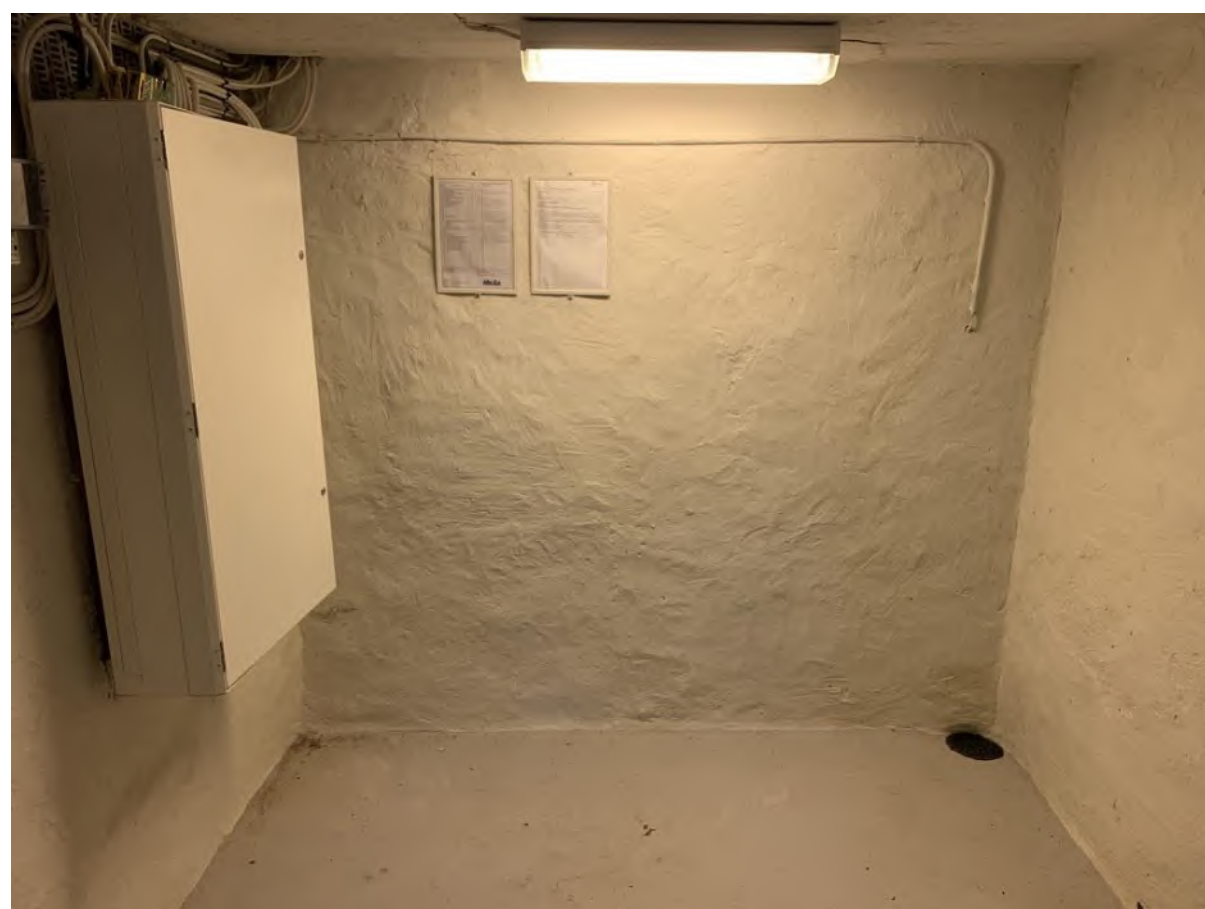
Sakristians källarvåning, tidigare pannrum, mot väster. Foto JL 2019.
