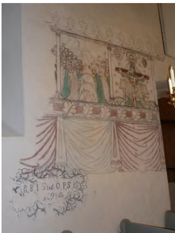
Långhusets södra mur med kalkmålningar från 1400-talet och målad inskrift från 1695. Foto ES 2019.
