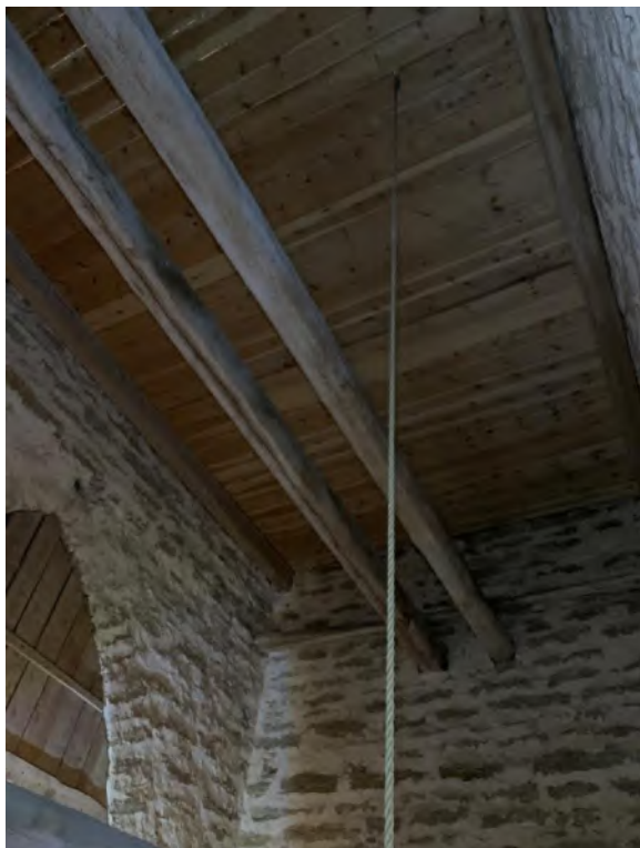
Tornets första övervåning sedd uppåt mot sydöst. Foto JL 2019.
