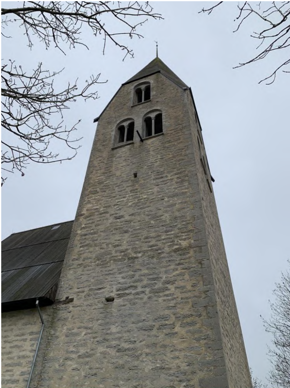
Tornet från nordfasad. Märk långhusets förlängda remstycke. Den rektangulära gluggen nedanför ljudgluggarna har troligen avsetts för ett rep för klämtning i en klocka Foto JL 2019.
