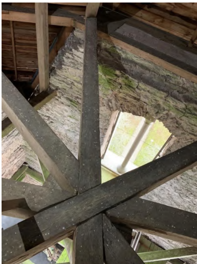
Tornspirans stjärnformade botten samt remstycken som lagts horisontellt på de avskurna torngavlarna. Foto JL 2019.
