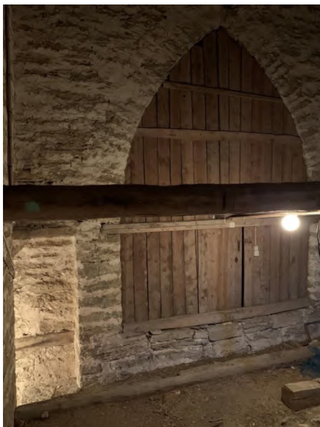
Tornets första övervåning mot öster med trappans mynning och med brädvägg i den stora öppningen mot långhusvinden. Foto JL 2019.
