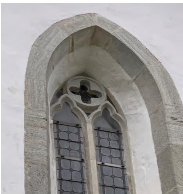
Långhusets södra fönster, masverket. Foto JL 2019.
