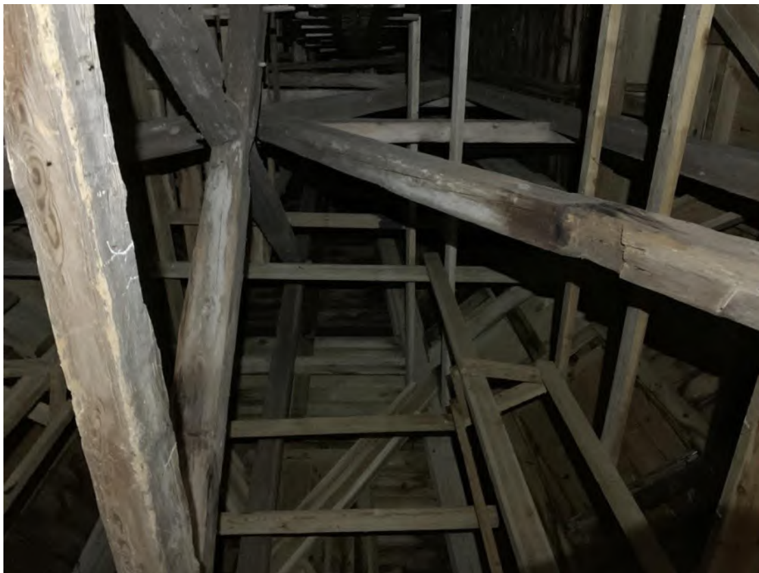
Tornhuvens konstruktion, sedd underifrån. Foto JL 2020.
