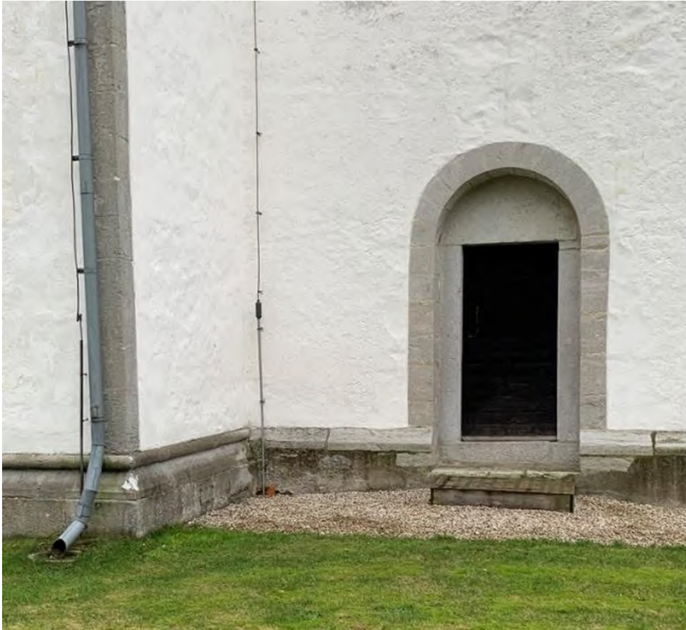
Tornets nordportal. Foto JL 2019.
