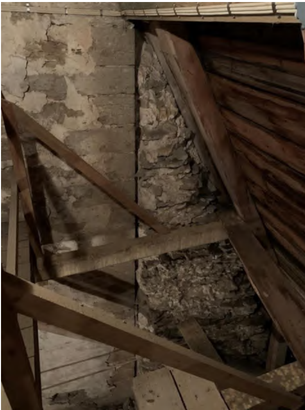
Långhusvindens nordvästra hörn med tornets nordöstra hörn, och till höger fyllnadsmur för långhusets västgavel. Foto JL 2019.
