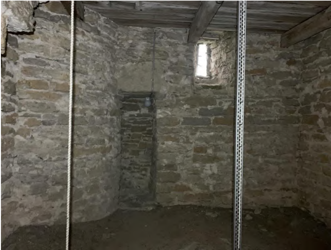
Tornets första övervåning mot väster. Foto JL 2019.
