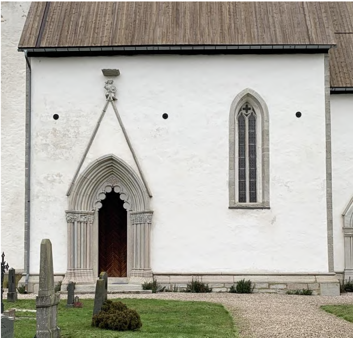
Långhusets södra fasad. Foto JL 2019.
