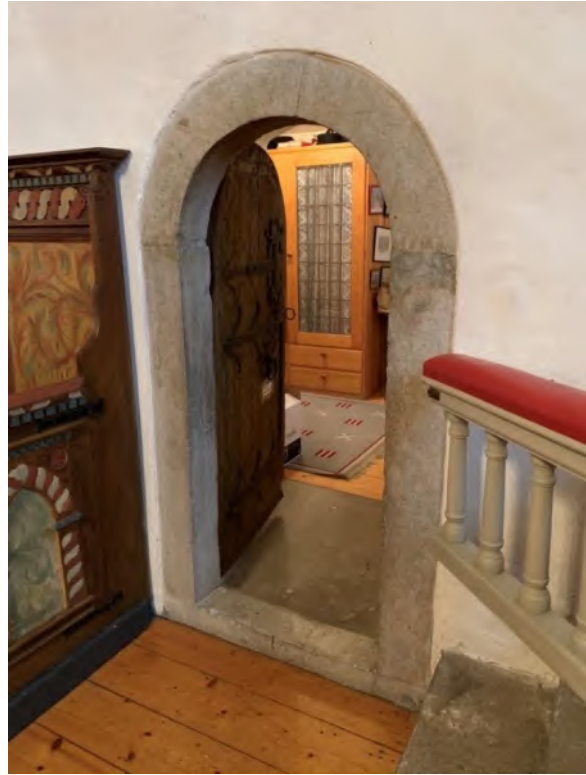
Ingång från koret till sakristian. Dörrbladet återanvänt, från gamla kyrkan och tillverkat i slutet av 1100-talet. Foto JL 2019.
