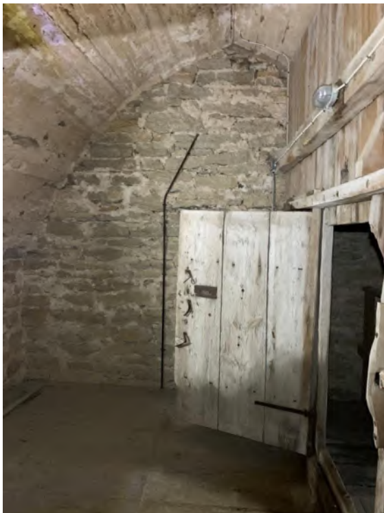
Tornets andra övervåning mot öster. Foto JL 2019.
