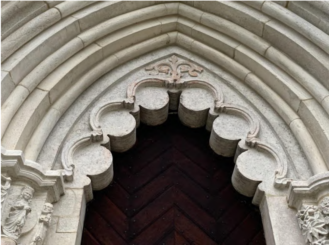
Långhusets sydportal. Tympanonfältet med bevarade färgspår. Foto JL 2019.
