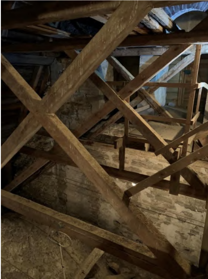
Långhusvindens västra del sedd mot sydväst med tornets östfasad i fonden och de av taket dolda ljudgluggarna. Foto JL 2019.
