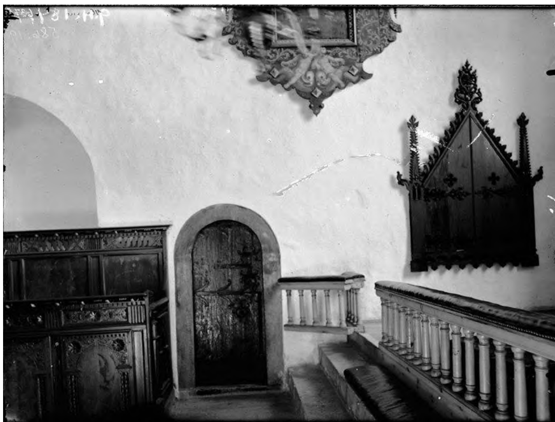
Interiör av koret mot norr. Foto Olof Sörling 1891. RAÄ, Kulturmiljöbild.
