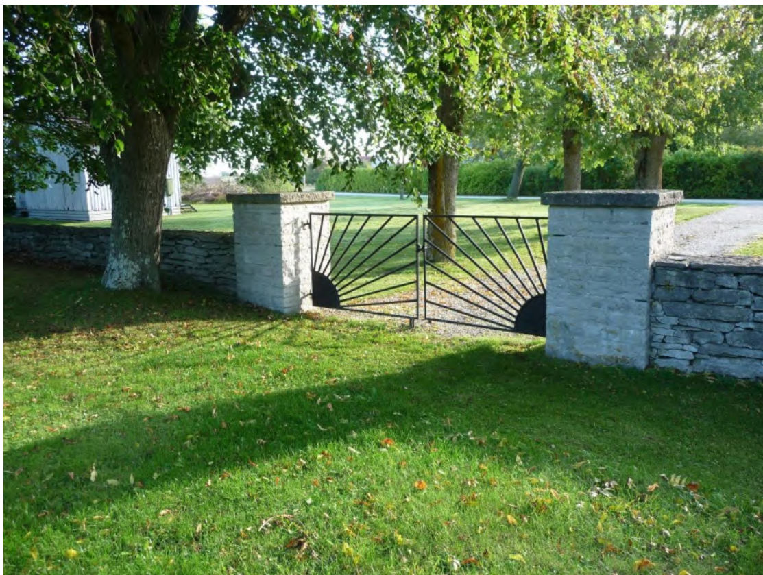
Vid den östra ingången finns en grind i smidesjärn, flankerad av kalkstensstolpar. Foto ES 2019.
