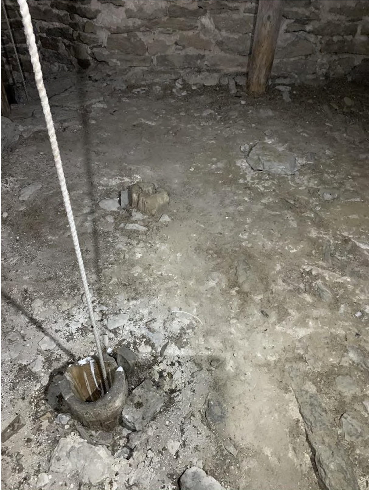
Tornets tredje övervåning. Golvet sett mot väster med sturkar för den nuvarande klocklinan och för en tidigare. Ytterligare hål, troligen för klocklina, under stenen uppe till höger. Foto JL 2019.
