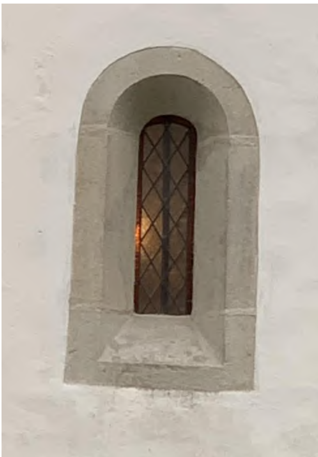
Sakristians östra fönster, troligen återanvänt från den tidigare kyrkans kor. Foto JL 2019.
