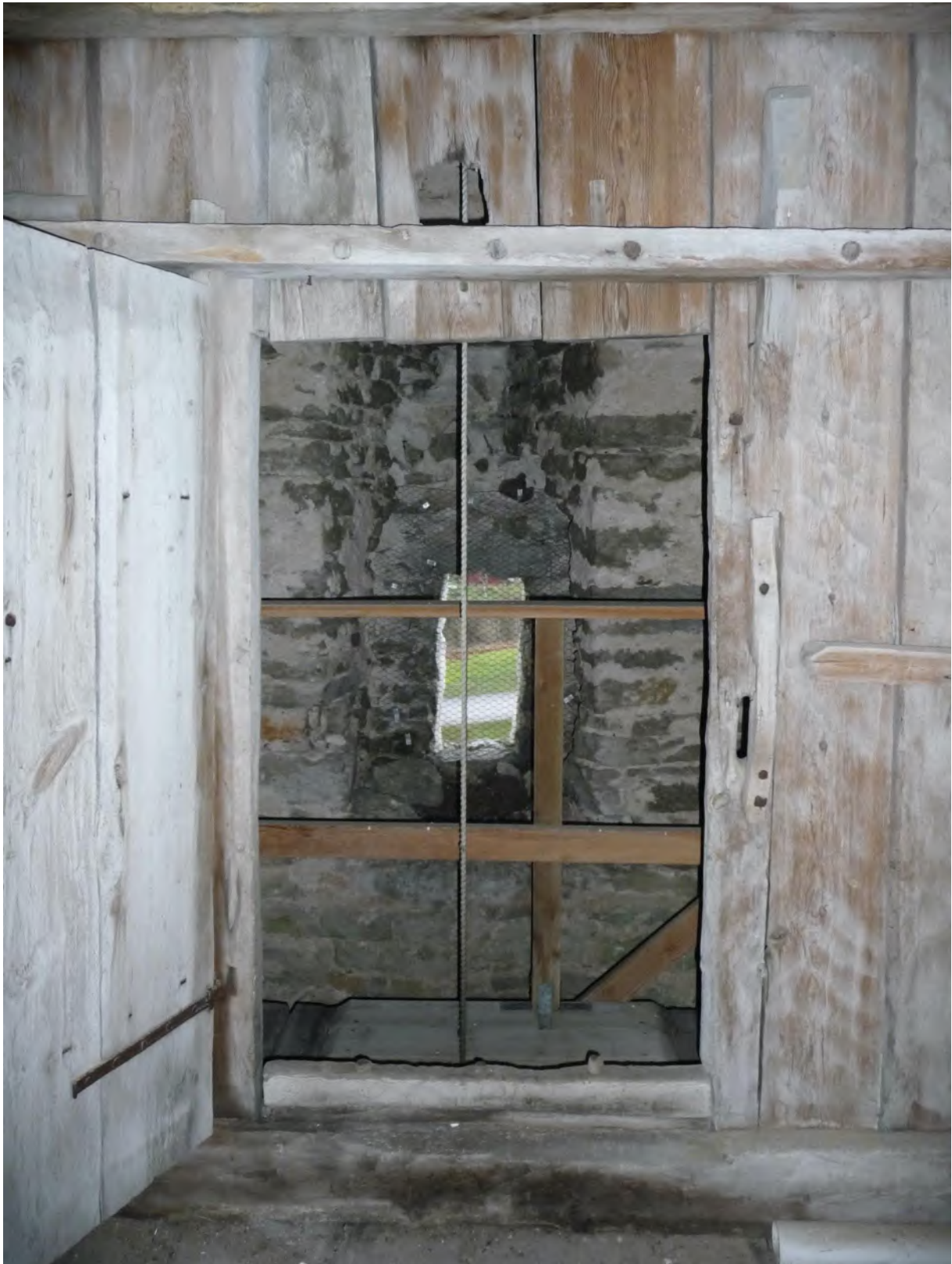
Tornets andra övervåning. Dörr från magasinet, vänd mot glugg i tornets södra mur med nisch som talar för att öppningen varit större och alltså fungerat som lastport. Foto ES 2019.
