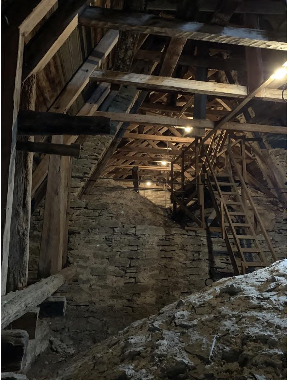
Korets vind sedd mot väster med öppning till långhusvinden. Foto JL 2019.
