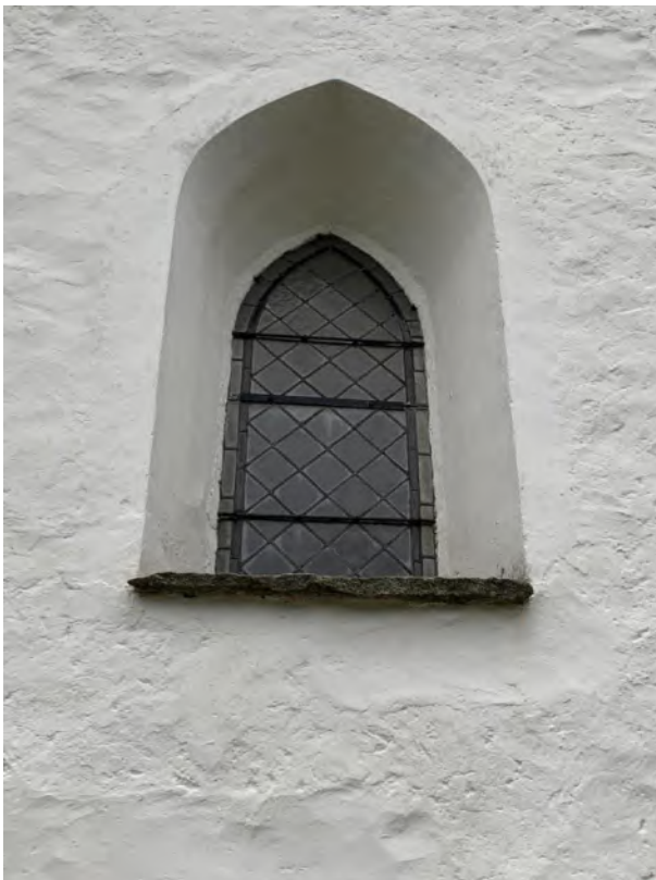
Tornets västra fönster. Foto JL 2019.
