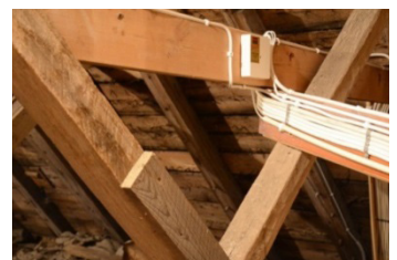
Kabeldragning. Foto: Robin Gullbrandsson
