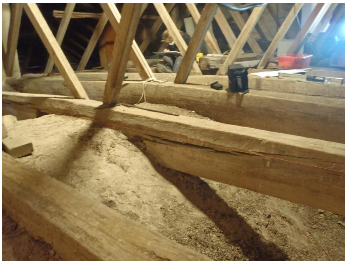
Forshems kyrka, takstolarnas bindbjälkar är urtagna för valvkapporna, foto K. Linscott 2012
