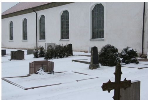
Bild 3. Placering av luftvärmepump utomhusdel, nordvästra sidan.
