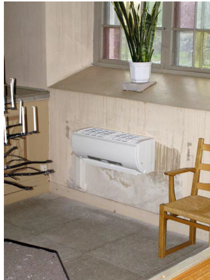
Bild 2. Installation av luftvärmepump kor, sydöstra sidan.
