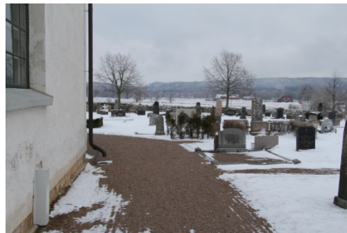
Bild 4. Placering av luftvärmepump utomhusdel, sydöstra sidan.
