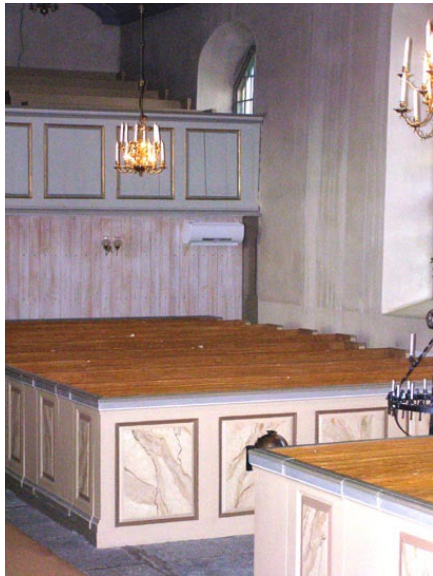
Bild 1. Installation av luftvärmepump långhus, nordvästra sidan.
