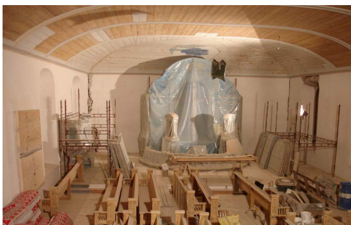
Örslösa kyrka under renovering 2005.
