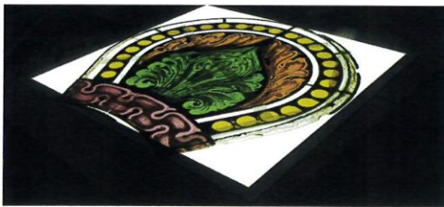
Ett demonterat fönster inför restaurering. Vid kanterna finns skador efter infästning.
