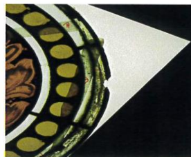
Fönster där kantblyet och delar av glaset skadats vid monteringen.
