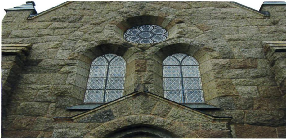
Det färdigställda, södra transeptets övre fönster.
