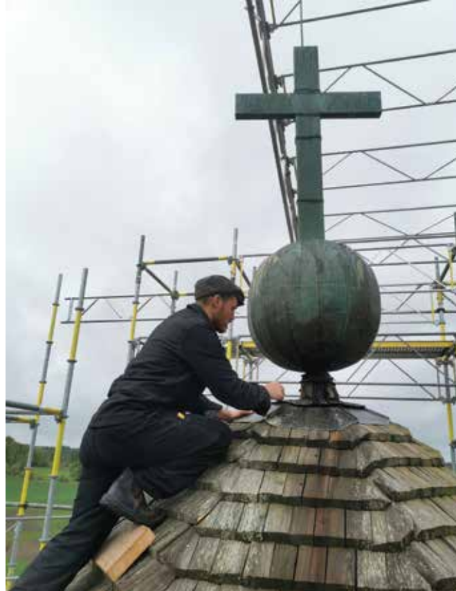
Första gången på ställningen. Timmerman Simon Sköld undersöker konstruktionen inför nedmonteringen. Klotet visade sig vara i gott skick men av träet i korset återstår mest smulor.
