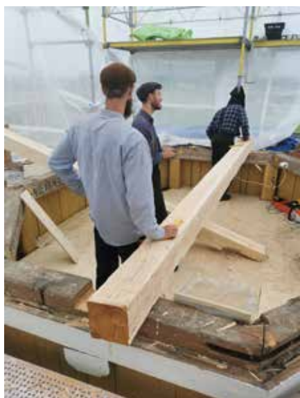
Taket är nedmonterat och nya bjälkar sågas till
