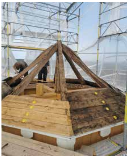
Återmontering. Det mesta går att återanvända och är nog uppmärkt för att hamna rätt.
