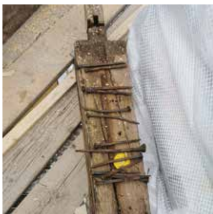
Hjärtstocken i ek går att återanvända. Spikarna riktas, rostskyddsbehandlas och återanvänds.
