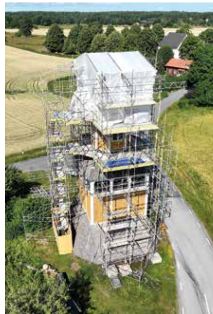
En ordentlig byggställning gör att arbetena kan genomföras på ett bra och säkert sätt.
