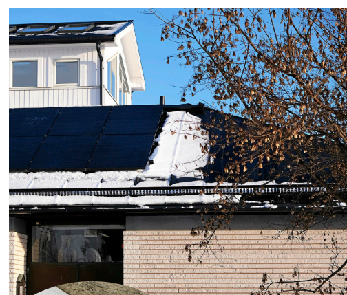
Solpanelerna på taket sköter sig själva och på mätare i källaren kan Bert Isaksson se hur det produceras solel.
