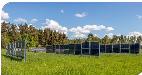
BENGT STRIDH, MÄLARDALENS UNIVERSITET driver vid Kärbo Prästgård utanför Västerås ett forskningsprojekt med vertikalt ställda paneler som samsas med vallodling. Tekniken kallas för Agrivoltaics. Forskningsprojektet drivs av Mälardalens universitet och ska genom 40 olika mätpunkter utvärdera solelproduktionen och odlingsresultaten från anläggningen. Foto/källa: Bengt Stridh, Mälardalens Universitet
