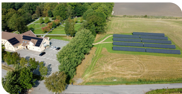
SOLPARKEN INTILL VÄRÖ församlingshem omfattar 740 m 2 solpaneler med en sammanlagd effekt på 150 kW som årligen genererar cirka 160 500 kWh el. Anläggningen färdigställdes januari 2021 och beräknas ha en återbetalningstid på 7,9 år. Foto: Anders Karlsson, Värö-Stråvalla församling
