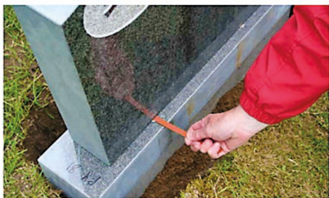
Dubbarna mellan livstenen och sockeln kontrolleras med hjälp av ett bågflisblad.
