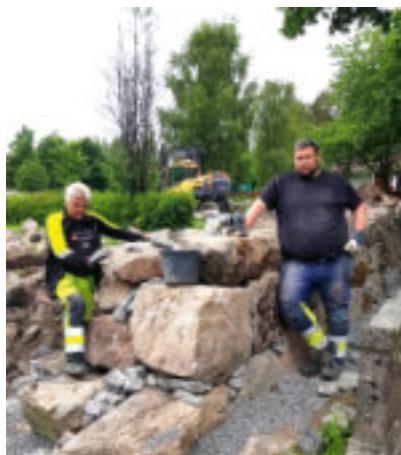
Erik och Robert har lagt om murarna i Tensta. Helt fantastiskt skickliga! Även trappan vid kyrkan behövde läggas om på grund av att frost och tjälsprängning har fört med sig förskjutning.
