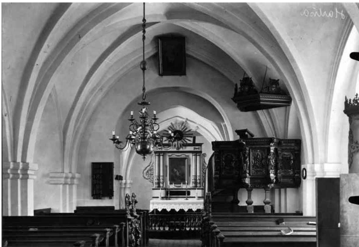
Kyrkorummet mot koret. Bilden kan möjligen vara tagen i samband med att Einar Lundberg upprättar ett restaureringsförslag 1926. Predikstolen har ännu inte sänkts och bänkinredning och altarring är ekådrade. Foto: Okänd. Bilden hämtad från Riksantikvarieämbetets bilddata-bas Kulturmiljöbild.
