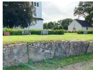
Mur i norr
