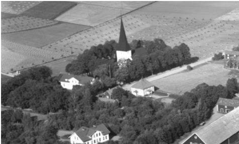
1930-talet, flygfoto från sydväst. På bilden syns den äldre kyrkogården med en tät trädkrans. Kring det nya kyrkogårdsområdet syns anlagda gångar, gräsytor och en nyplanterad trädkrans (Kringla.nu).
