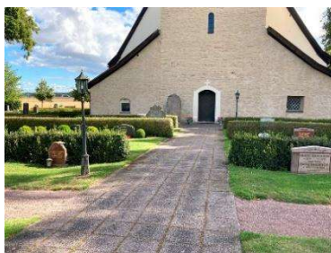
Gång med betongplattor mot kyrkan
