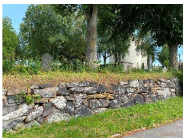
Mur mot sydväst
