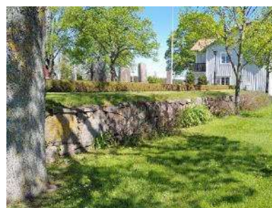
Mur mot söder
