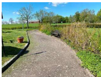
Asfaltgång i nya delen
