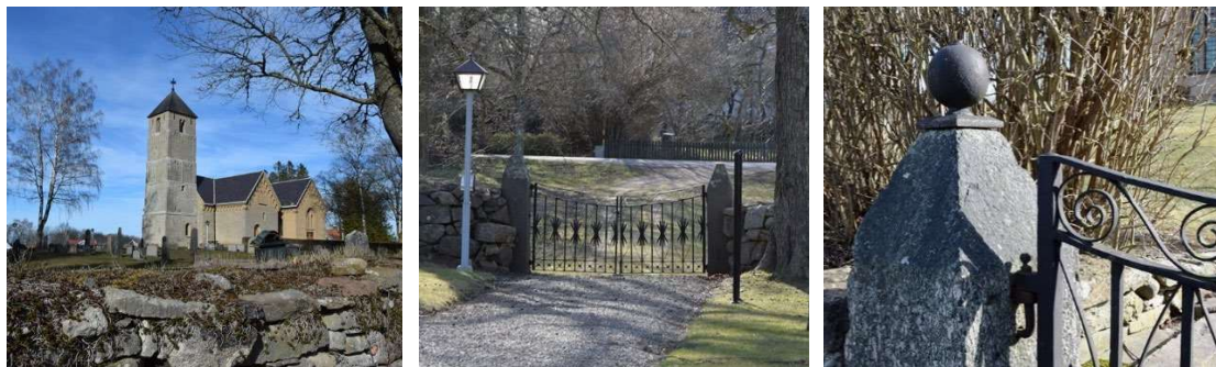
Den omgärdande muren i söder (t v), muren i väster tillsammans med den västra ingången (mitten) samt en grindstolpe vid norra ingången (t v).
