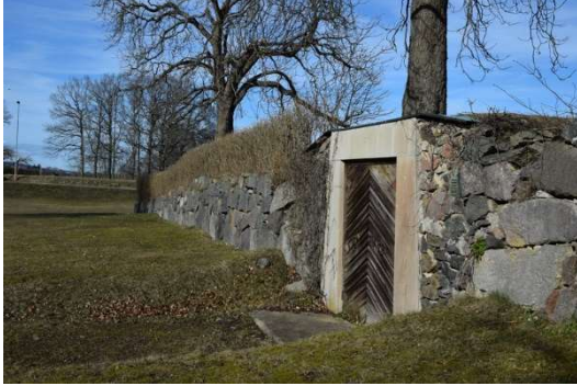
Bisättningsrummet i västra muren.
