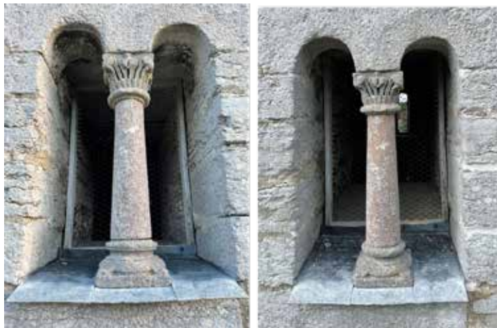
Dekorativ kolonn på södra tornfasaden. Till vänster ses ljusöppningen före konservering och till höger efter att begynnande krusbildning avlägsnats i bågarna, sprickbildningar i omfattningarna lagats och fogar kompletterats. Foto Rebeca Kettunen, 2022.
