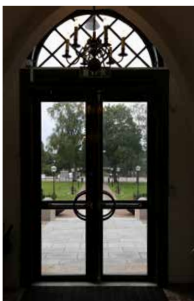
Glasdörrar i den nya entrén i Tranemo kyrka
