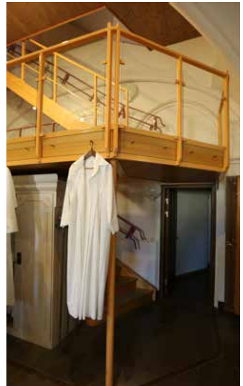
Stålkonstruktion i Linköpings domkyrkas sakristia. Inspiration till förvaring i S:t Nikolai vapenhus.
