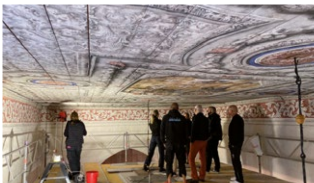
Målerikonservatorer i arbete med renovering av det unika innertaket. Foto: Anna Plahn.
