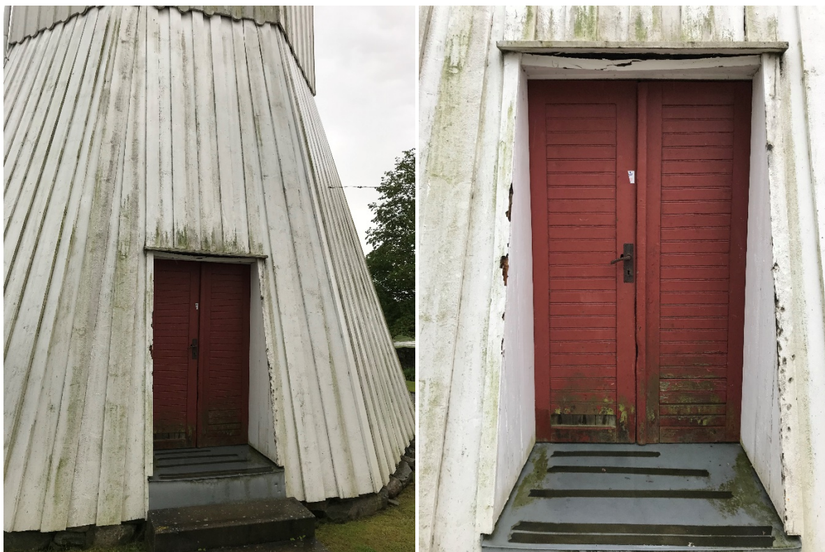
Undre fasaden innan reparation. Mycket algpåväxt på den sågade ytan. Rötskador på dörr och omfattning.
