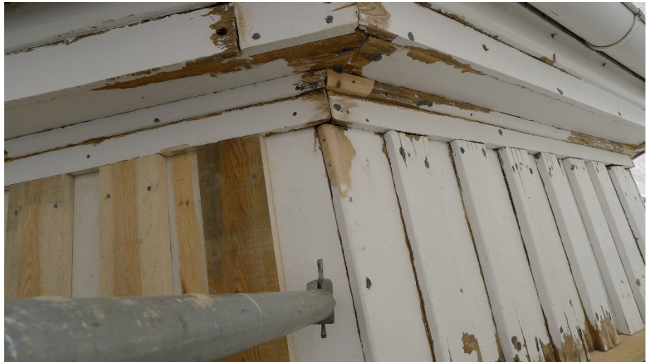
Mindre lagning takfot.
