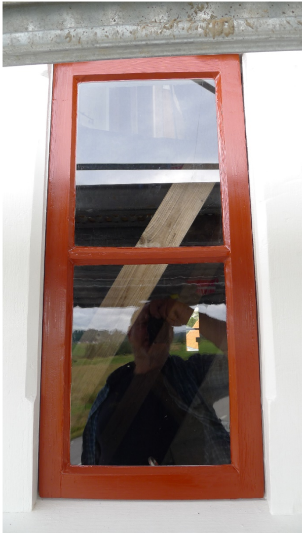
Fönster färdigmålade, återmonterat och justerat för luftning under.
