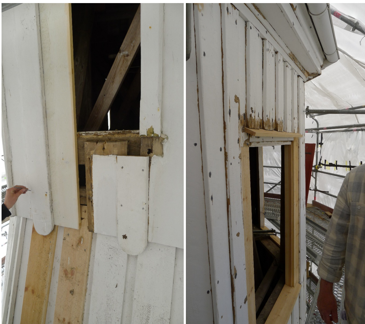
Övre delen av fasad. Återmontering panel samt byte skadade delar. Fasad avvärmd och uppskrapad. Rostande spikskallar grundmålade.
