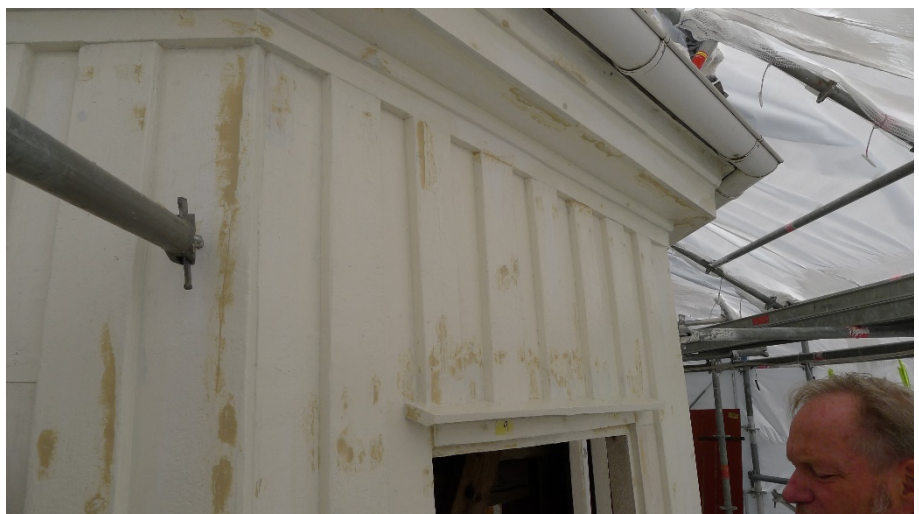
Fasad grundmålad och kittlagad.
