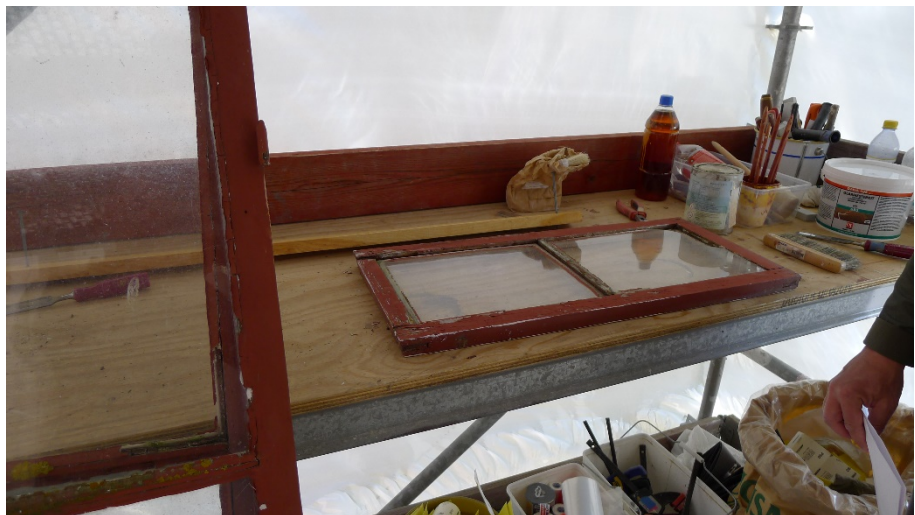
Fönster under arbete.
