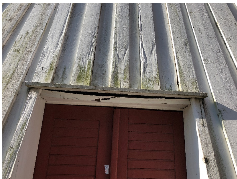
Undre fasaden innan reparation. Mycket algpåväxt på den sågade ytan. Rötskador på dörr och omfattning.
