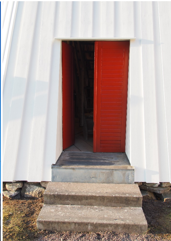
Reparerad dörr och smyg.
