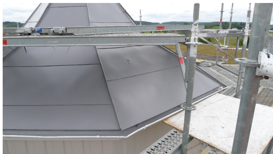
Plåttaket färdigmålat. Hänggrännen rostskyddsmålad och målad med takfärg inuti.
