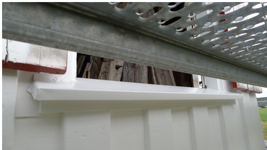
Fönster färdigmålade, återmonterat och justerat för luftning under.
