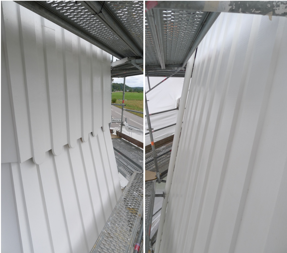
Den undre fasaden färdigställd.
