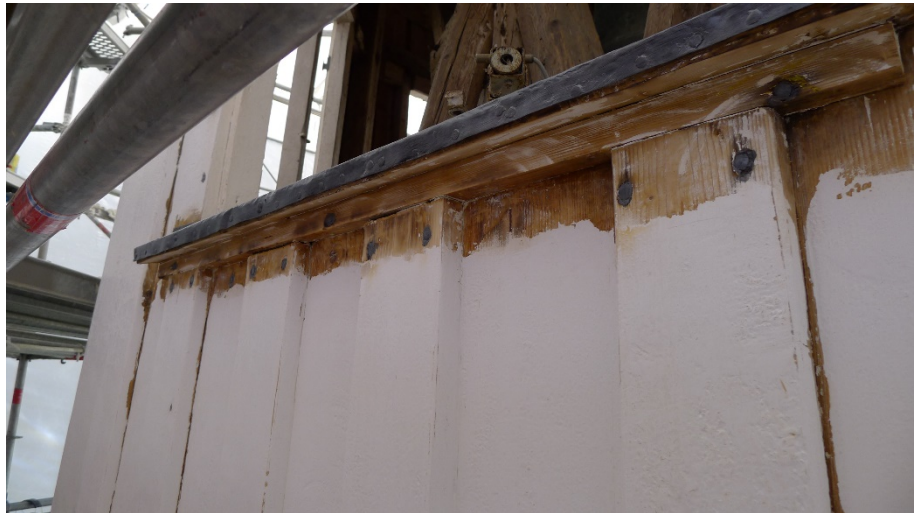
Äldre plåt renskrapad och grundmålad.
