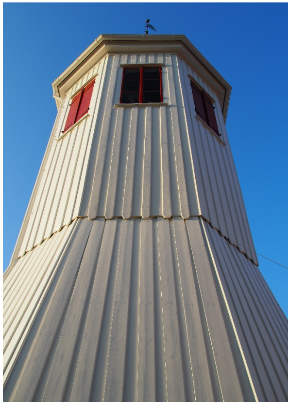
Fasad och fönster.
