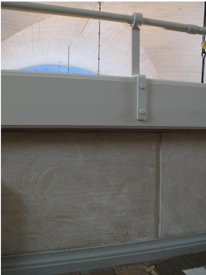
Bilden ovan visar takets dekormålning över läktaren och kyrkorummet i form av laserande blå färg som strukits över en bruten vit kulör. Bilden till vänster insidan på läktarbarriären som dekormålats på liknande vis.
