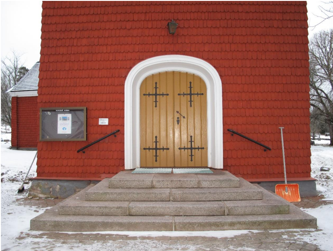
Västra entrén till vapenhuset gjordes om i samband med restaureringen 1952. Räckena är senare tillkomna.
