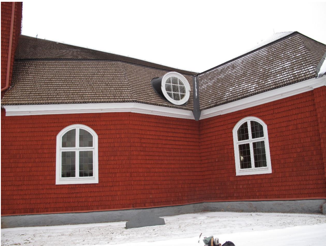
Fönstren får sin nuvarande utformning samt förses med blyspröjsat antikglas i samband med restaureringen 1952. Det runda fönstret är från 1700-talet.
