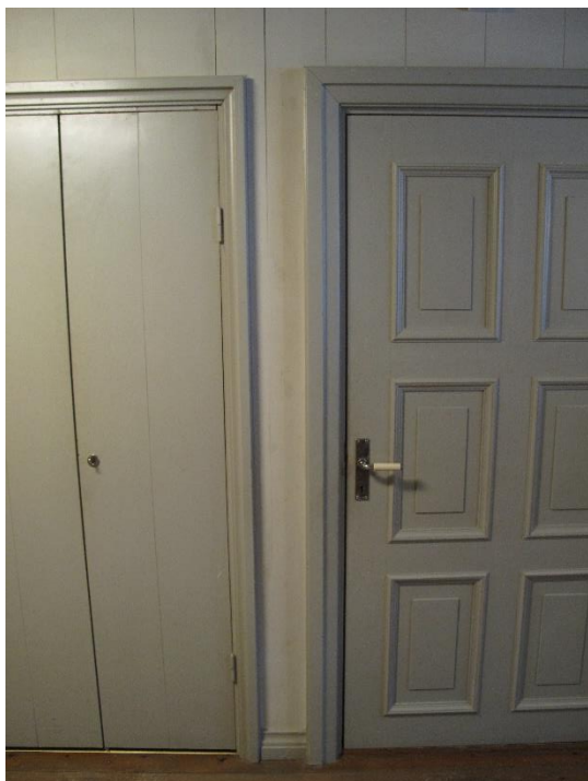
Dörr till entré samt skåpinredning med ursprungliga foder och beslag.
