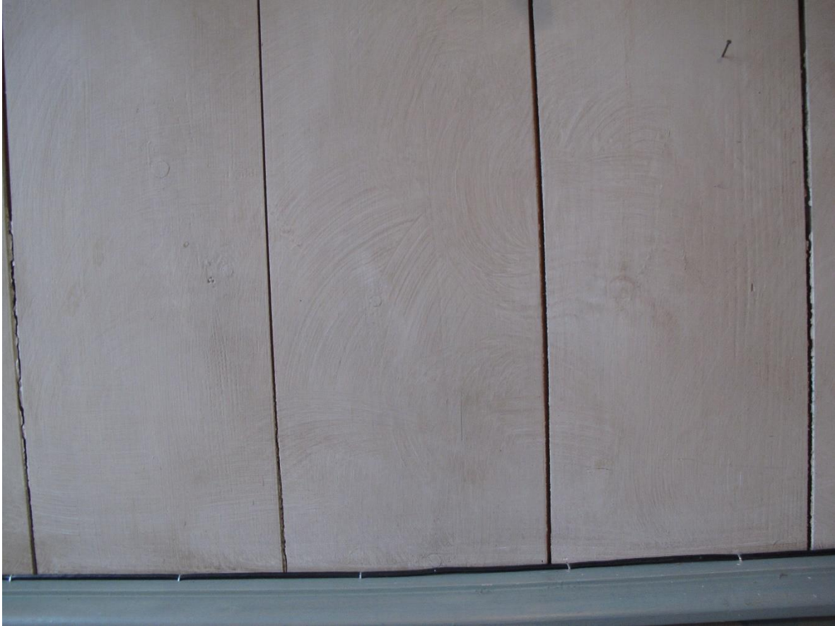
Bilden visar ytbehandling av kyrkorummets väggpanel ovan bröstpanel. Väggarna är målade och laserade, ljus bottenfärg med en ljusbrun lasyr. Man kan tydligt se den medvetna penselföringen. Bild nedan, laserad golvsockel, tillkom troligtvis 1952.
