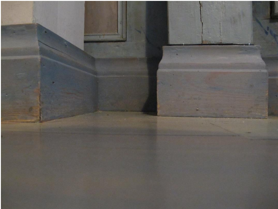
Bilden visar ytbehandling av kyrkorummets väggpanel ovan bröstpanel. Väggarna är målade och laserade, ljus bottenfärg med en ljusbrun lasyr. Man kan tydligt se den medvetna penselföringen. Bild nedan, laserad golvsockel, tillkom troligtvis 1952.
