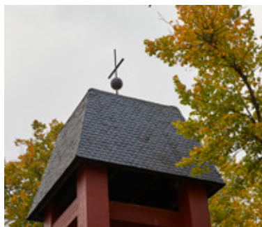
Kolsva Brukskyrka, sedd från söder. Byggnadsdelen är senare tillbyggd. Ovan en detaljbild på klocktornet.
