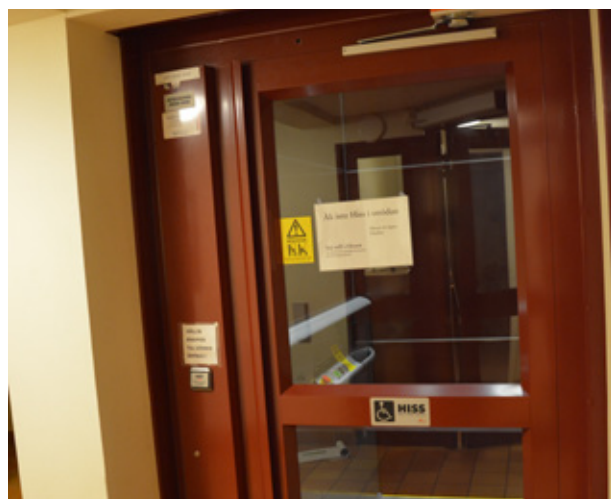
Dörr till hiss i trapphus. Vlm_modkaEK-668.
