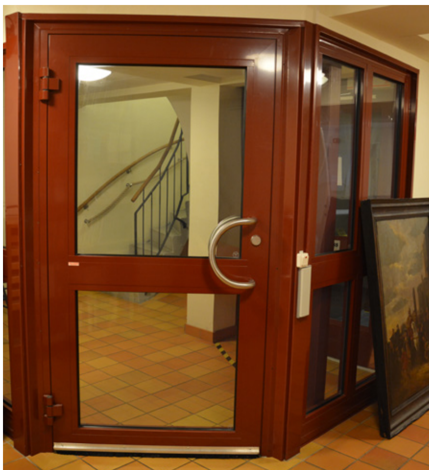
Dörrparti till trapphus, golv av Höganäsklinker. Vlm_modkaEK-527.
