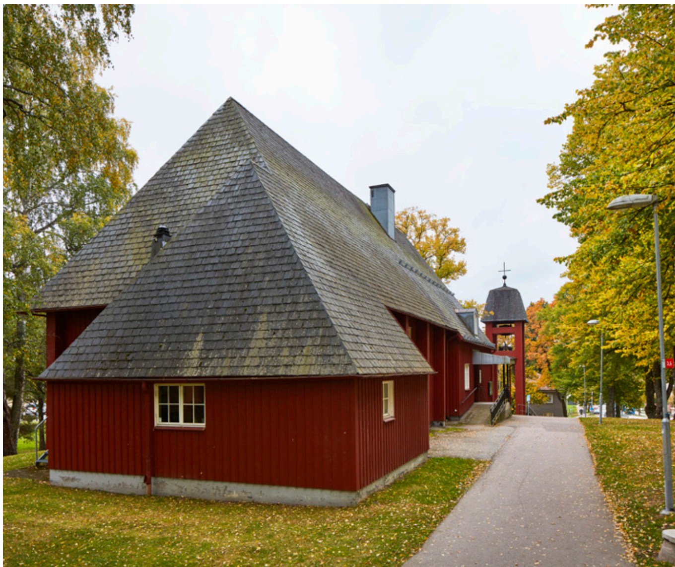
Löv- och barrträd på tomten och asfalterad gångväg, vy från väster.
