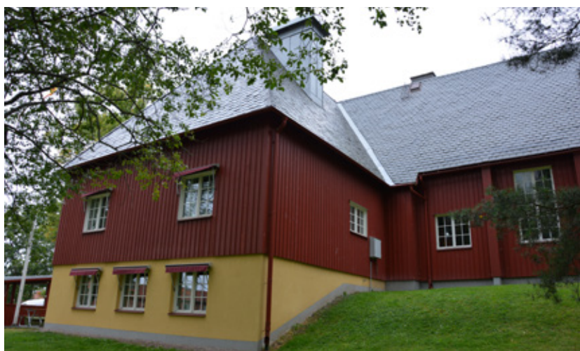
Kyrkobyggnaden i souterräng från söder. Byggnadsdelen med källare är senare tillbyggd. Vlm_modkaEHW-574.
