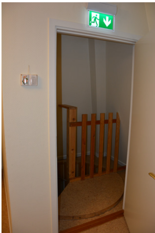
Dörr in till trapphus 205. Vlm_modkaEHW-541.
