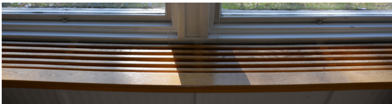
Radiatorer med träinklädnad i rum 113. Vlm-modkaVB-1033.
