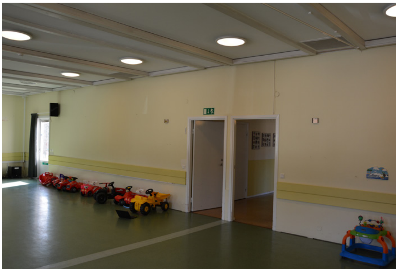
Leksal sedd mot korridor. Grön linoleummatta och ljusgulmålade väggar. Vlm-modkaVB-915.
