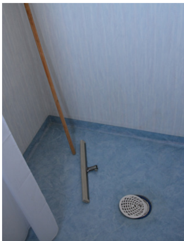
WC, rum 106 med blå plastmatta samt armatur med opalglas. Vlm-modkaVB-976.
