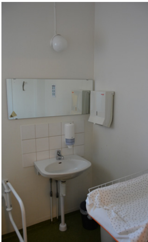
WC, rum 109 med grön plastmatta samt armatur med opalglas. Vlm-modkaVB-972.
