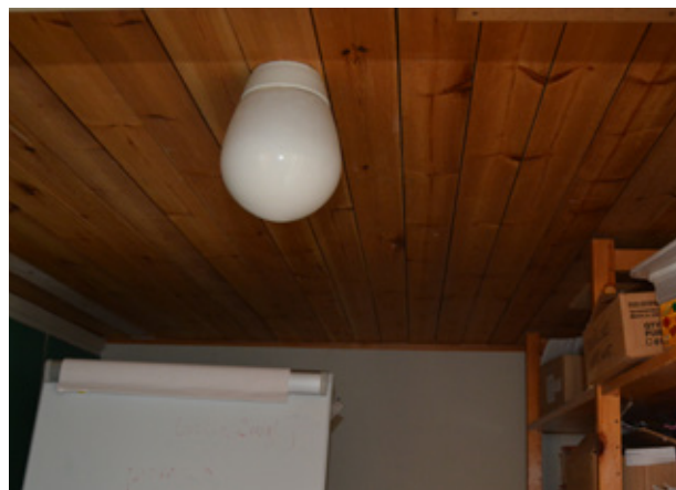
Armatyr med kupa av opalglas och tak av träpanel i förråd 121. Vlm-modkaVB-967.
