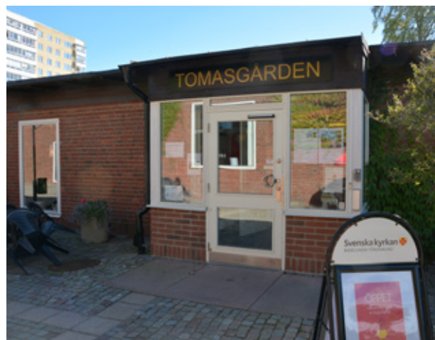
Ingång till södra flygel. Vlm_modkaEK-2831
