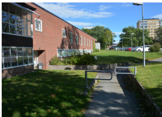
Gångvägar in till södra flygelbyggnaden. Vlm_modkaEK-2855.
