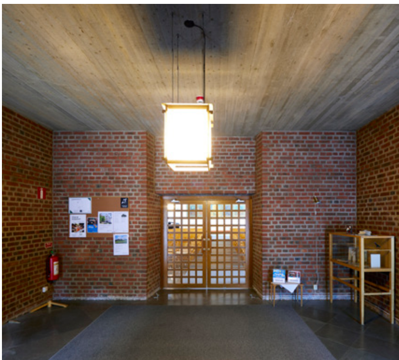
Omålat innertak i betong.
