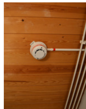
Kalkstengolv i toalett. Vlm_modkaEK-1895. Tak av gran och rökdetektor. Vlm_modkaEK-1899.
