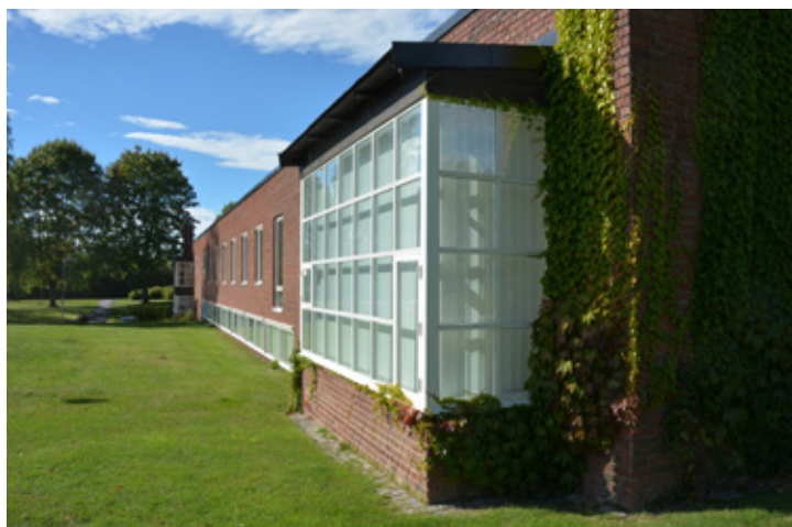
Burspråk på södra flygel. Vlm_modkaEK-2847.
