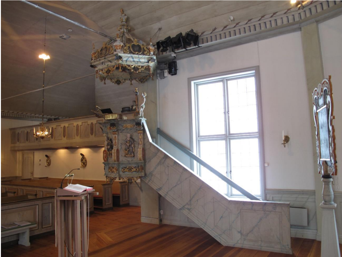
Ny barriär till predikstolen vid restaureringen 1958-59. I samband med restaureringen skrapades äldre färgskikt fram för att utgöra grunden för färgsättningen.
