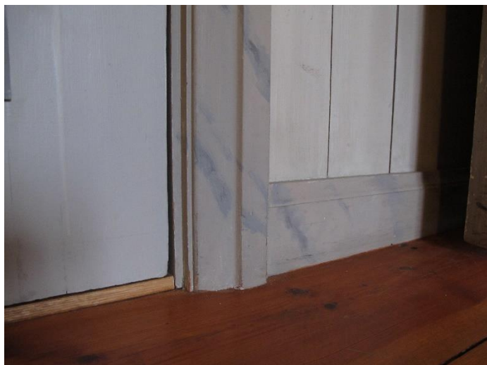
Inre läktarunderbyggnad som tillkom vid restaureringen 1958-59. Detaljbild av marmorerad golvlister samt dörrfoder.
