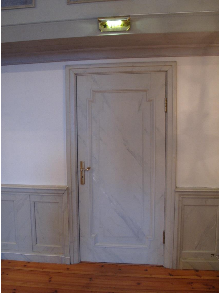
Marmorerad dörr och bröstningspanel. Dörrens spegel har fått sin utformning från den äldre läktarbarriären.
