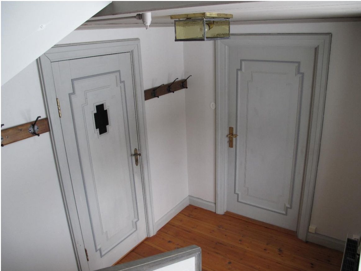
Dörrar till skrudkammare och kyrkorum samt armatur av blyinfattat antikglas.
