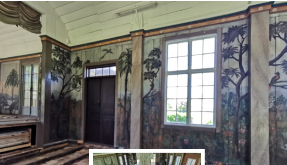
Vänster Brunnssalongen renoveras för fullt. Här syns några av de vackra målningarna som pryder väggarna.
