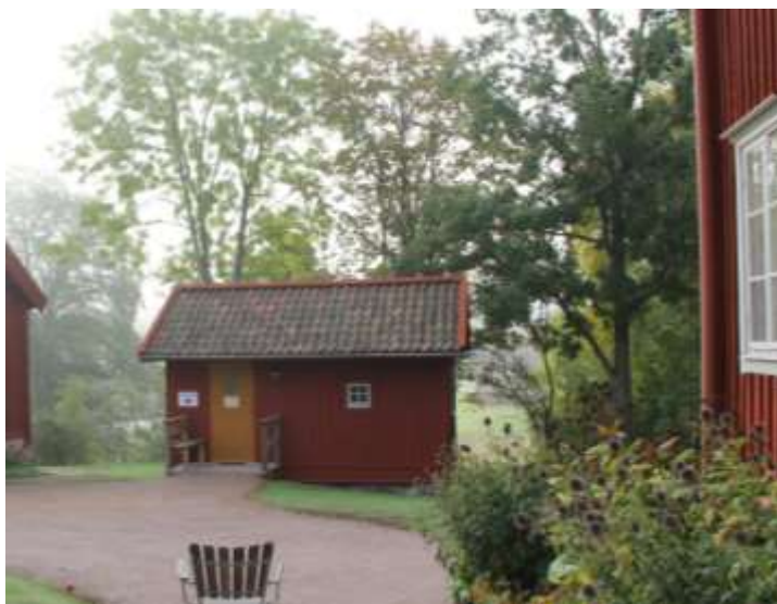
Bild 63. Det nybyggda dusch- och toaletthuset.
