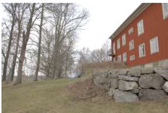
Bild 61. Stenmuren bakom stora huset med jordkällaren.
