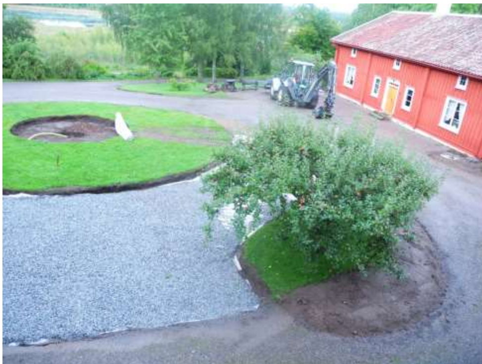
Bild 41. Gårdsplanen under arbete.
